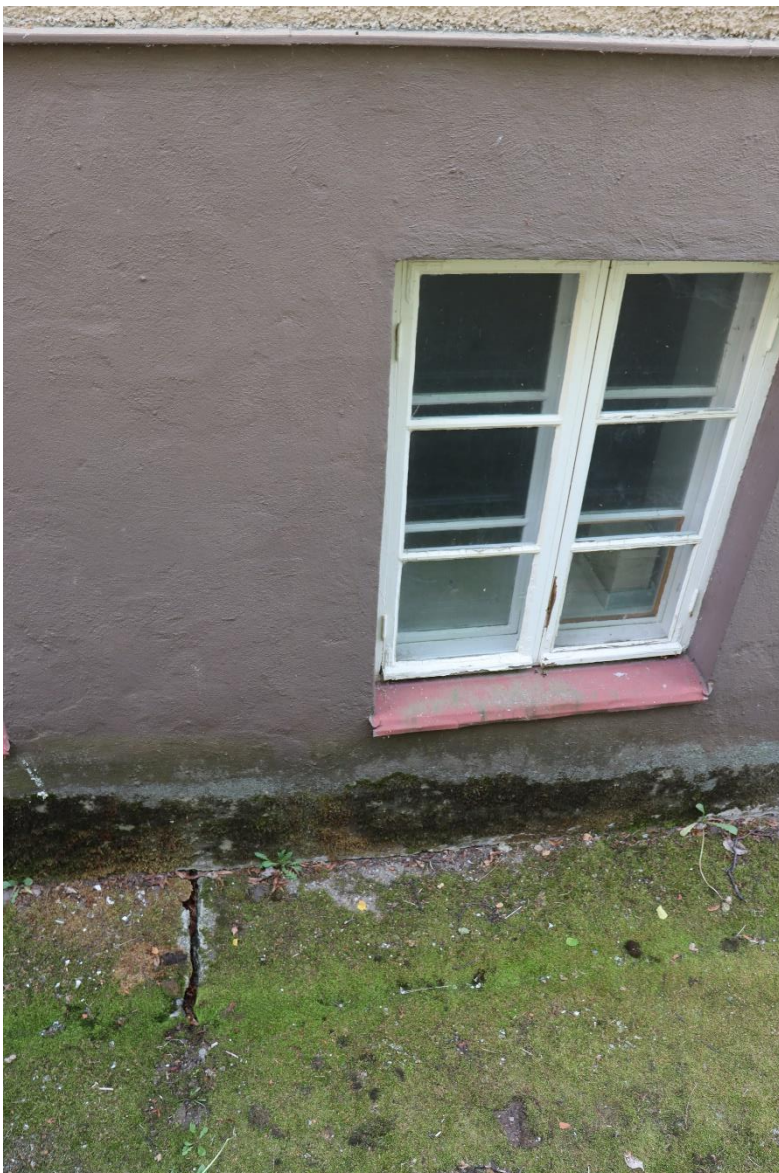
Kuva 9. Kuivahoitolarakennuksen ulkoseinustaa vierailukäynnillä (Nousiainen 2020b)
