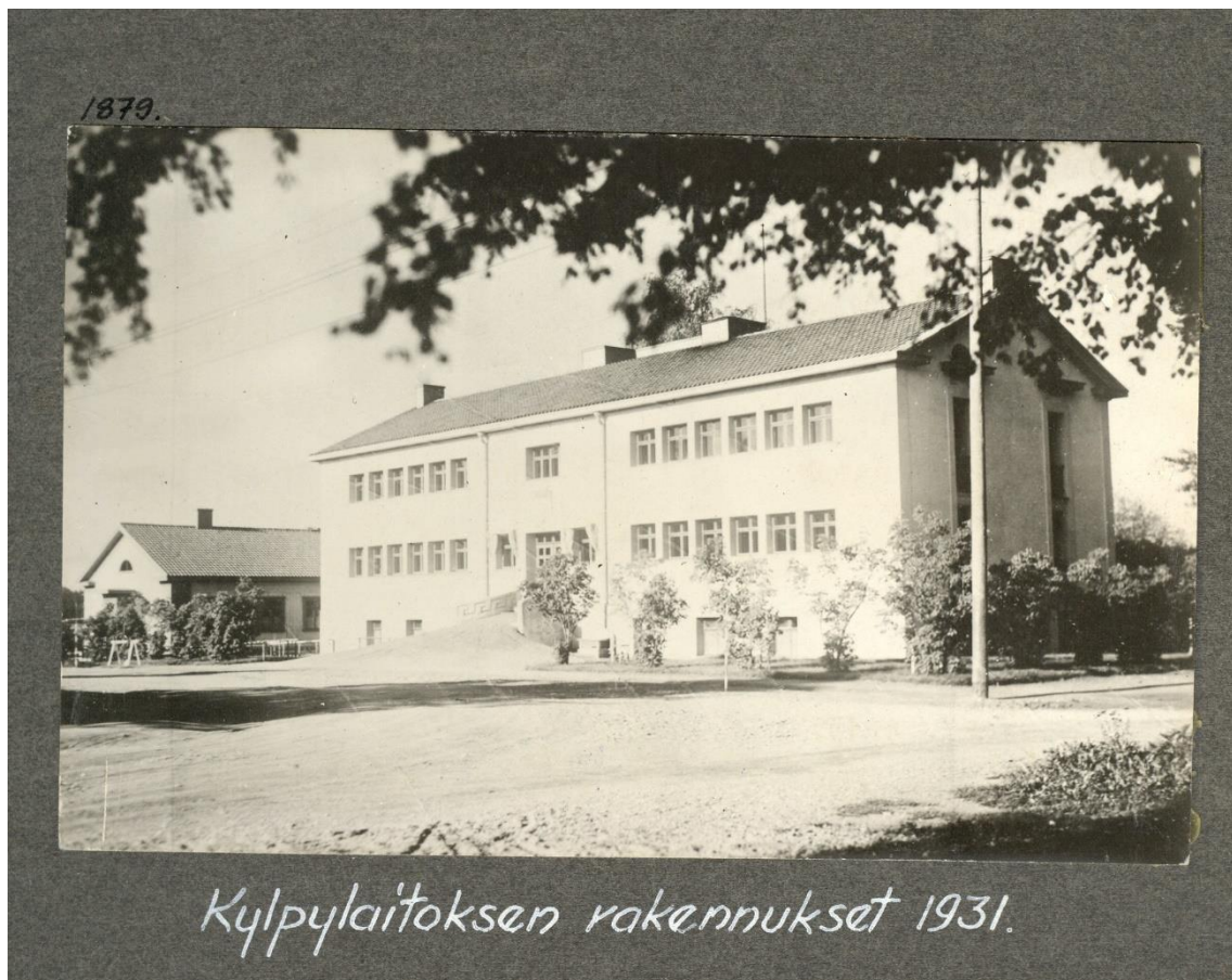
Kuva 4. Kylpylän päärakennus kuvattuna vuonna 1931 (Heinolan kaupunki 2020f)
