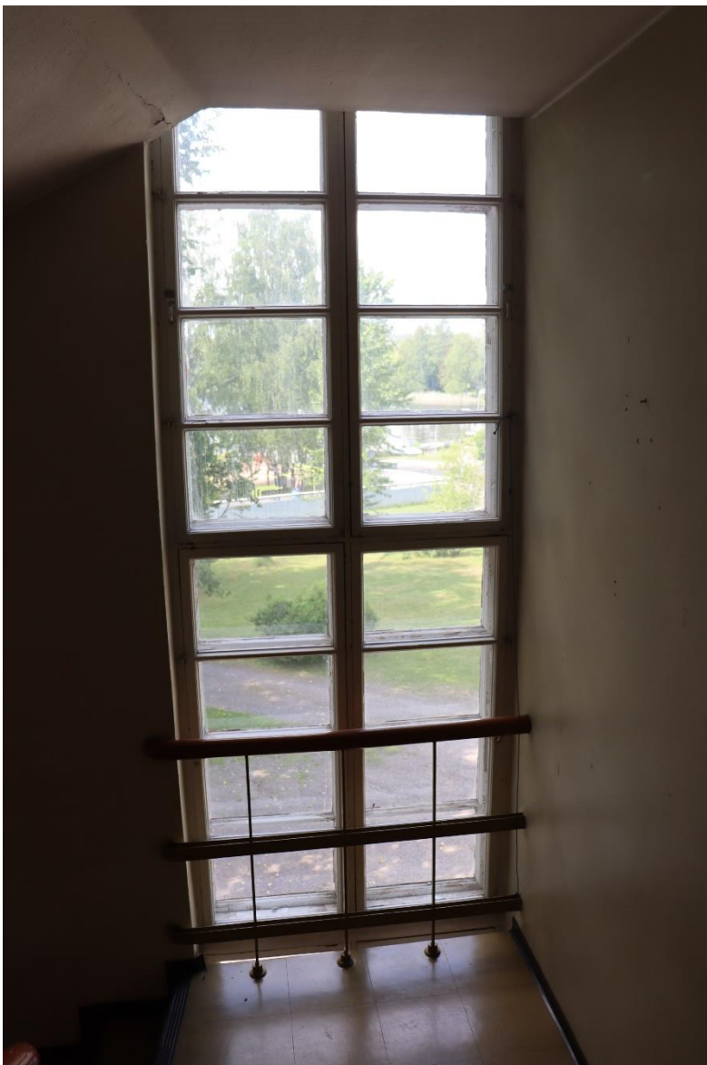
Kuva 7. Ikkunoiden kunto päärakennuksessa vierailukäynnillä (Nousiainen 2020a)
