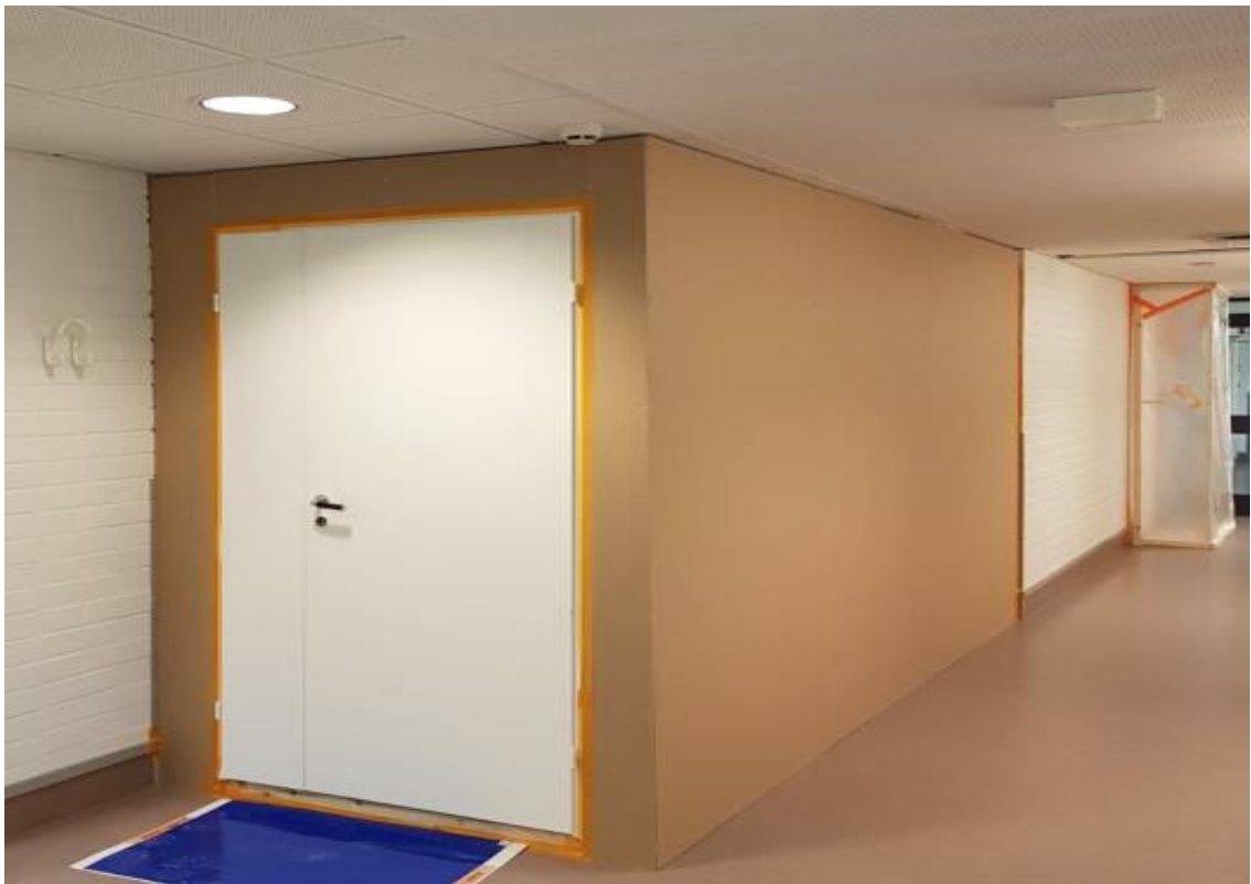
Kuva 3. Purkutyökohteen kulkureitin väliaikaista suojausta.
