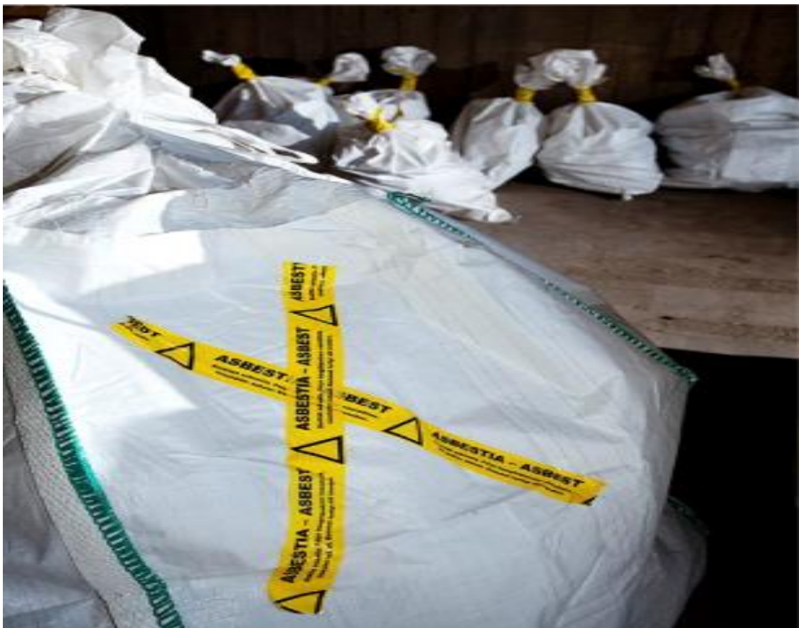
Kuva 2. Asbestipurkujätteen pakkausta. [9.]
