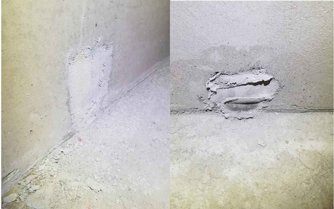
Kuva 8 Asennustyöhön kuuluva paikkaus tehty oikein. [KH]
