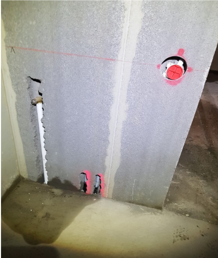
Kuva 20 Ako-seinässä olevaa tekniikka varten tehtyjä roiloja. [KH]
