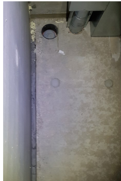
Kuva 8 Hormielementti, sekä elementin ja seinäelementin välinen täytettävä rako. [KH]
