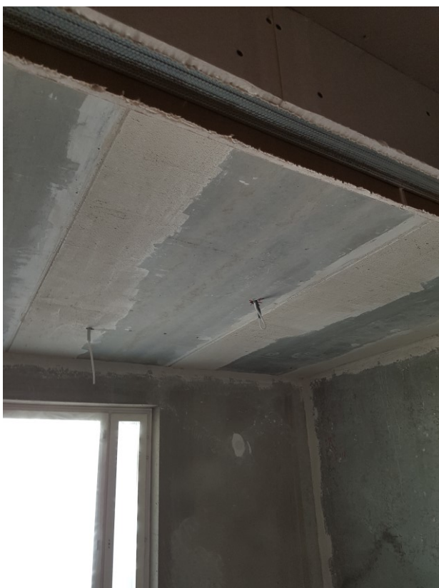
Kuva 10 Ontelolaattojen alapinnassa havaittujen korkeusvaihtelujen korjauksia. [KH]
