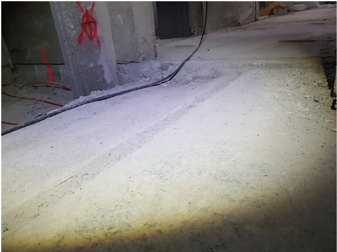
Kuva 11 Ontelolaatan yläpinnassa suurta korkeuden vaihtelua. [KH]
