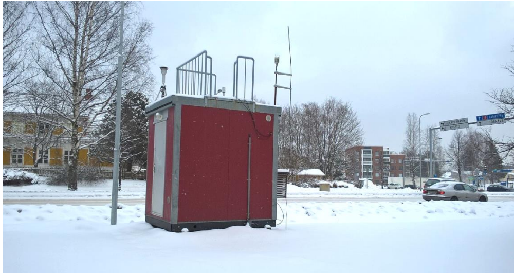
Kuva 7. Seinäjoen mittausasema, Vapaudentie 6a.
