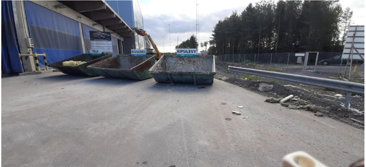
Kuva 16. Villan, kiviaineksen ja kipsilevyn lajittelumahdollisuus pienpurkualueella
