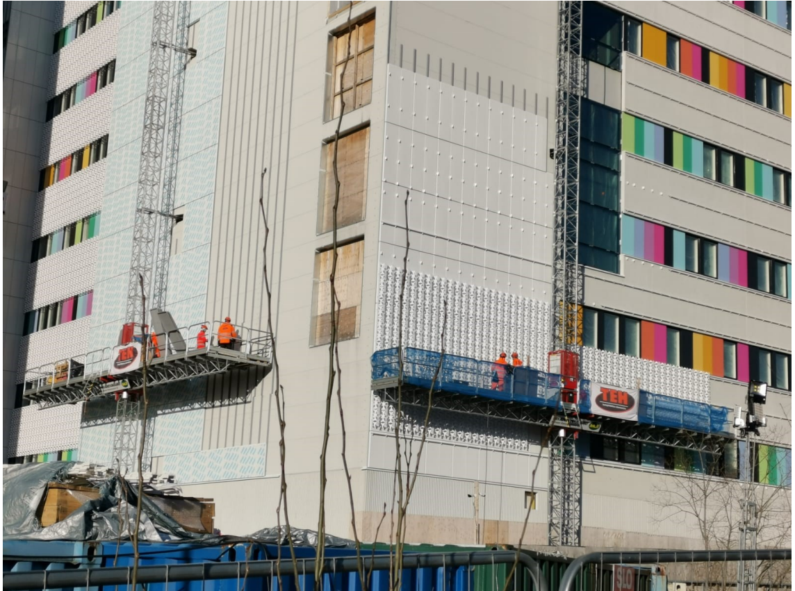
Kuva 2. Julkisivun asennusta mastolavoilta.
