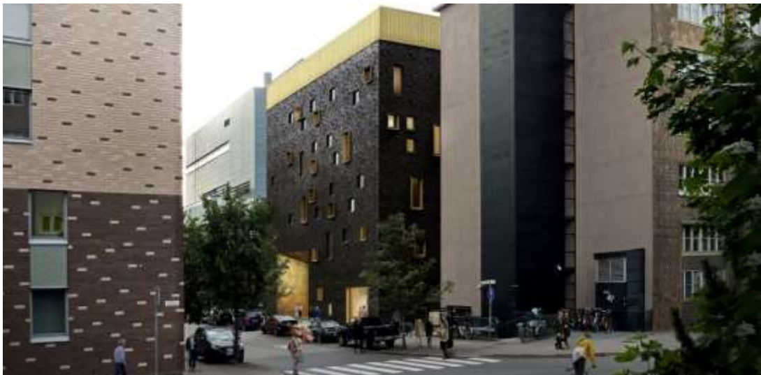
Kuva 3. Musiikin uudisrakennus (SRV Rakennus Oy)
