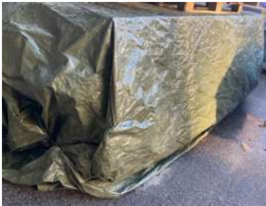
Kuva 17. Kipsilevyjen varastointi SRV:n varastoalueella
