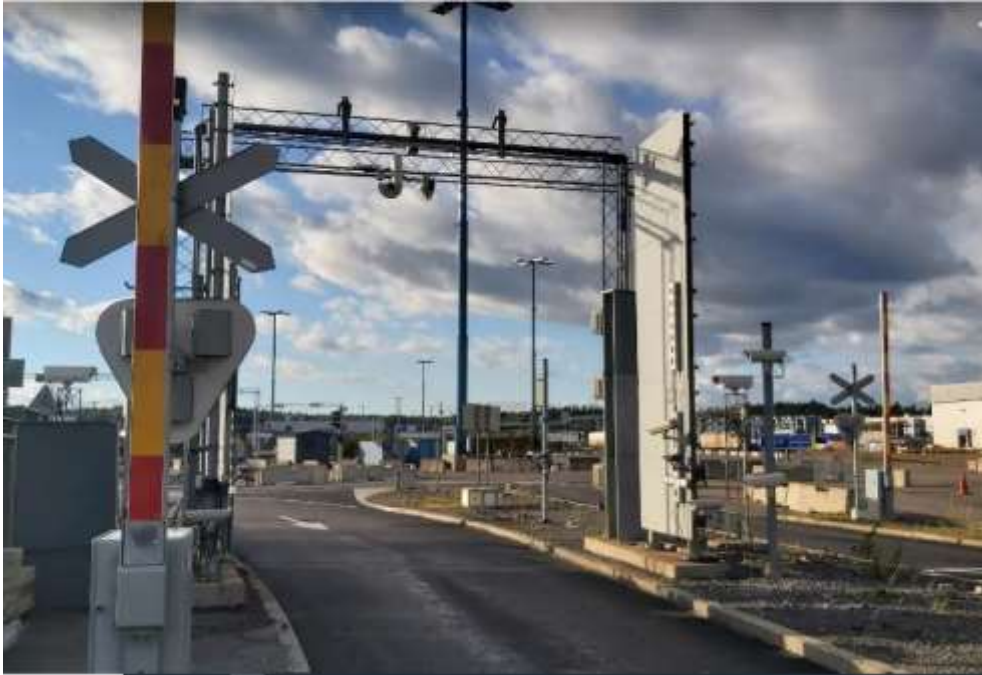
Itäpuoli, sisäänajokaistan tunnistus ja kuntokuvaus sekä mittaus 09/2020.
