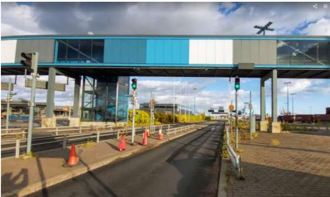
A-Porttialueen sisäänajon esitunnistus Harbour Road In:llä. Tunnistuskamerat asennettu pylväisiin kaistojen molemmille puolin. Tien ylittää jalankulkusilta. Kuva 09/2020.
