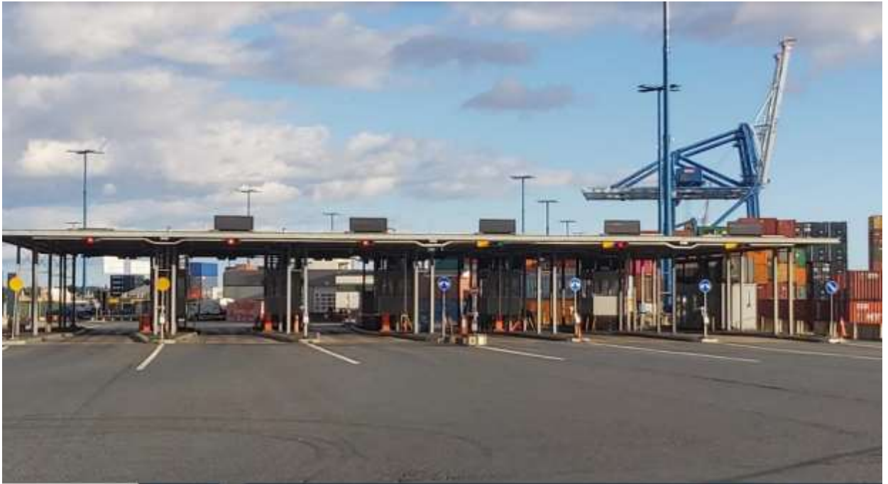
Operaattorin nykyinen kontrollipiste Itäpuolelle sisäänajon suunnasta kuvattuna 09/2020.
