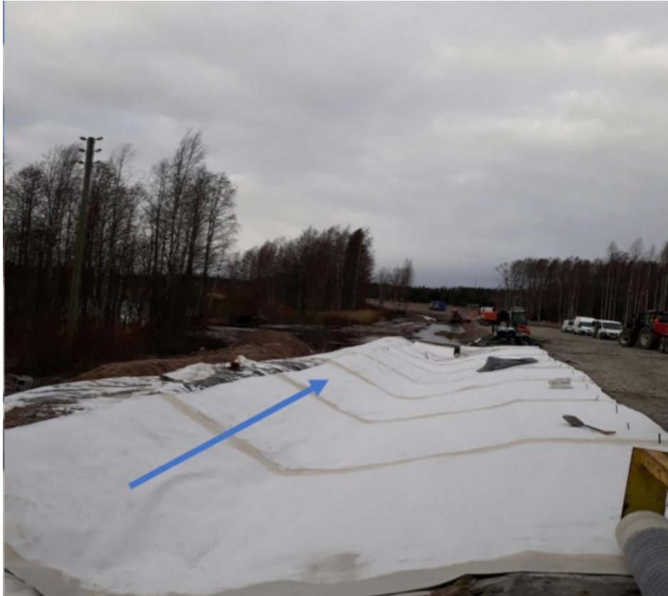
Kuva 11. Asennettua bentoniittimattoa.
