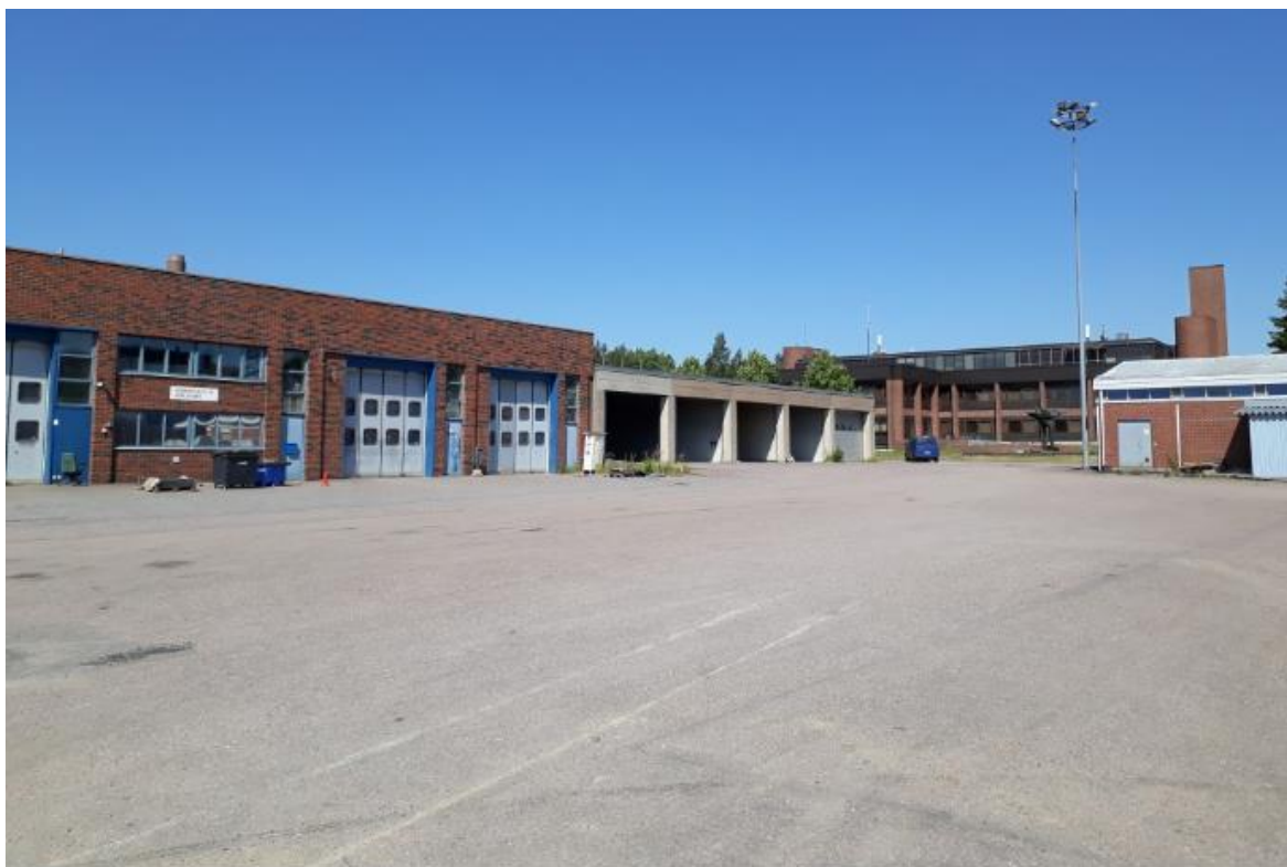
KUVA 1. Tyhjentynt ja purkua odottava Järvenpään kaupungin varikkoalue Kaskitie 4-6, kesäkuussa 2020 (Kuva: Jarkko Hämäläinen)
