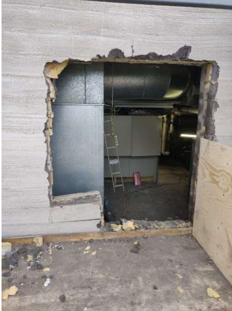
Kuva 10. Raitisilmakammio haalausaukon osittain haalausreitit edessä.
