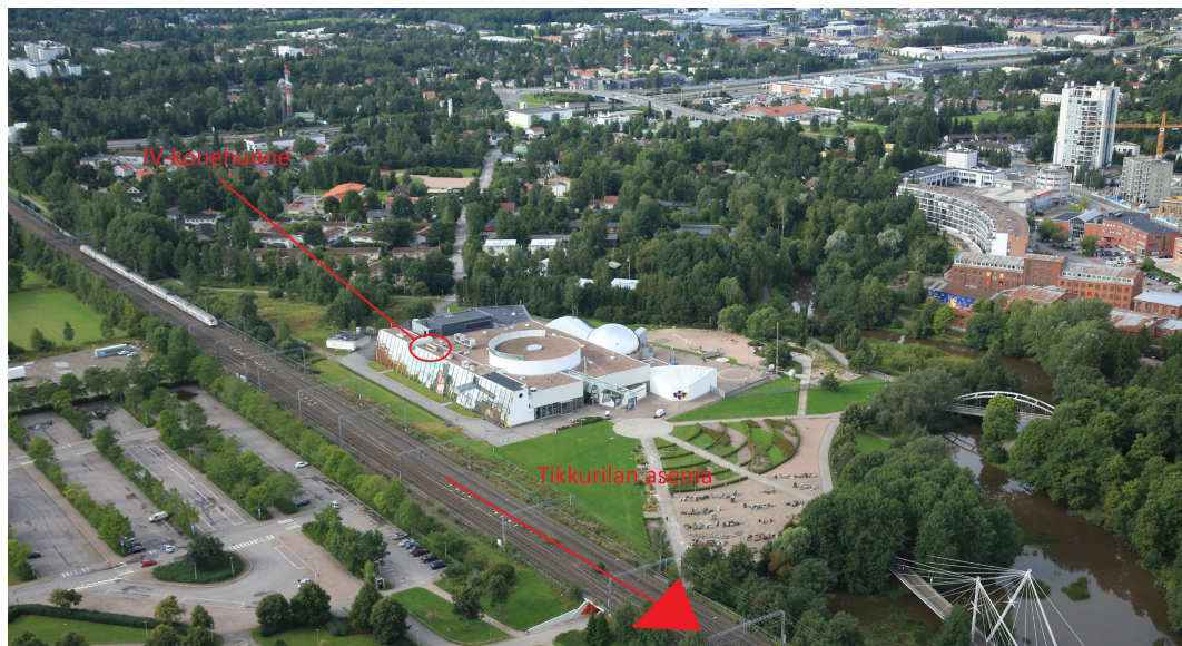
Kuva 1. Kohteen saneerattava IV-konehuone pääradan puolella rakennusta punaisen ympyrän kohdalla.
