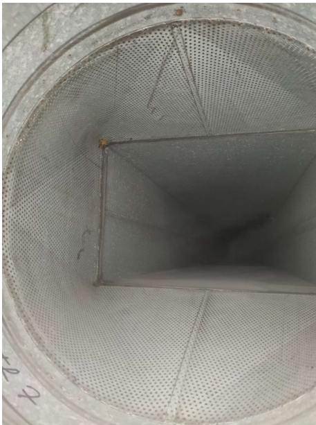
Kuva 14. Kantimuunnoksen sisäpuoli villaa, jonka päällä reikäpelti.
