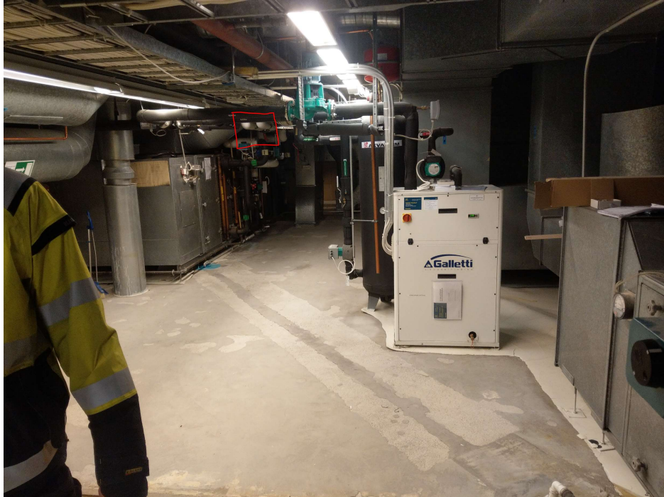
Kuva 7. IV-konehuone ennen purkua. Vasemmalla vanha TK/PK6 ja oikealla TK/PK5
