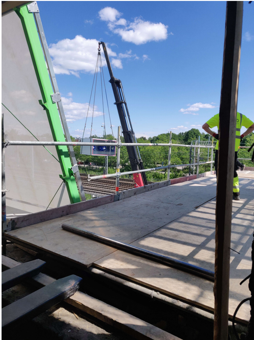
Kuva 12. IV-koneiden lohkot nostettiin aluksi telineiden päälle, josta ne työnnettiin miesvoimin teräsputkea hyödyntäen pinoamiskärryjen päälle.
