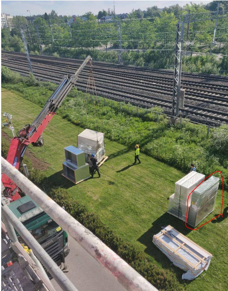
Kuva 11. Uusien ilmanvaihtokoneiden palojen lajittelua. TK5:n LTO-kiekko ympyröitynä oikeassa laidassa.
