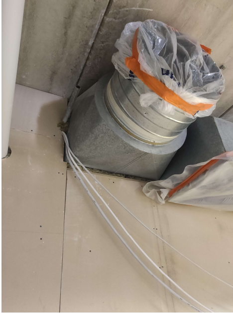
Kuva 13. Kantimuunnososa, jossa äänieristeenä käytetty villaa. Vieressä oikealla villalla äänen- vaimennuseristetty kantikäyrä.
