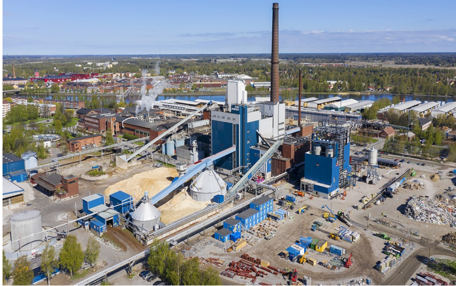
Kuva 1. Ilmakuva Aittaluodon voimalaitoksesta. (Pori Energia Oy:n www-sivut c. 2020)
