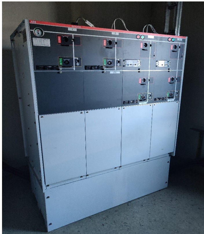
Kuva 13. Apukattilan RMU-kojeisto AJ16.
