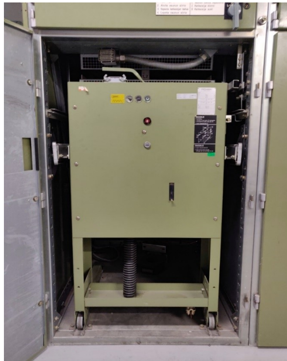
Kuva 11. OSAN 24 P1 - vähäöljykatkaisija
