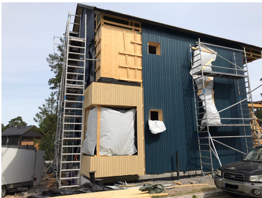
Kuva 4. CLT-runkorakenteisen talon ulkoverhouksen asentamista
