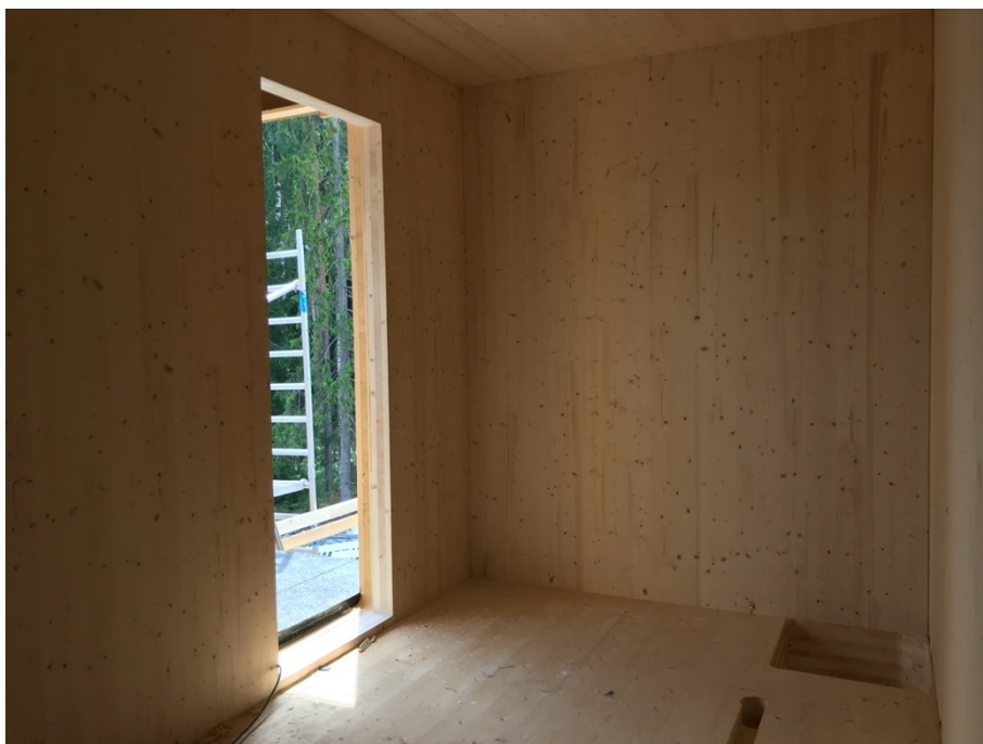
Kuva 2. CLT-elementeistä rakennettavassa talossa ovat mm. oviaukot jyrstetty CNC-koneella valmiiksi jo tehtaalla
