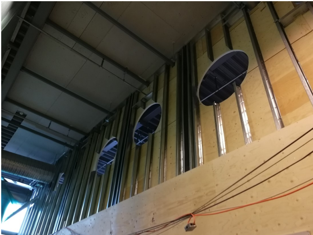
Kuva 6 Ilmastoinnin läpiviennit rakennusvaiheessa. Oma kuva
