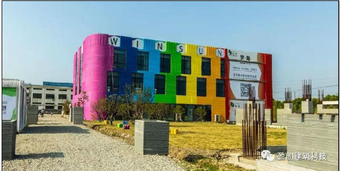
Kuva 23. Rakennuksen julkisivu on tehty 3D-tulostamalla, mutta sen runkorakenteesta ei ole tietoa. Värit on maalattu jälkikäteen. [21.]
