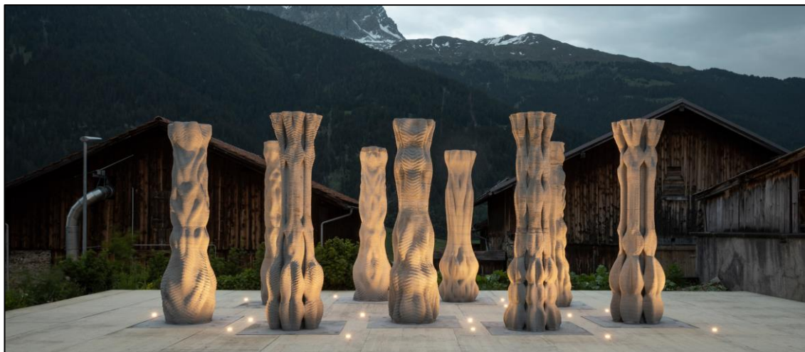
Kuva 18. 3D-tulostamalla valmistettuja betonipilareita. [41.]
