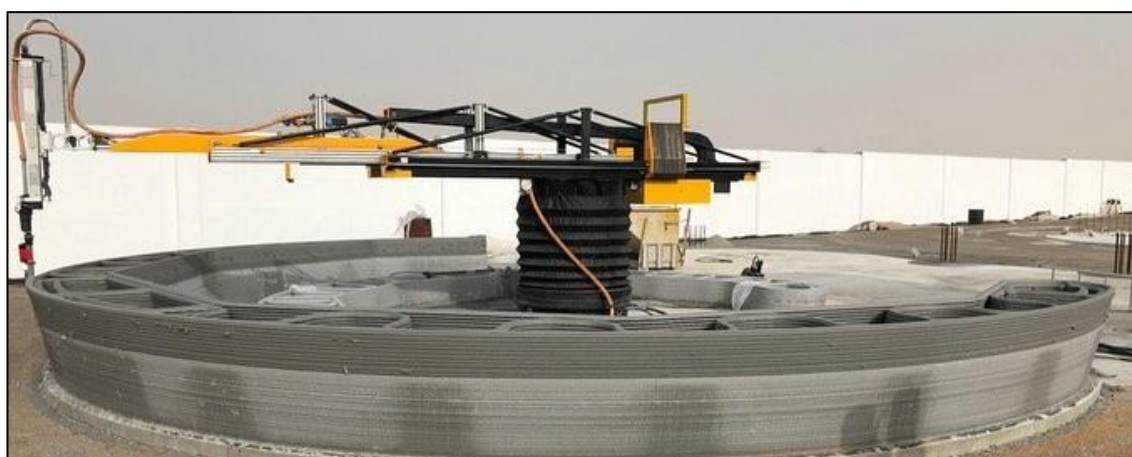
Kuva 20. Apis Cor yrityksen 3D-tulostin valmistamassa rakennusta. [18.]
