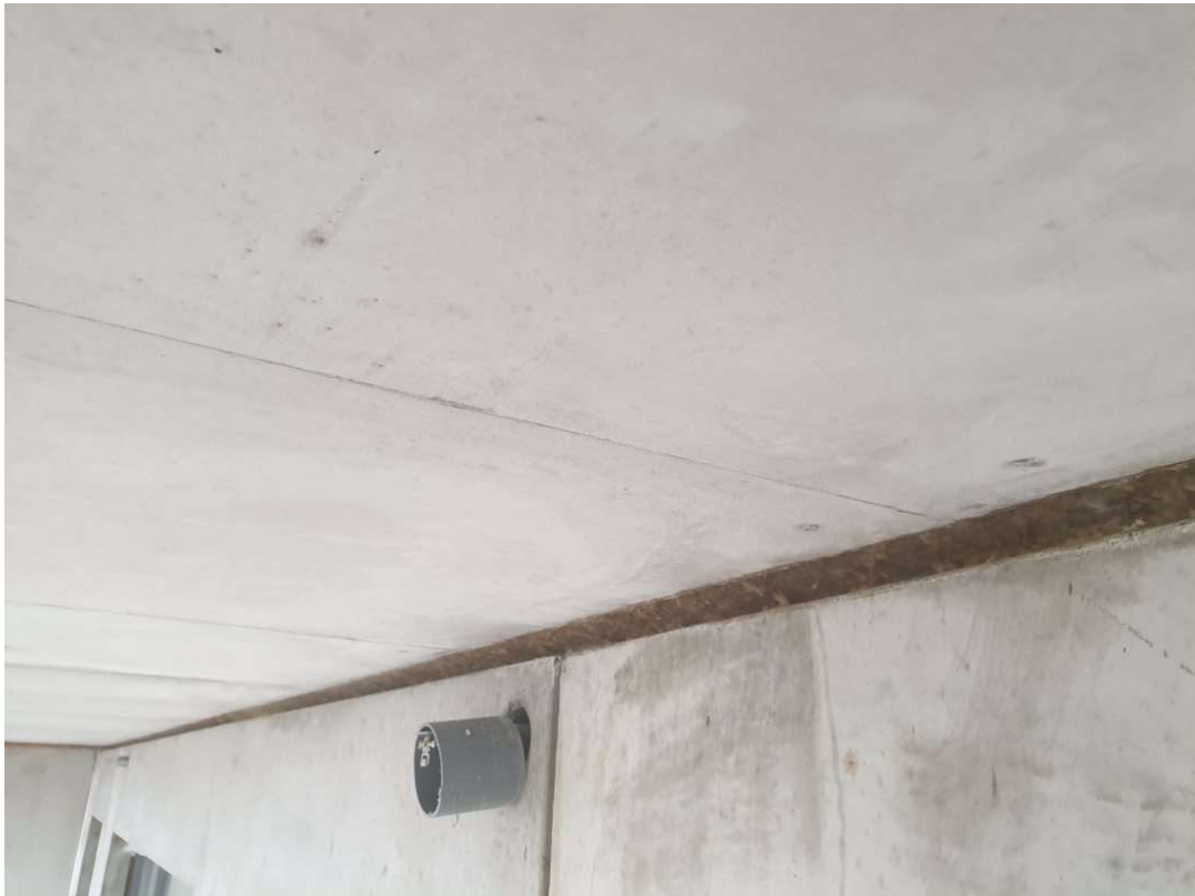
Kuva 19. Sandwich-ulkoseinäelementin päältä poistettavat villat [Kuva: Harri Huusko]
