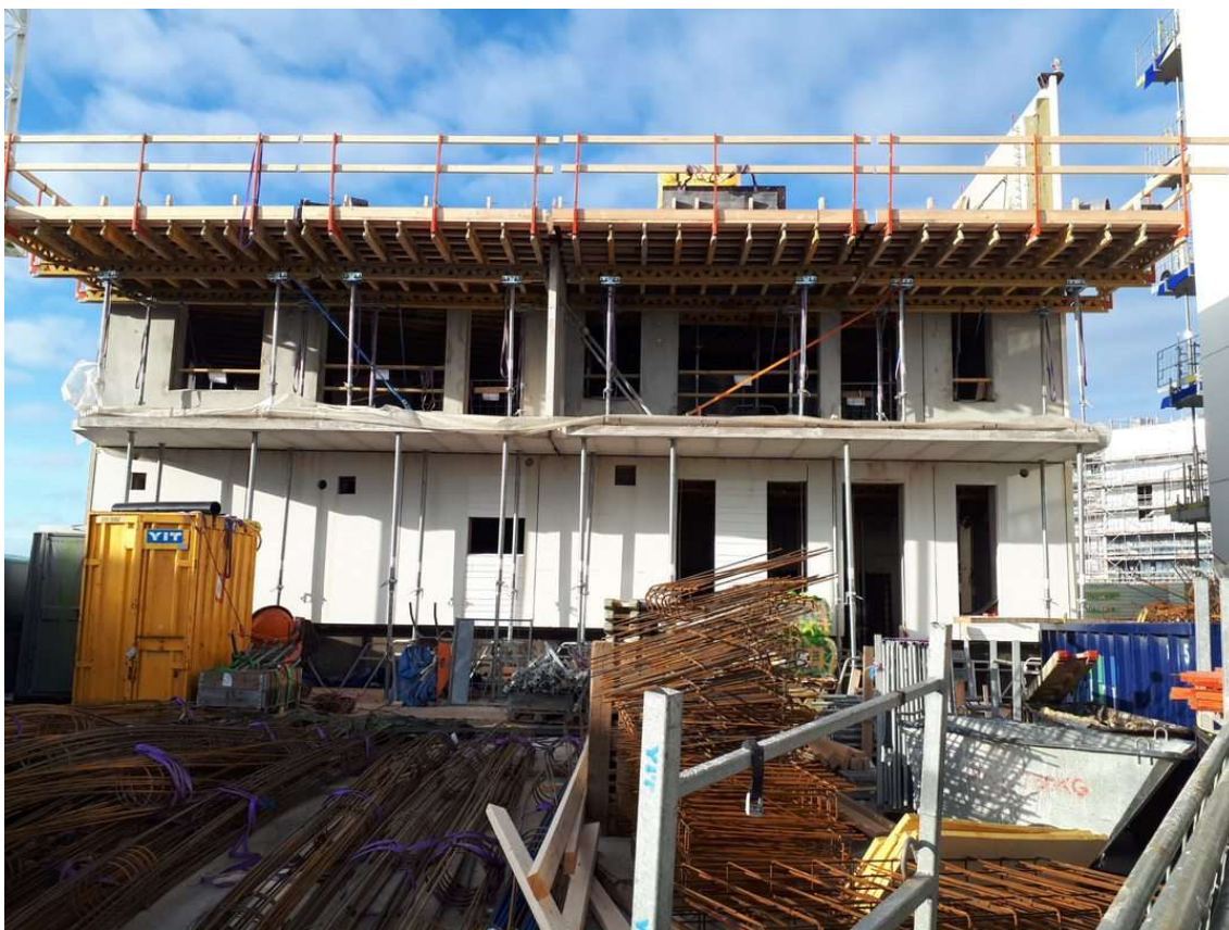
Kuva 12. Parvekkeiden pöytämuotit asennettuna [Kuva: Harri Huusko]
