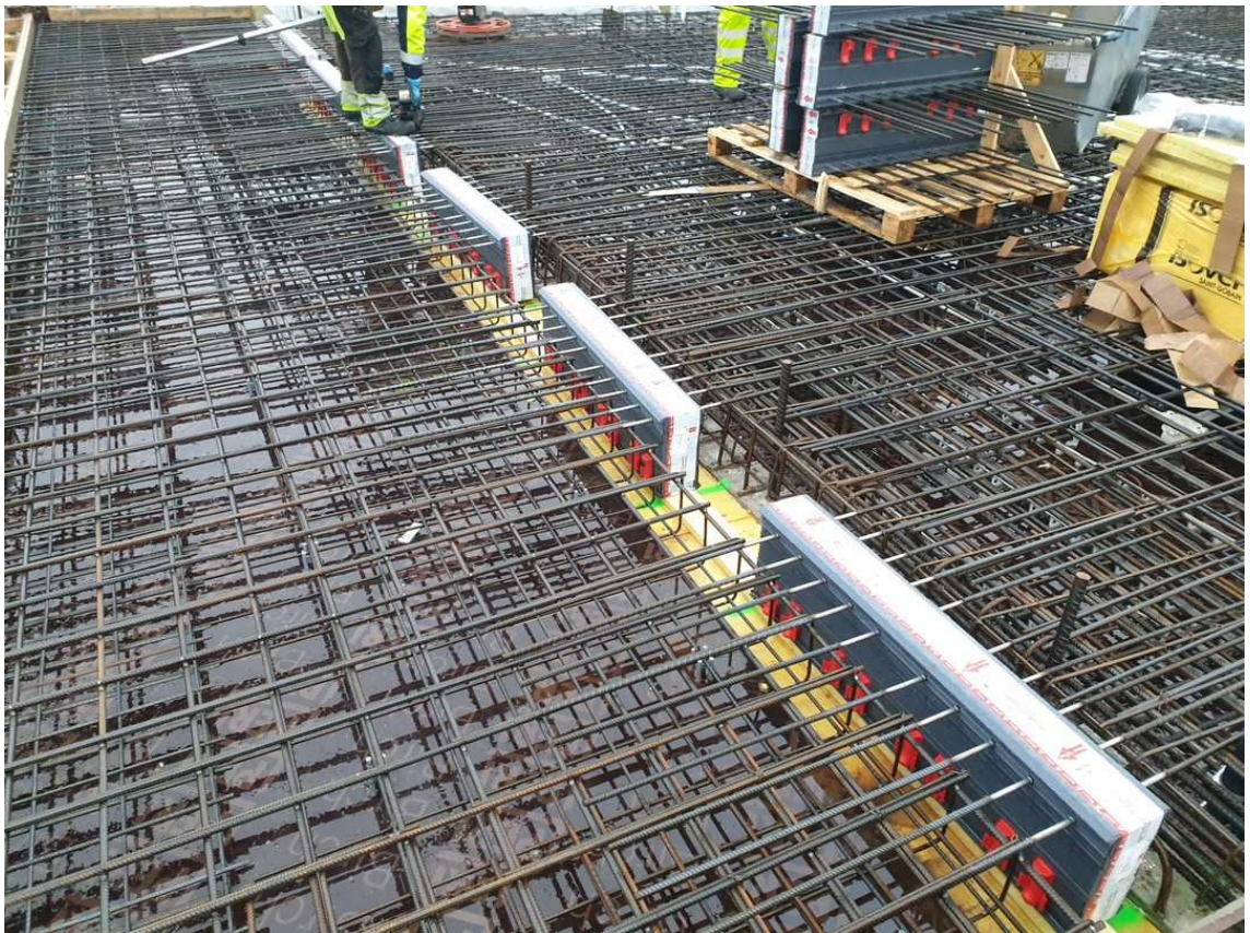
Kuva 14. Halfen-raudoituselementtien asennus käynnissä [Kuva: Harri Huusko]
