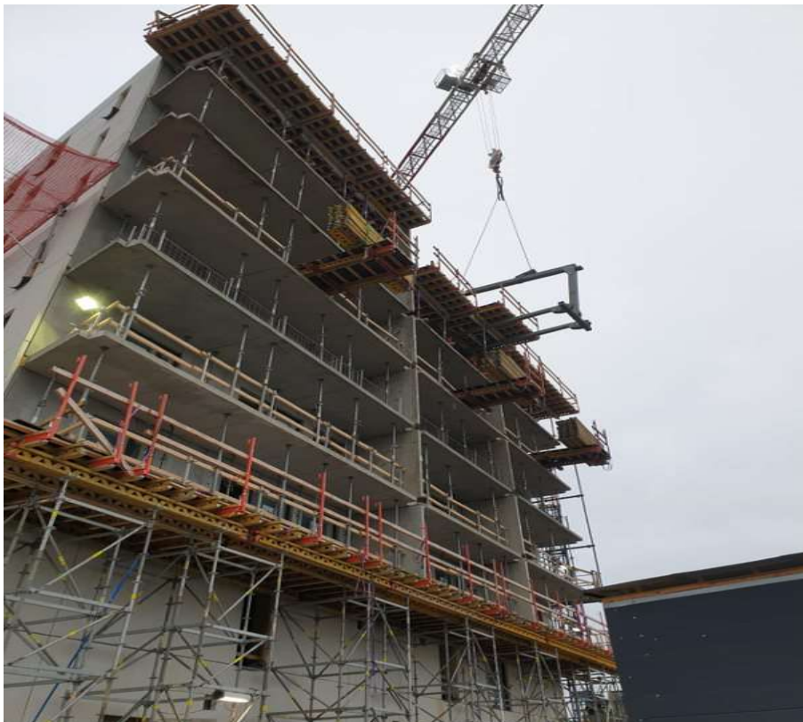
Kuva 16. Parvekkeen pöytämuottien siirto käynnissä, nostoapuvälinettä käyttäen. [Kuva: Harri Huusko]
