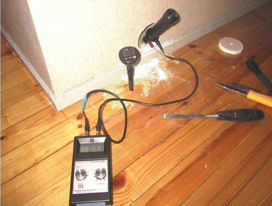
Kuva 9. Seinä- ja lattiarakenteiden kosteuden mittaus (Sisäilmäyhdistys, [Viitattu 18.10.2020].)
