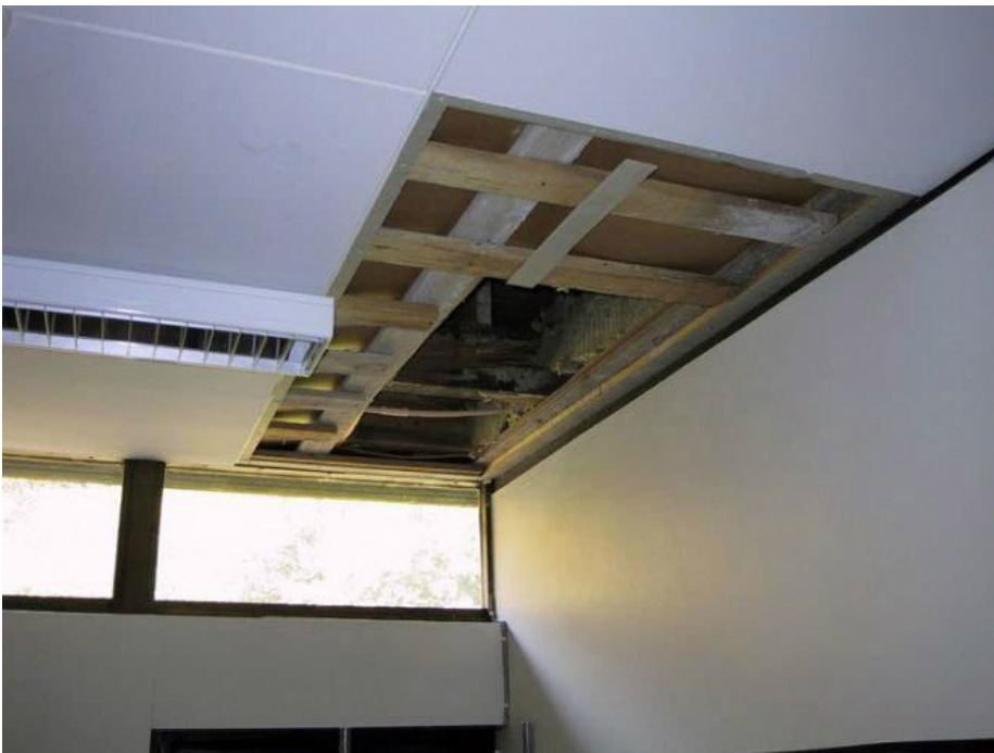
Kuva 11. Yläpohjan rakenneavaus (Sisäilmayhdistys, [Viitattu 19.10.2020]).
