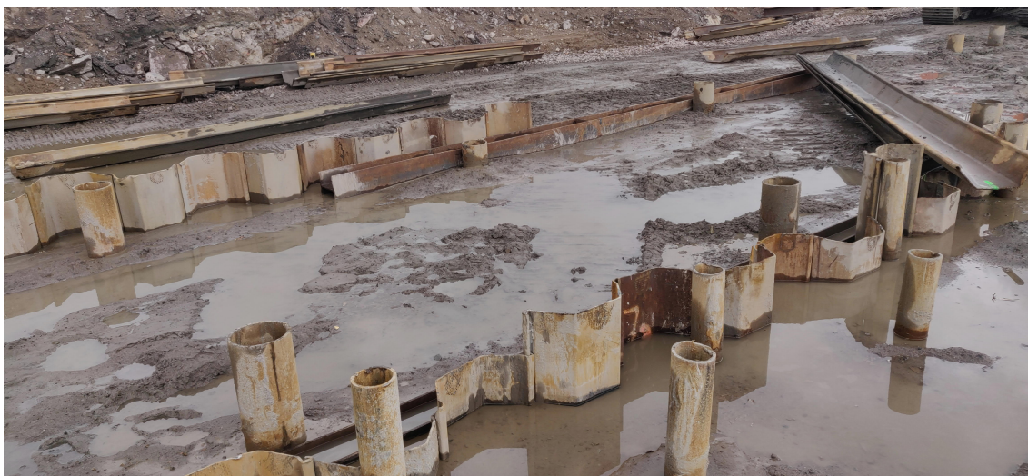
Kuva 11. Toisinaan veden taso oli hyvin korkealla. Kuvassa pontitustyö kesken.
