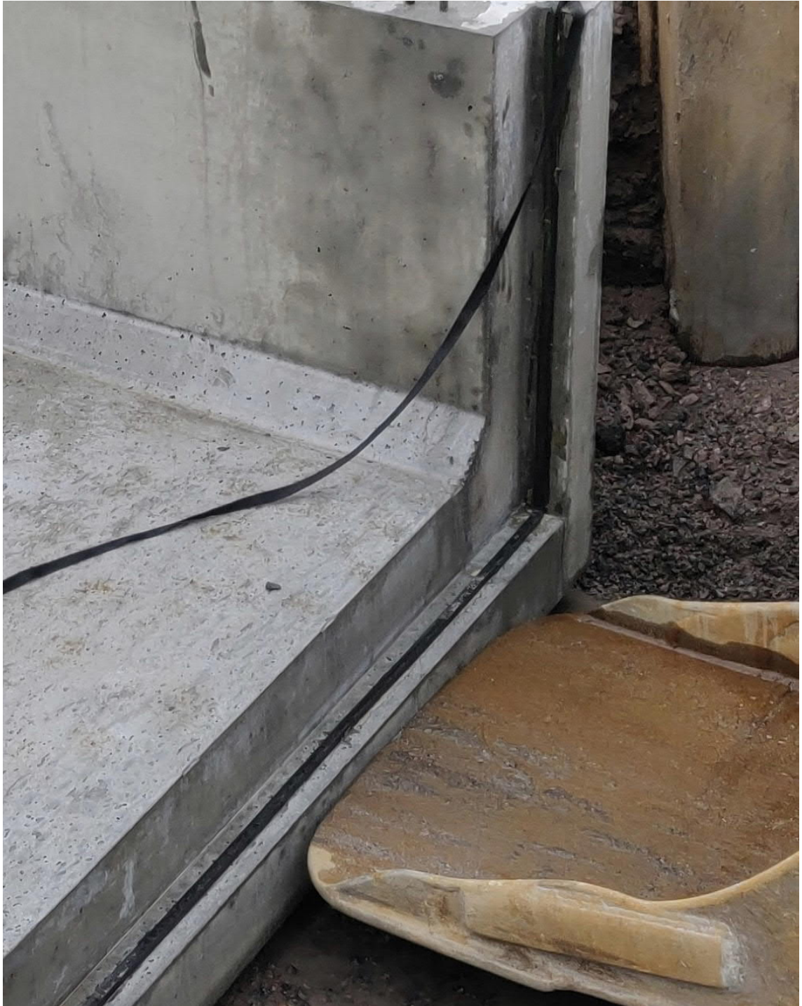
Kuva 7. Elementin ponttiliitoksen naaraspontti. Kuvassa kaivinkone työntää kauhallaan elementtiä kiinni toiseen elementtiin.
