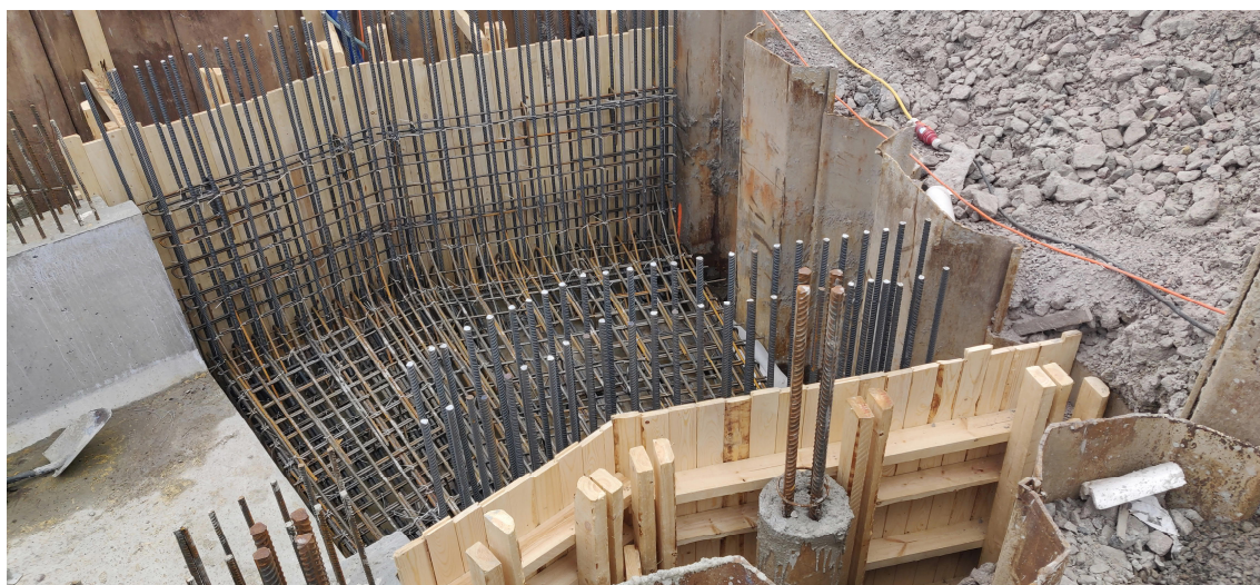
Kuva 20. Kanaalin pääty. Päätyponttien takana aiemmassa urakassa rakennettu paalulaatta sekä tulpattu 300mm betoninen jätevesiputki johon liiityttiin.
