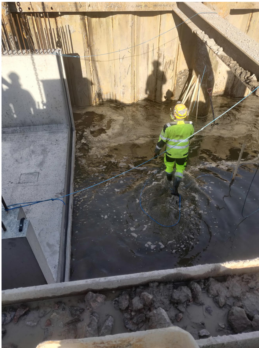
Kuva 16. Elementin asennustyöt käynnissä.
