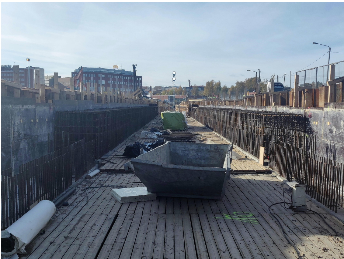
Kuva 8. Kanaalielementin työtaso ja palkin raudoitus.
