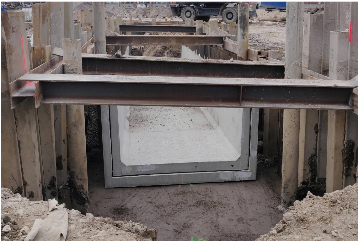
Kuva 15. Pontein ja soljin tuettu kaivanto Jääkairankujalla.
