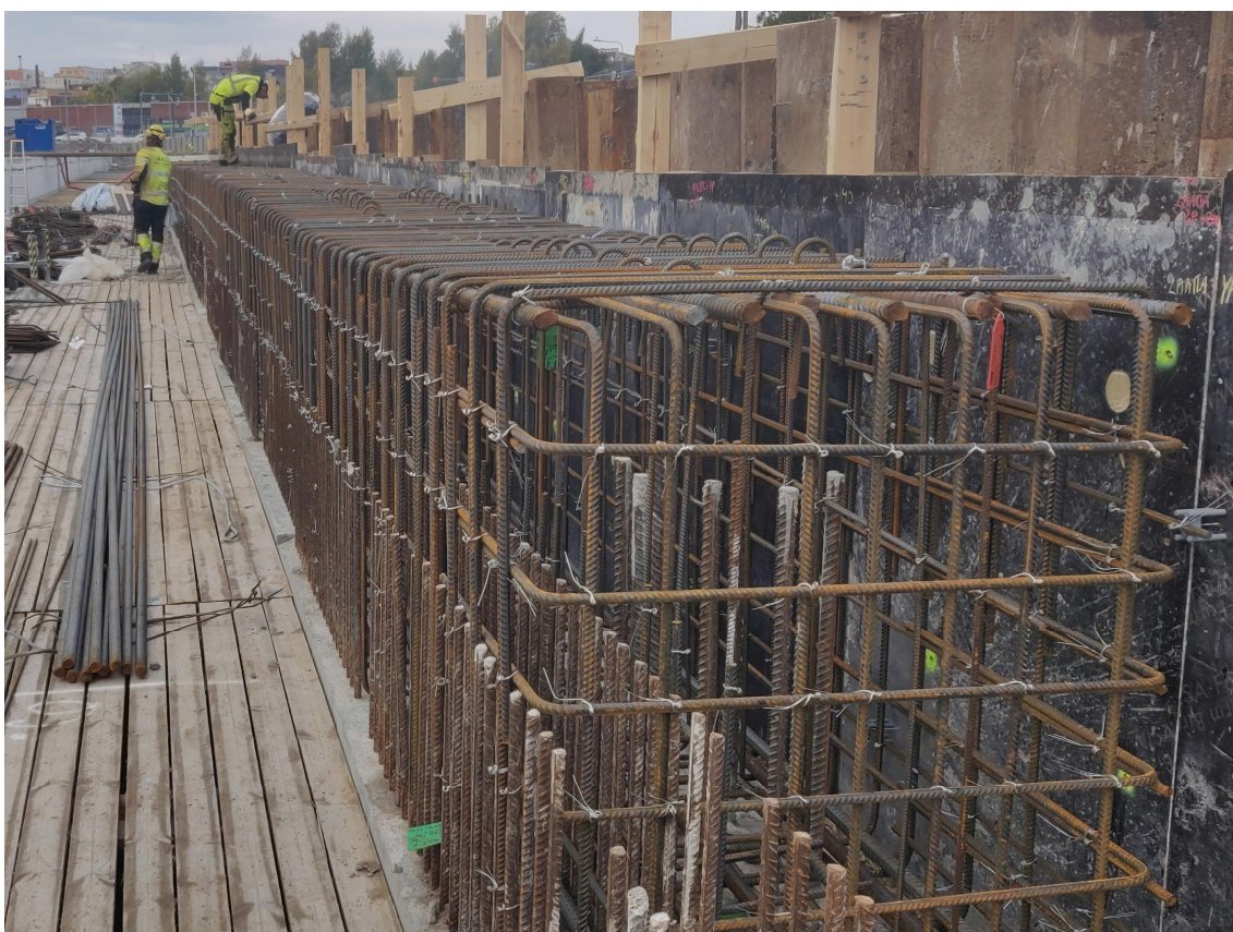
Kuva 22. Palkin muotti ja rauditus. Ykkösmuotti tuetaan ylösnostettuihin pontteihin.
