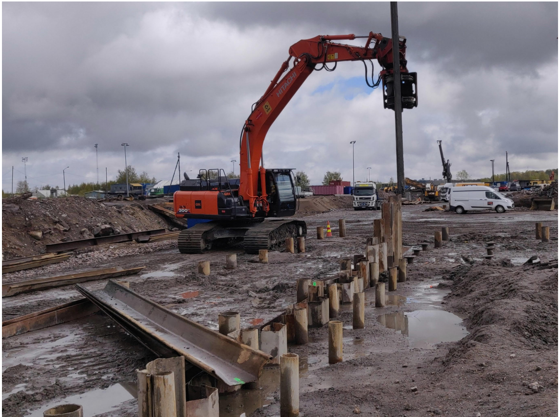
Kuva 14. Pontin asennustyöt meneillään
