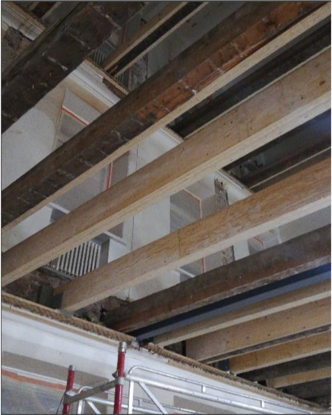
Kuva 6. KOy Helsingin Merkuriuksen korjattu välipohja.
