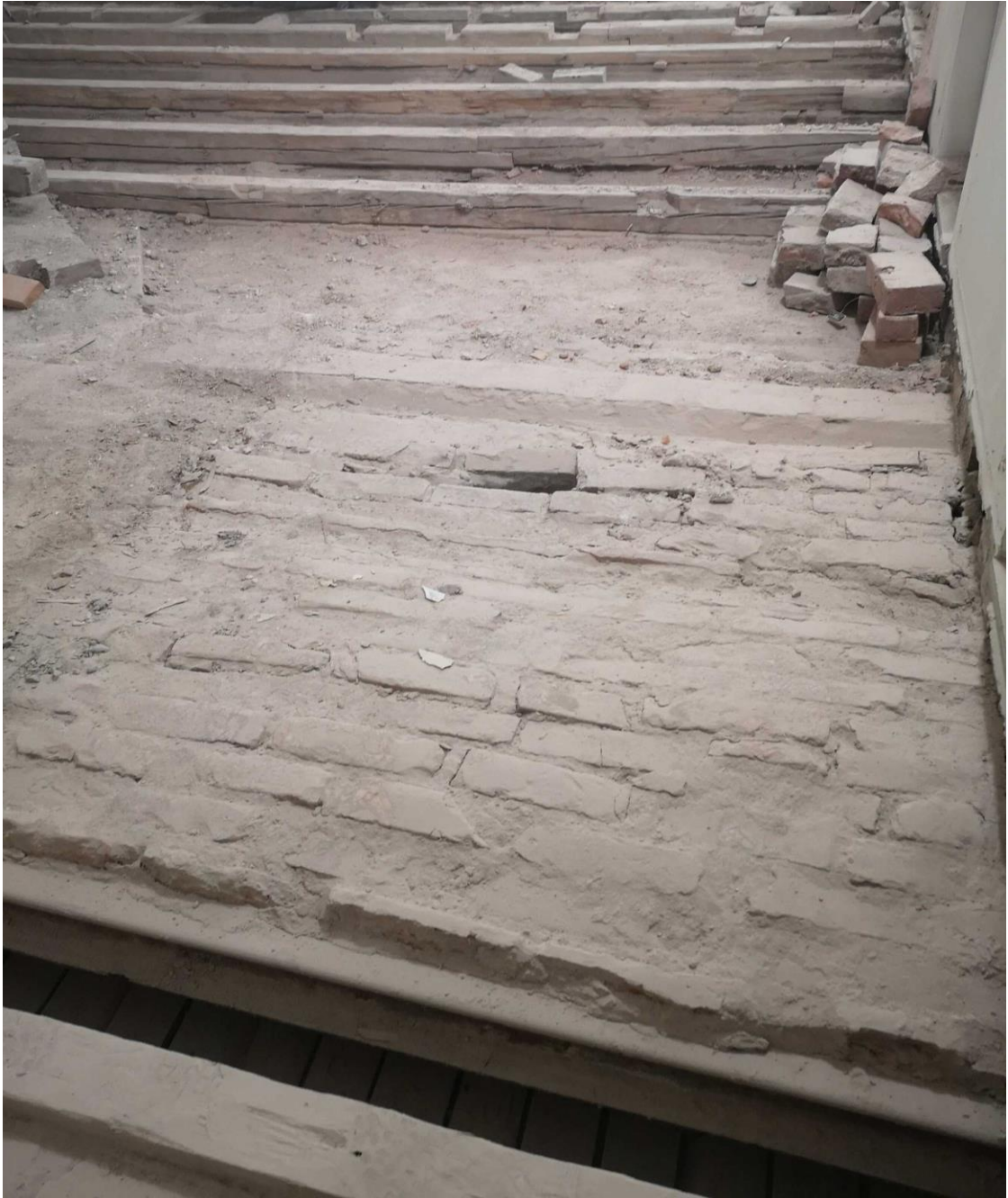
Kuva 12. Vanhan tulisijan pohja tehty holvaamalla tiilistä.
