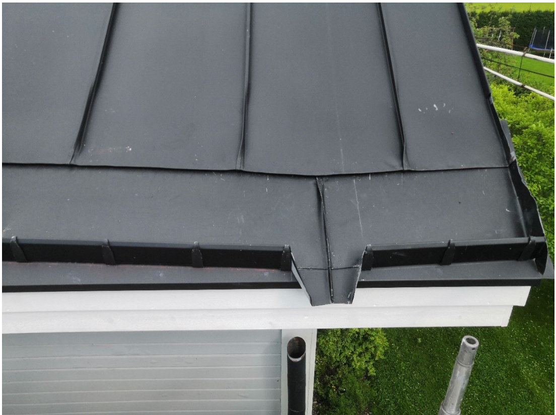
Kuva 264. kahdesta osasta saumattu lotokka, eli vesiuoma. Koukullisten jalkarännien lotokkaa ei tarvitse välttämättä saumata jalkaränniin kuten puutuellisissa jalkaränneissä.
