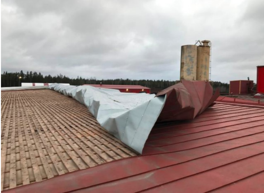
Kuva 119. Tuulen vaikutuksesta kuoriutunut teollisuusrakennuksen saumapeltikatto. Kyseessä on loiva harjakatto avaralla tehdasalueella, jossa tuulen vaikutukset korostuvat. Kuva Sami Järvenpää 2019.
