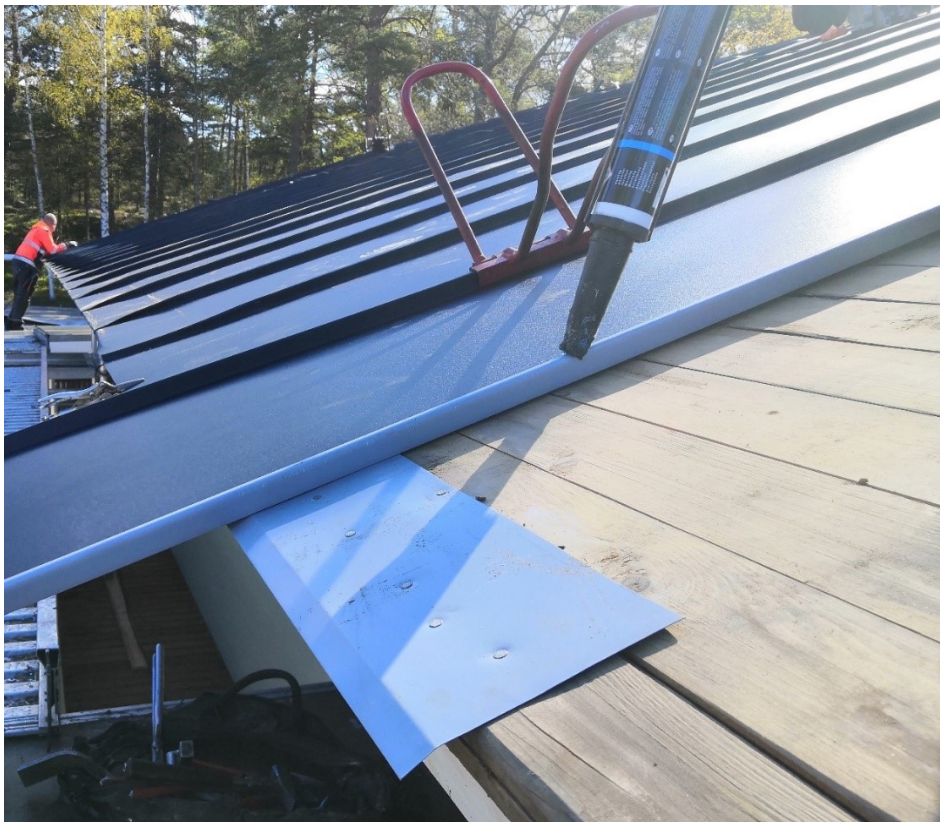
Kuva 224. Räystäään apulistan asennus. Huomioitavaa kuvassa massan levitys pieneen saumaan ennen klemmareiden asennusta erityisen massatuubiin kiinnitettävän suukappaleen avulla.
