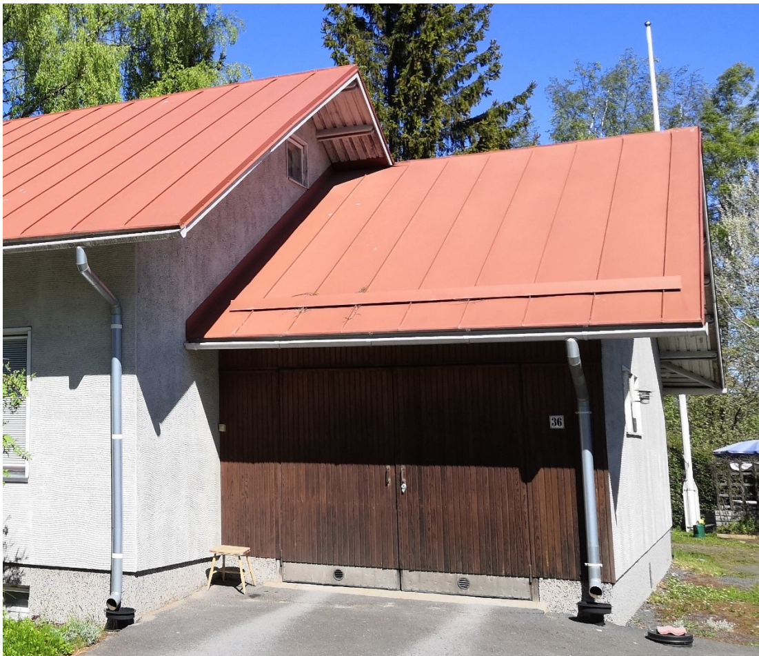
Kuva 10. Kuvassa pural- pinnoitettu katto, joka on 13 vuoden ikäinen. Pinnoite näyttää edelleen uudenveroiselta.
