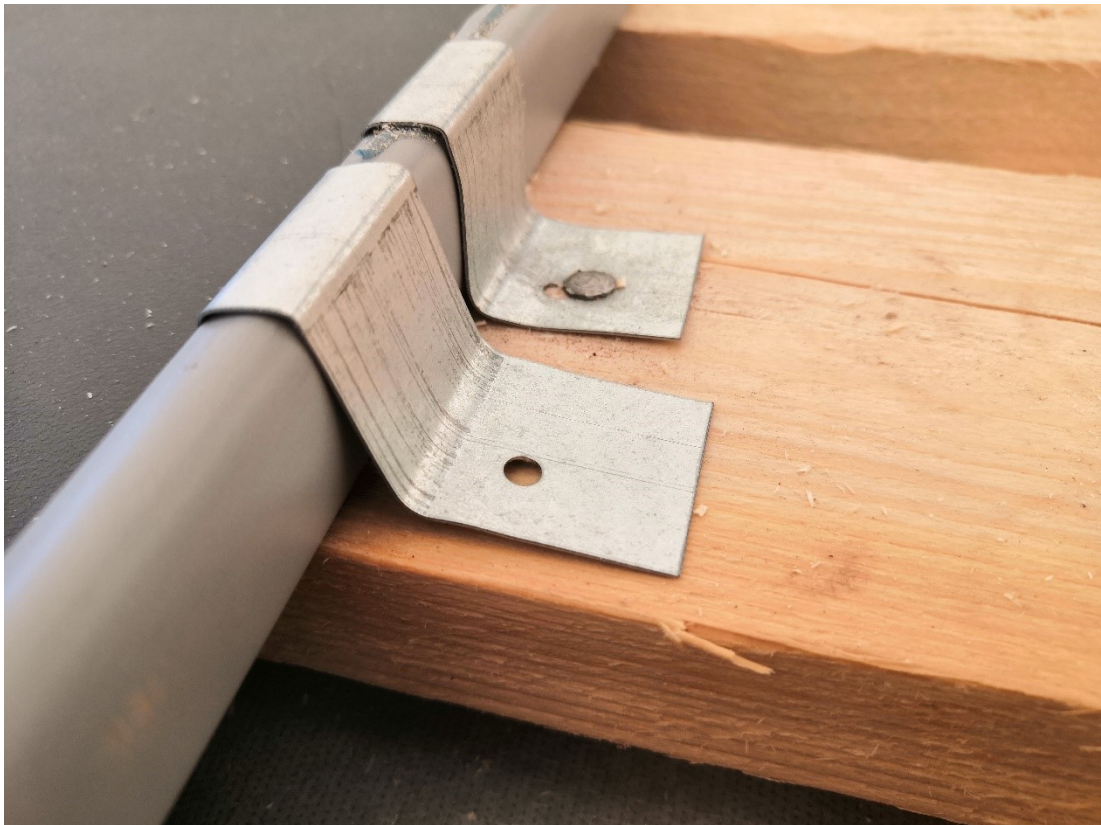
Kuva 125. Klemmarin ja pystysauman alakulmaan voidaan kylmässä asennettaessa jättää väli, jolloin rivi pääsee elämään vaakasuunnassa lämpötilan noustessa. Ylempänä tavanomainen klemmarin asento.
