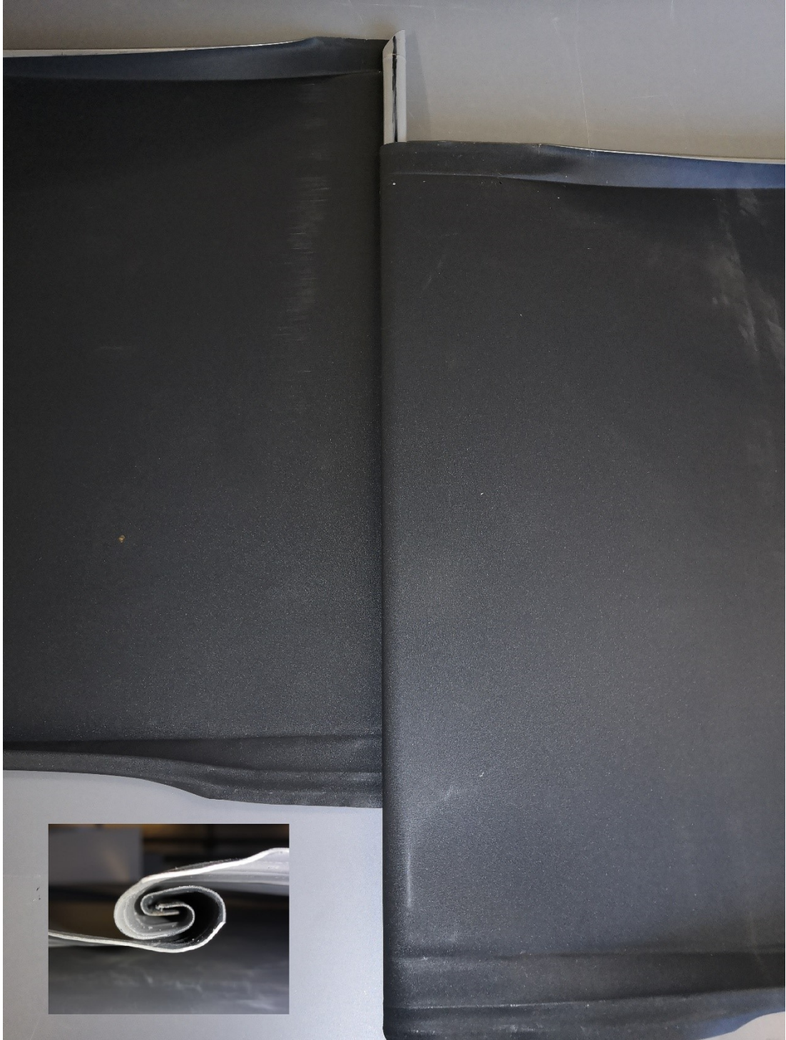
Kuva 141. Kappaleet liitetään yhteen. Kuvassa tiivistysaineen paikka alemman veivisauman päällä, merkattuna mustalla värillä.
