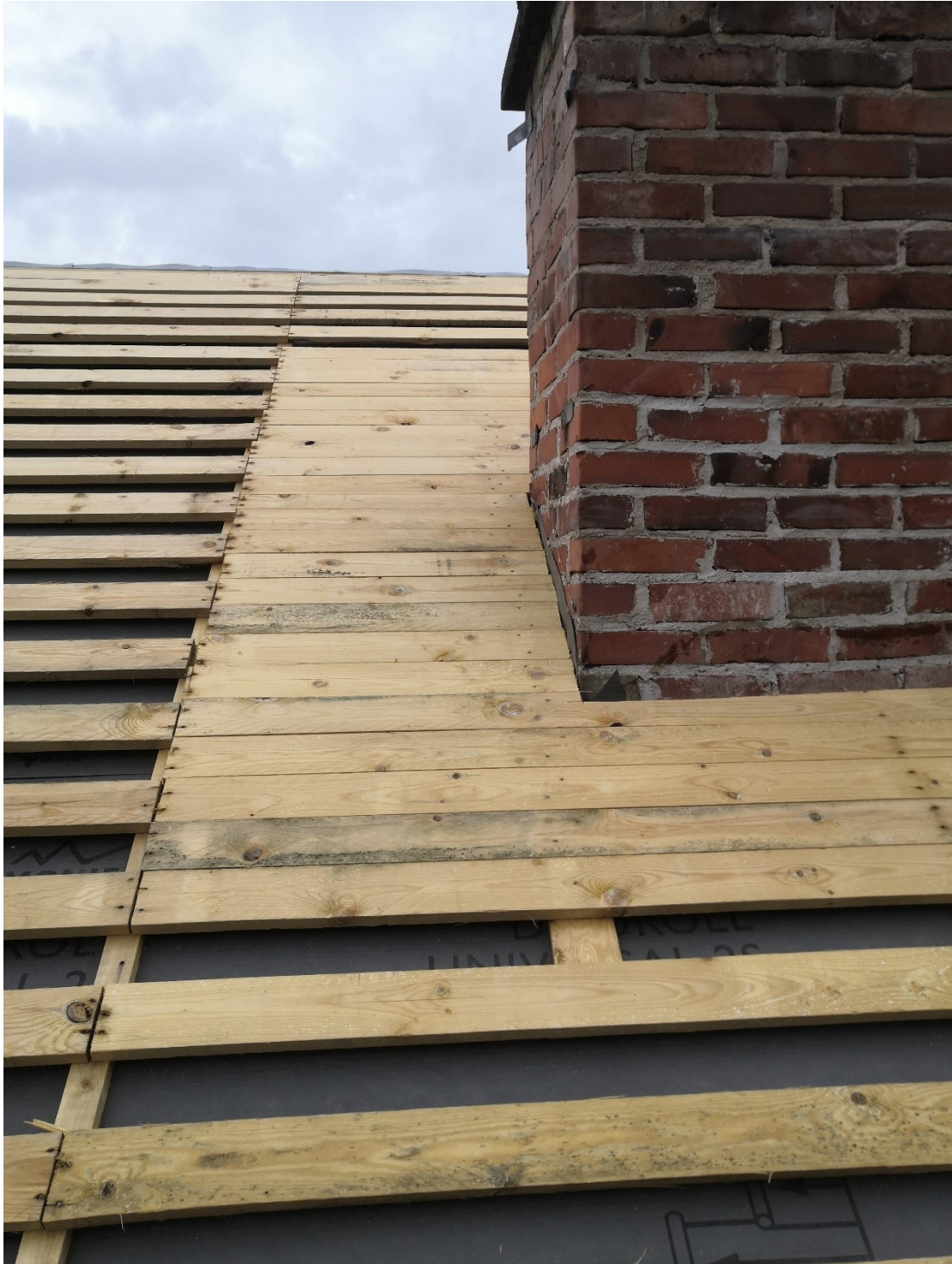
Kuva 60. Piipun reunaan tehtävä tuki umpilaudoitukselle. Ruodelautojen vapaat päät tuetaan ylä- ja alapuolella oleviin ruoteisiin kattotuolin suuntaisen laudan avulla. Aluskatteen vaurioitumisen ehkäisemiseksi tulee käyttää lyhyitä kiinnikeitä.
