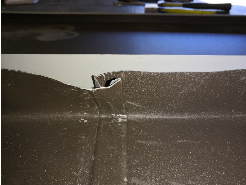
Kuva 182. Kaadetun pystysauman peltikerrosten välit avataan. Kuvassa kaadetun sauman oikea puoli saumataan ensiksi.
