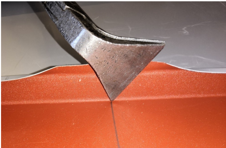
Kuva 172. Pystysauman taittaminen. Kummallekin saumalle tehdään sauman käsittely. Kuvassa pieni sauma.
