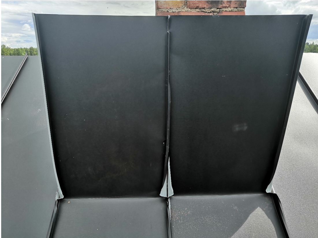
Kuva 83. Piipulle nostetut kattorivit. Kulman kohdalta pystysaumassa olevaa peltiä täytyy laskostaa, jotta kulman kääntäminen onnistuu.
