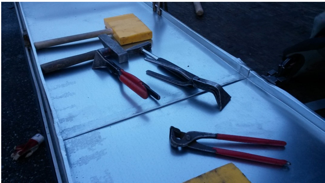
Kuva 135. Saumat nostetaan pystyyn ja muotoillaan.
