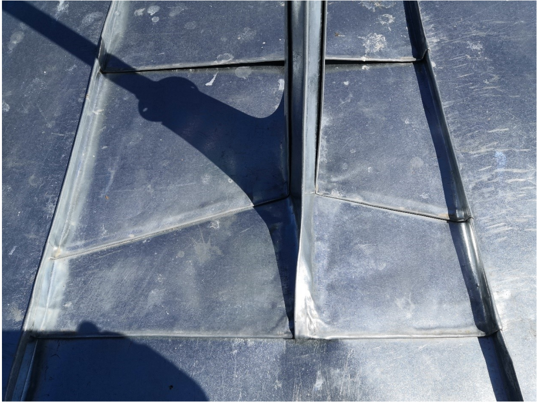
Kuva 313. Antennin läpivienti alaräystään puolelta kuvattuna.
