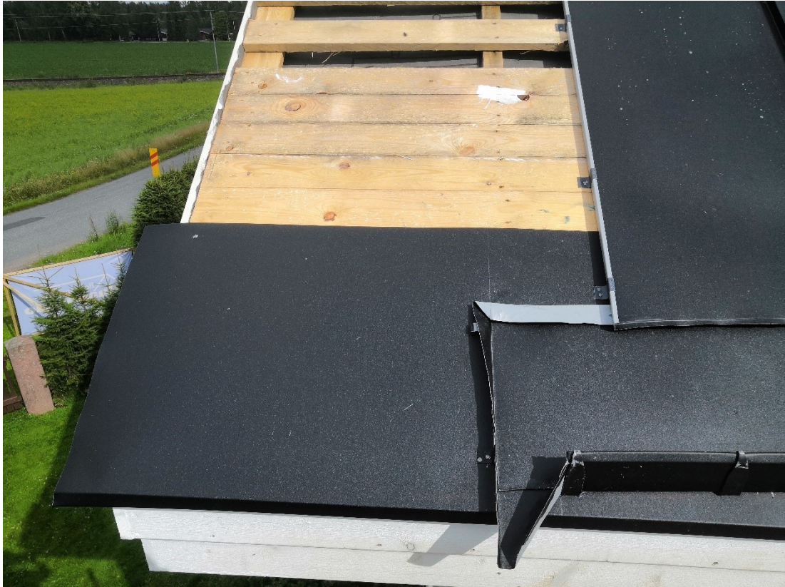
Kuva 61. Umpilauta tulee ulottaa jalkarännin takasauman yläpuolelle riittävästi. Kuvassa räystäspeltti ulottuu myös takasauman yläpuolelle.
