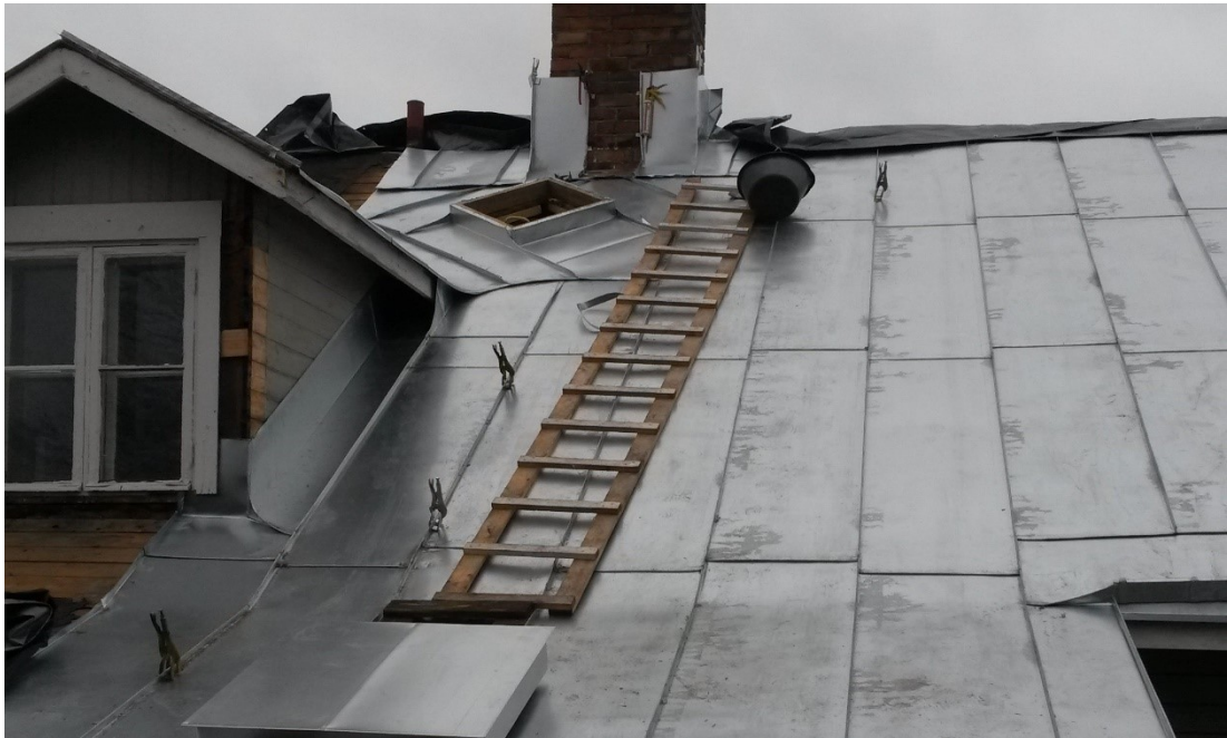
Kuva 300. Kattoluukku valmistettuna kulmataitoksilla.
