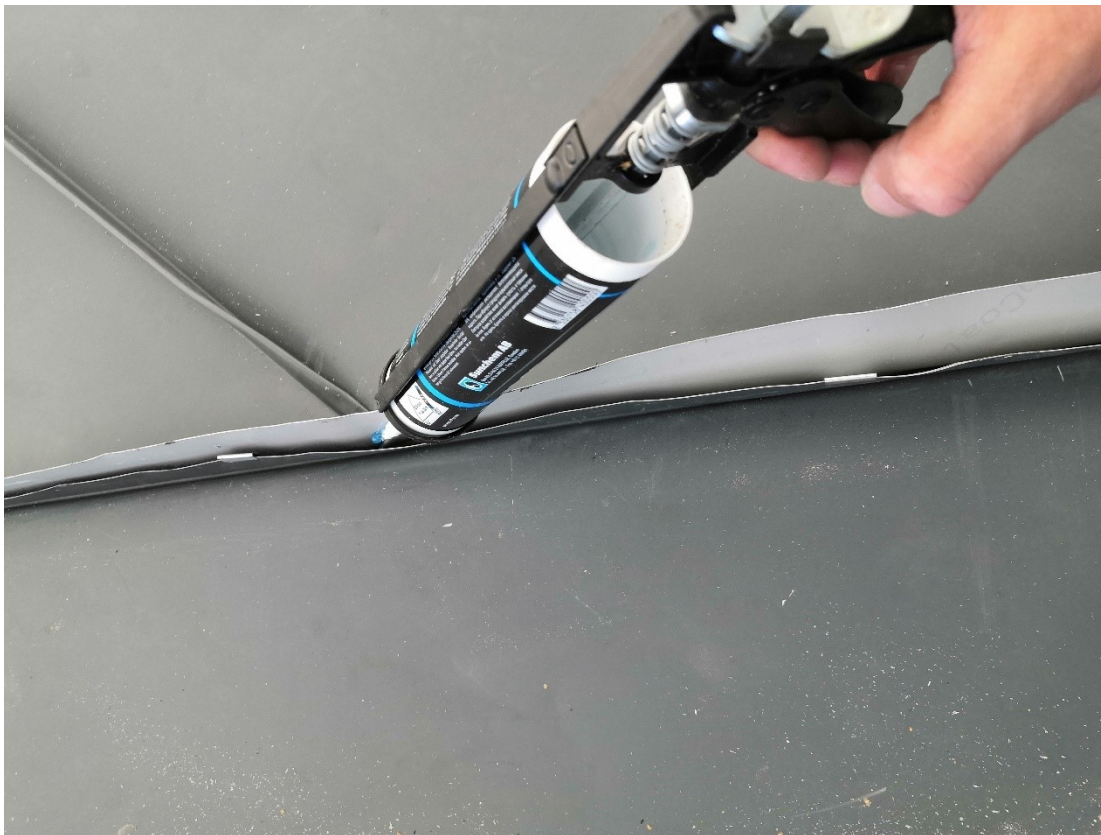
Kuva 270. Kun jiirin sauma on nostettuna pystyyn, voidaan tiivistysmassa levittää saumaan.
