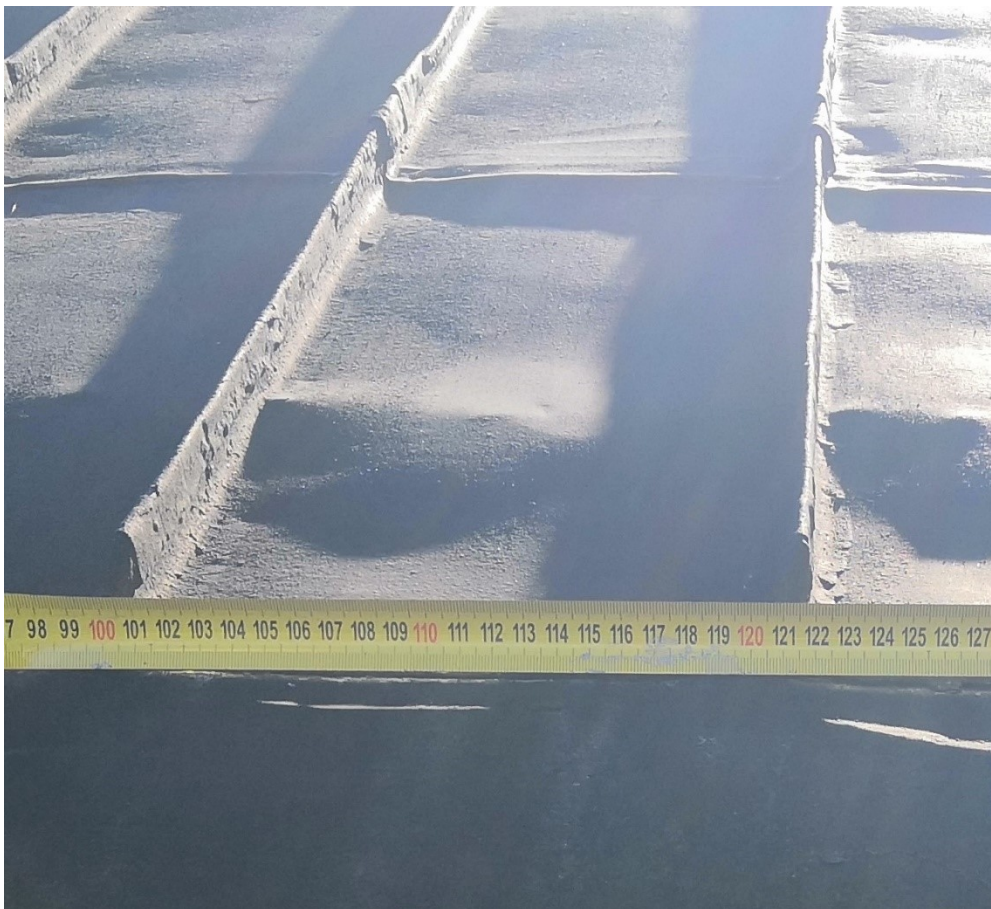
Kuva 149. Kallossa sijaitsevan rakennuksen kattorivin leveys on noin 200 mm.
