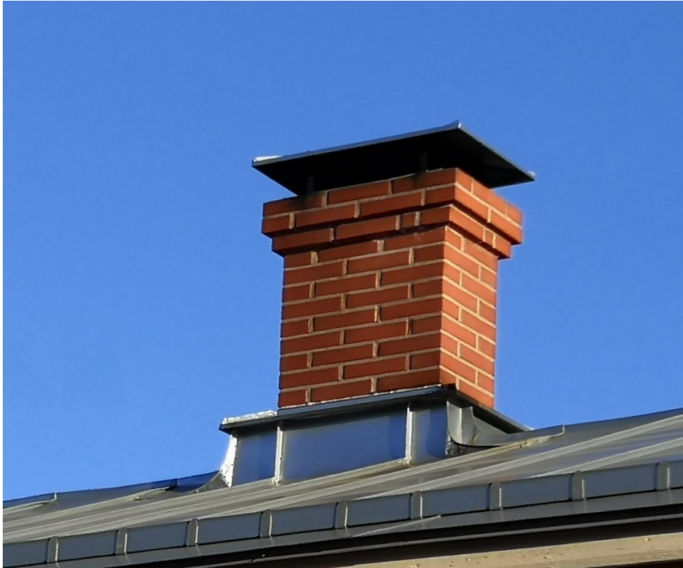
Kuva 65. Kuvassa kattoremontin yhteydessä uusittu hormin yläosa.
