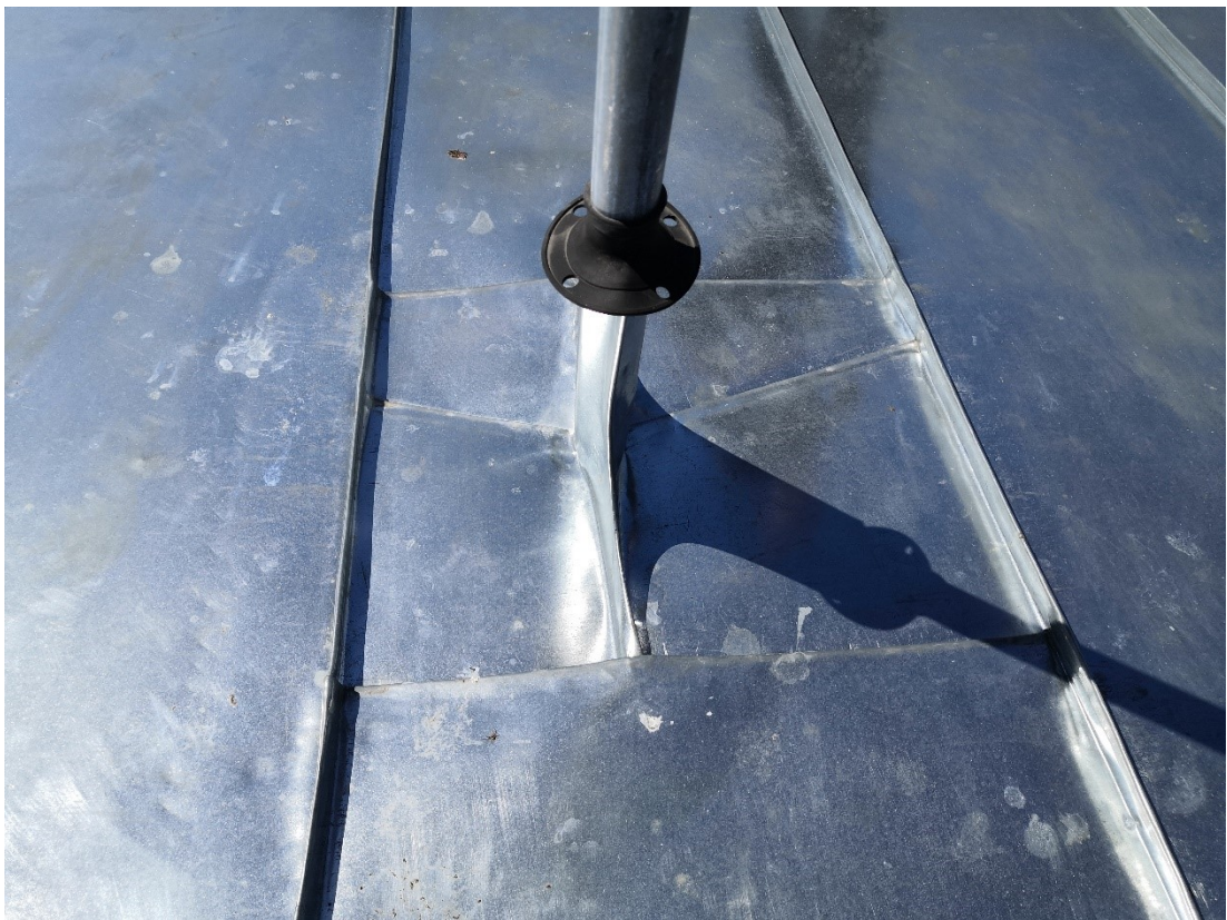
Kuva 314. Antennin läpivienti kuvattuna yläpuolelta.
