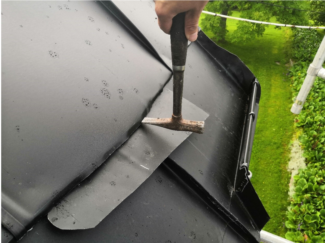
Kuva 99. Pelti taitetaan vasaraimalla englaan.
