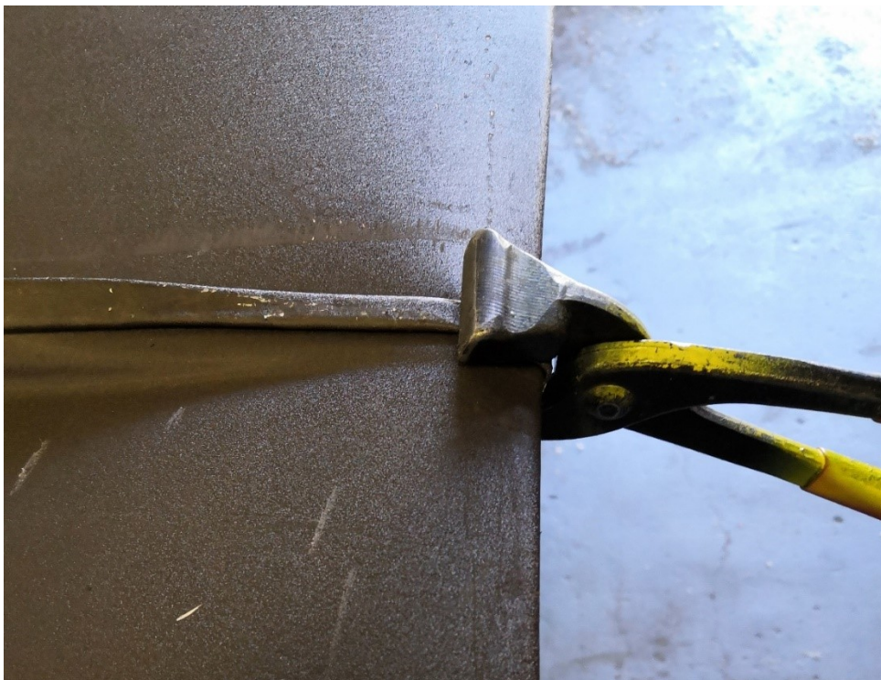
Kuva 169. Purkupihdit auttavat räystäään muotoilussa.
