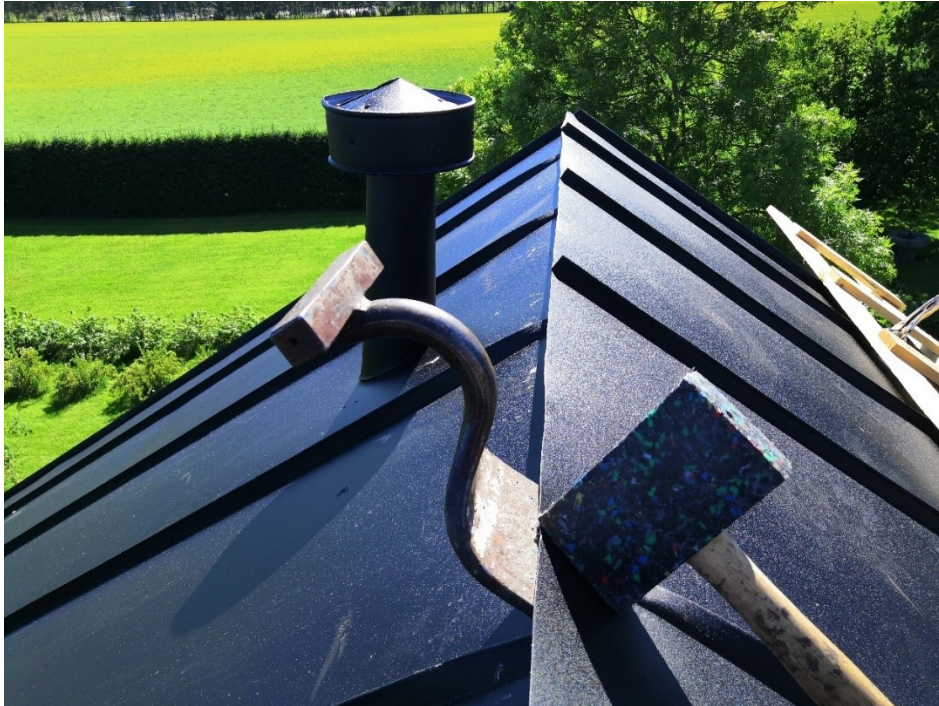
Kuva 235. Pystysaumamat kaadetaan lapion ja nuijan avulla.
