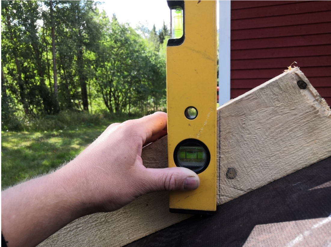
Kuva 302. Kattokulman määrittäminen kartiota varten vatupassin avulla.
