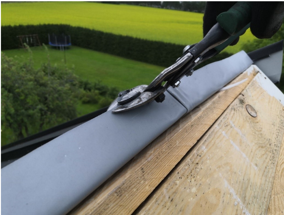
Kuva 233. Pellin reuna suoristetaan leikkaamalla. Kuvassa näky kuinka pelti on noussut irti alustasta kanttauksen aikana. Tilanne hoidetaan lyömällä nuijalla pellin reunaan, jolloin kulma painautuu paremmin kiinni alustaan.
