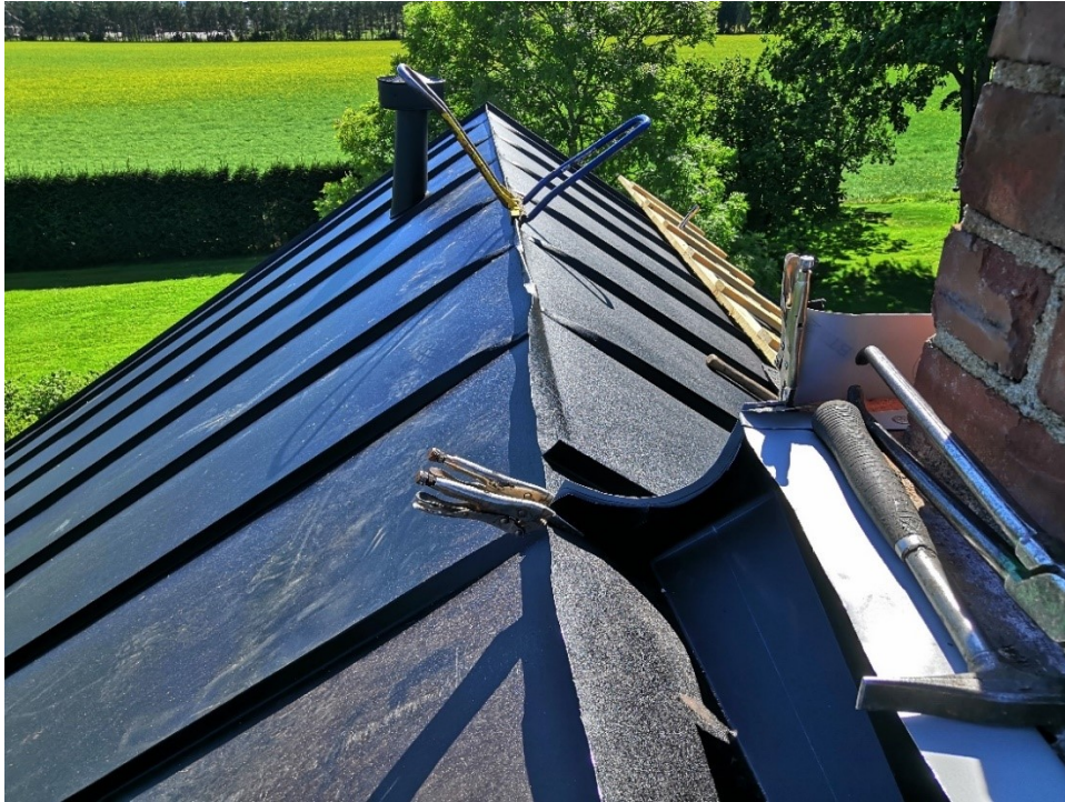
Kuva 239. Taustalla harjaa suljettuna yhdistelmäraudalla. Etualalla läpiviennin liittyminen harjasaumaan.
