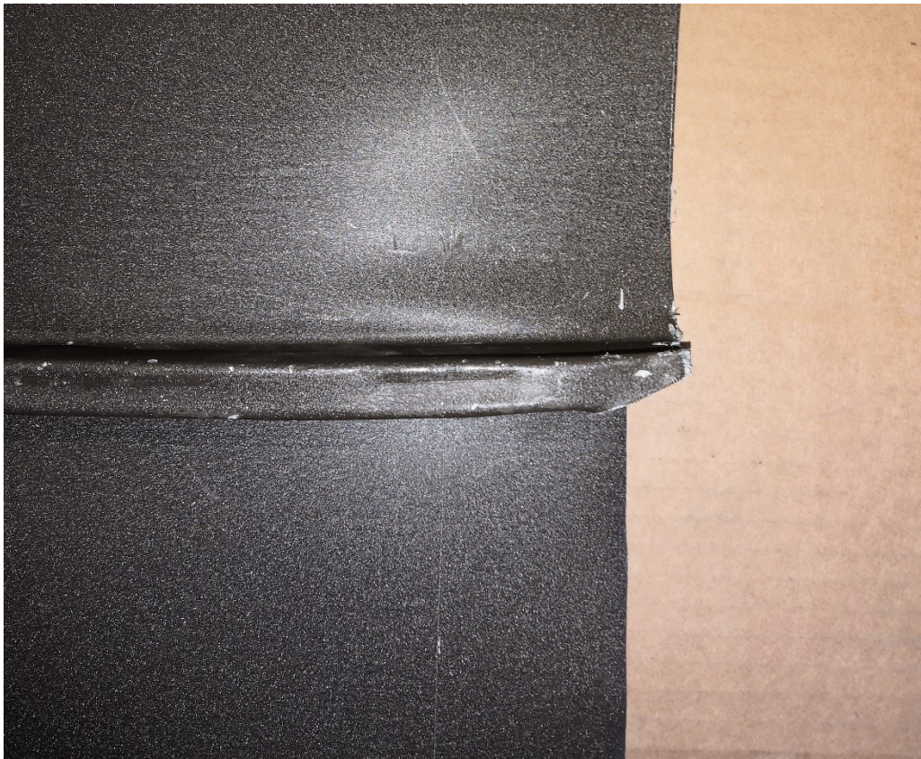
Kuva 181. Ison sauman puoli ulotetaan 10...15 mm pidemmälle. Saumauksen jälkeen pystysauma kaadetaan ja kaadetun pystysauman peltikerrokset avataan saumausta varten.
