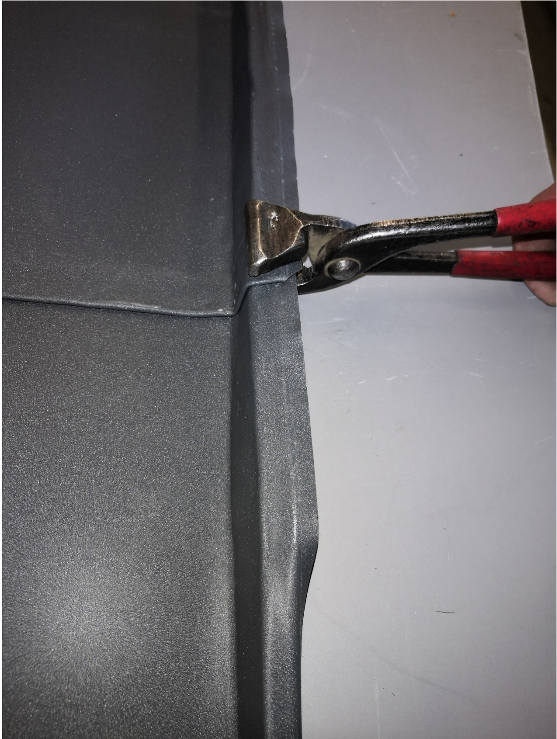
Kuva 143. Saumat nostetaan pystyyn ja muotoillaan esimerkiksi purkupihtien ja tuplasaumapihtien avulla.
