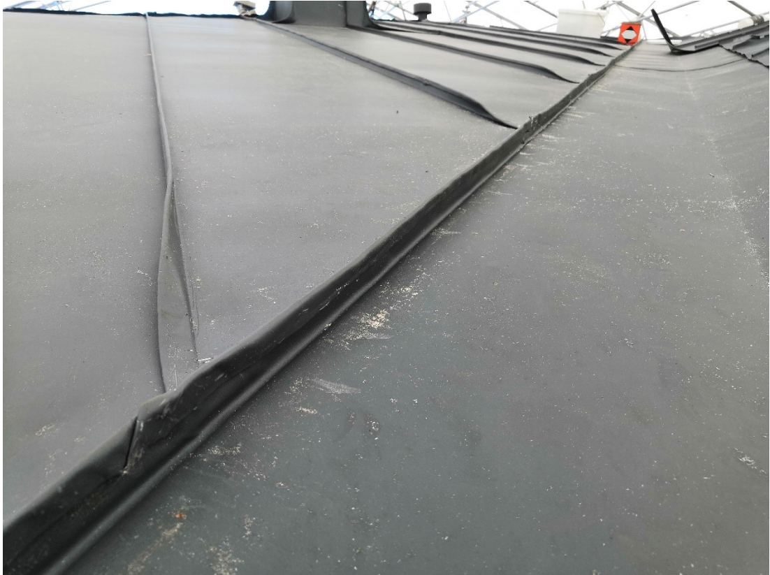
Kuva 267. sisäjiiri kuvattuna alaräystäään puolelta. Sauma kaadetaan eri suuntaan kuin räystäällä, veden kulkusuunnan vuoksi.
