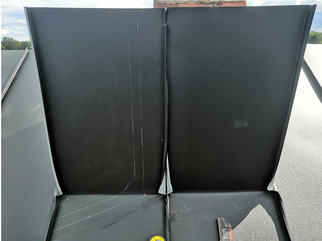
Kuva 84. Kaarisaumaa varten tulee jättää riittävästi peltiä. Veden kulkusuunnan vuoksi piipulle nousevan kattorivin ja piipun kulman sauma muotoutuu pieneksi saumaksi.
