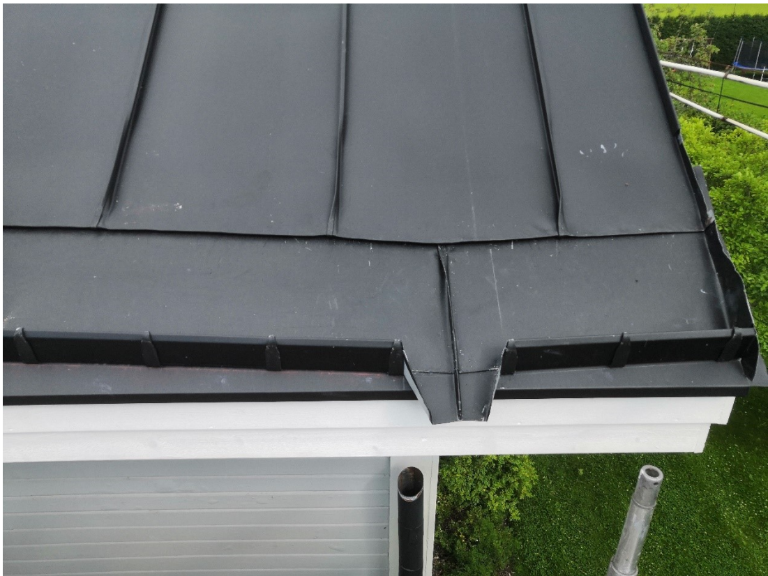
Kuva 82. Rivin pystysaumot valmiina koneellista sulkemista varten.
