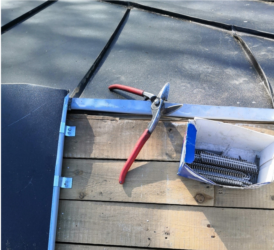
Kuva 68. Harjasaumassa peltiä joudutaan asennussyistä taivuttamaan puolelta toiselle. Kuvassa muita huomioitavia seikkoja ovat, ohennettu peltirivi, klemmareita naulattuna kahdella kiinnikkeellä, tyypillisiä klemmareiden kiinnikkeitä, sekä rivien kaatosuunta jirissä.
