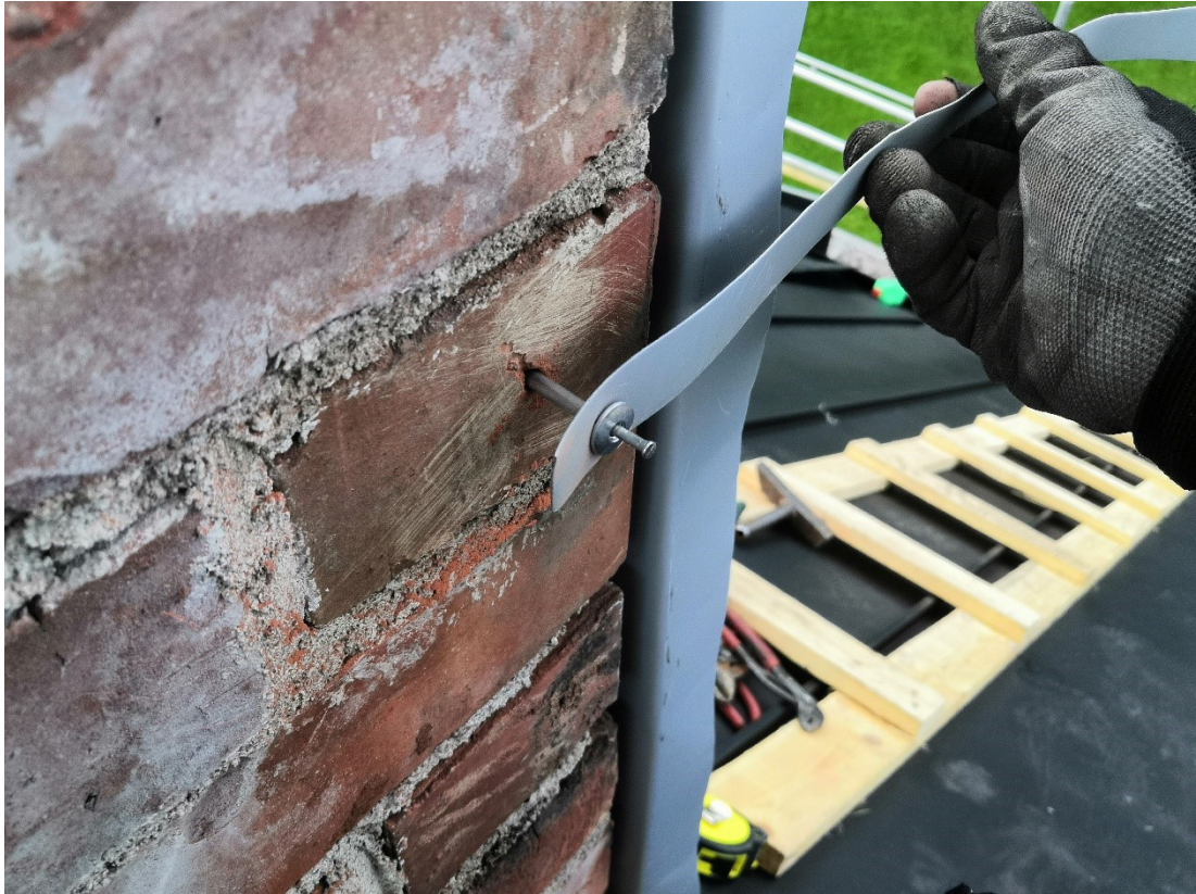
Kuva 88. Lyöntiniitti on osoittautunut erinomaiseksi klemmarin kiinnitykseen.
