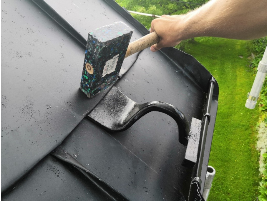
Kuva 100. Pellin englataitos kiristetään lapion ja nuijan avulla.
