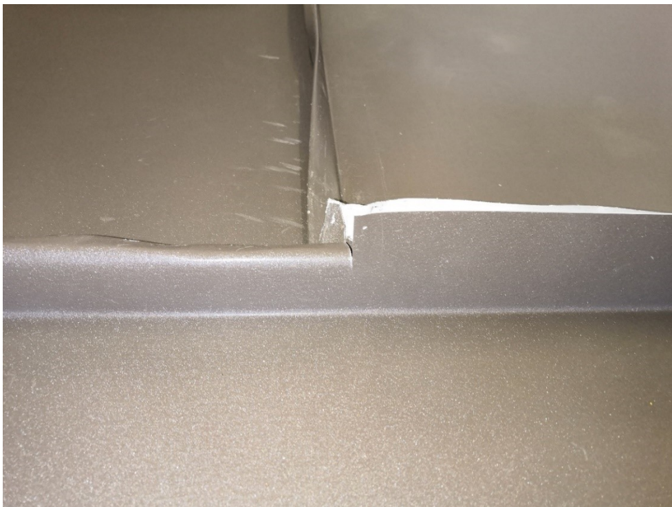
Kuva 185. Edellisen kuvan näkymä taustapuolelta. Peltikerrokset on käännetty pois saumauksen tieltä. Kuvassa vaalea kohta on pystyssä ollessaan noin 10 mm korkeampi kuin leikkauksen oikealla puolella näkyvä saumaamaton osuus.
