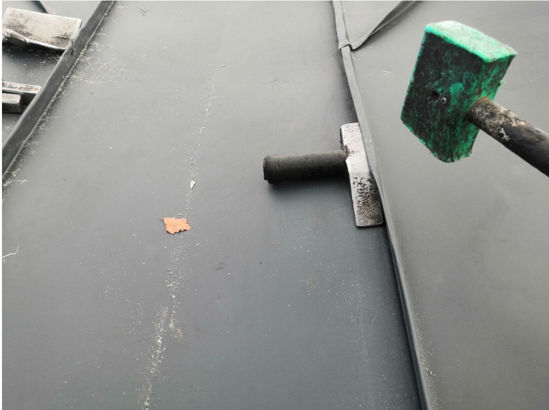
Kuva 273. Toisessa vaiheessa englataitos nuijitaan 90 asteen kulmaan. Vastarautana voidaan käyttää lapiota, harjarautaa tai kosakkaa.
