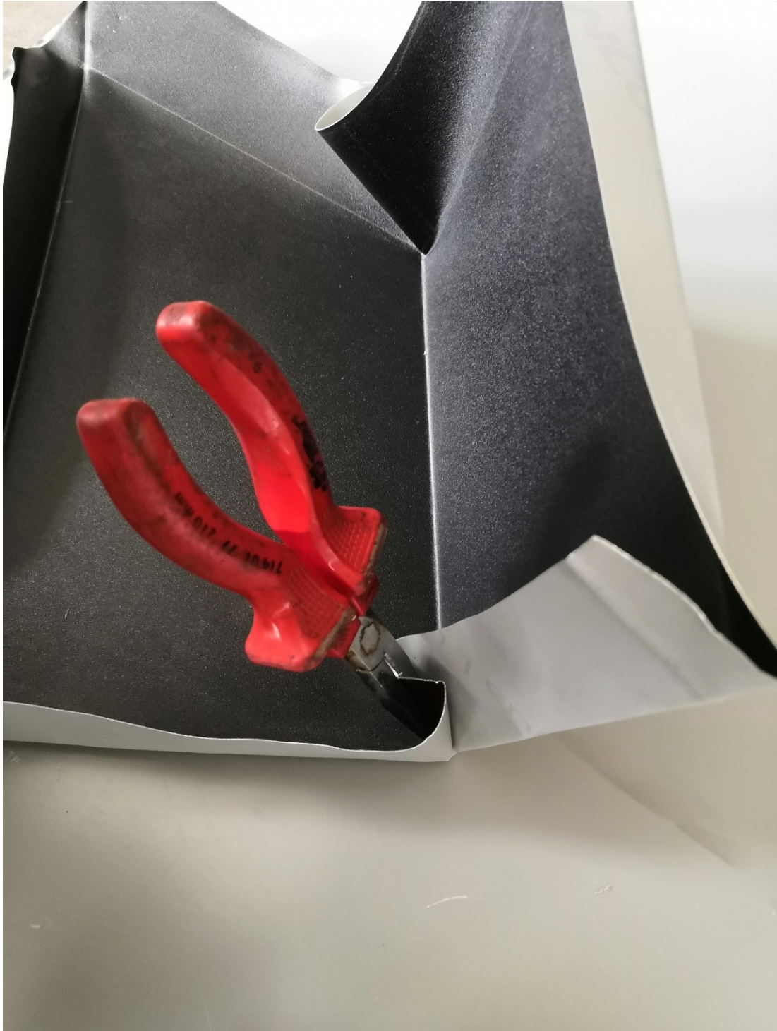
Kuva 151. Ropposen muotoilua.
