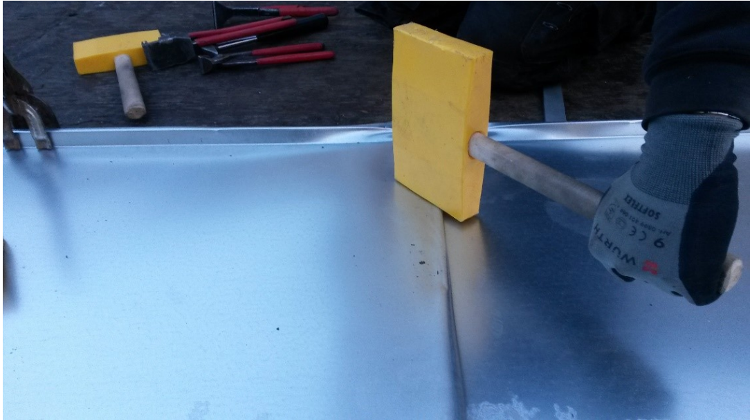
Kuva 134. Laskos suljetaan.
