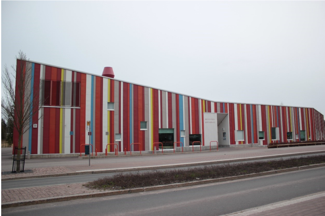
Kuva 319. Painiityn päiväkodin seinäpellitys. Kuva Samuli Lehtola 2020.
