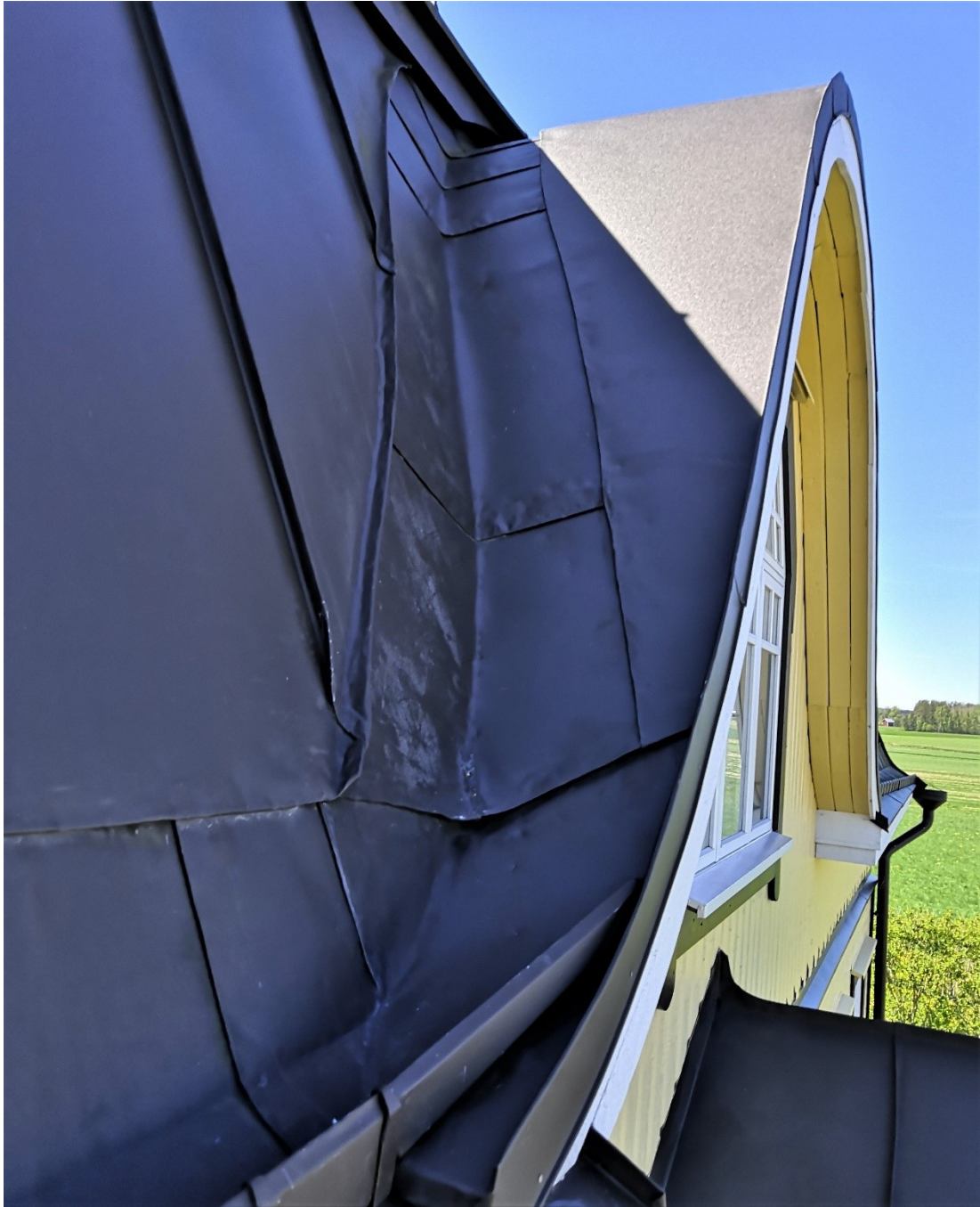
Kuva 78.Laskoksia kaarevan Mansardipoikkiharjan jiiripellissä.
