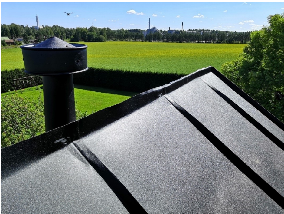
Kuva 236. Ensiksi harjalla pidempi pelti kantataan 90 asteeseen, pellin reuna leikataan suoraan ja taiteetaan englaan.
