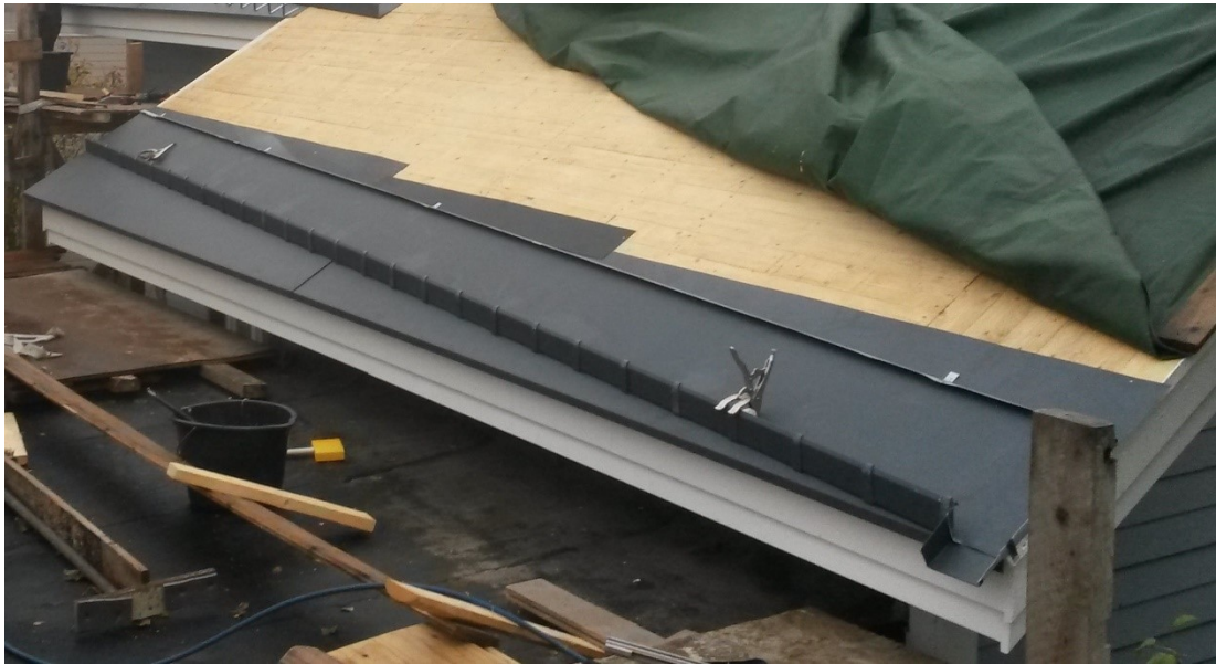
Kuva 247. Jalkaränniä asennettuna. Huomaa takasauman yli jatkettu räystäspelti.
