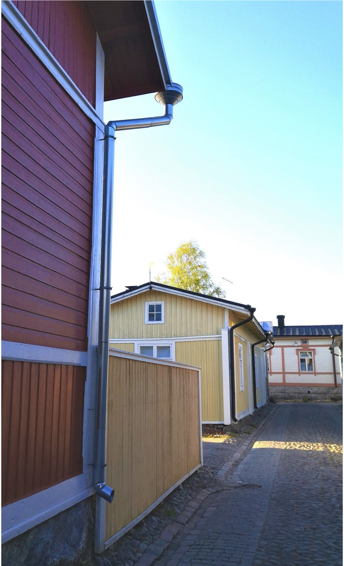
Kuva 220. Käsin saumattu syöksytörvi asennettuna.
