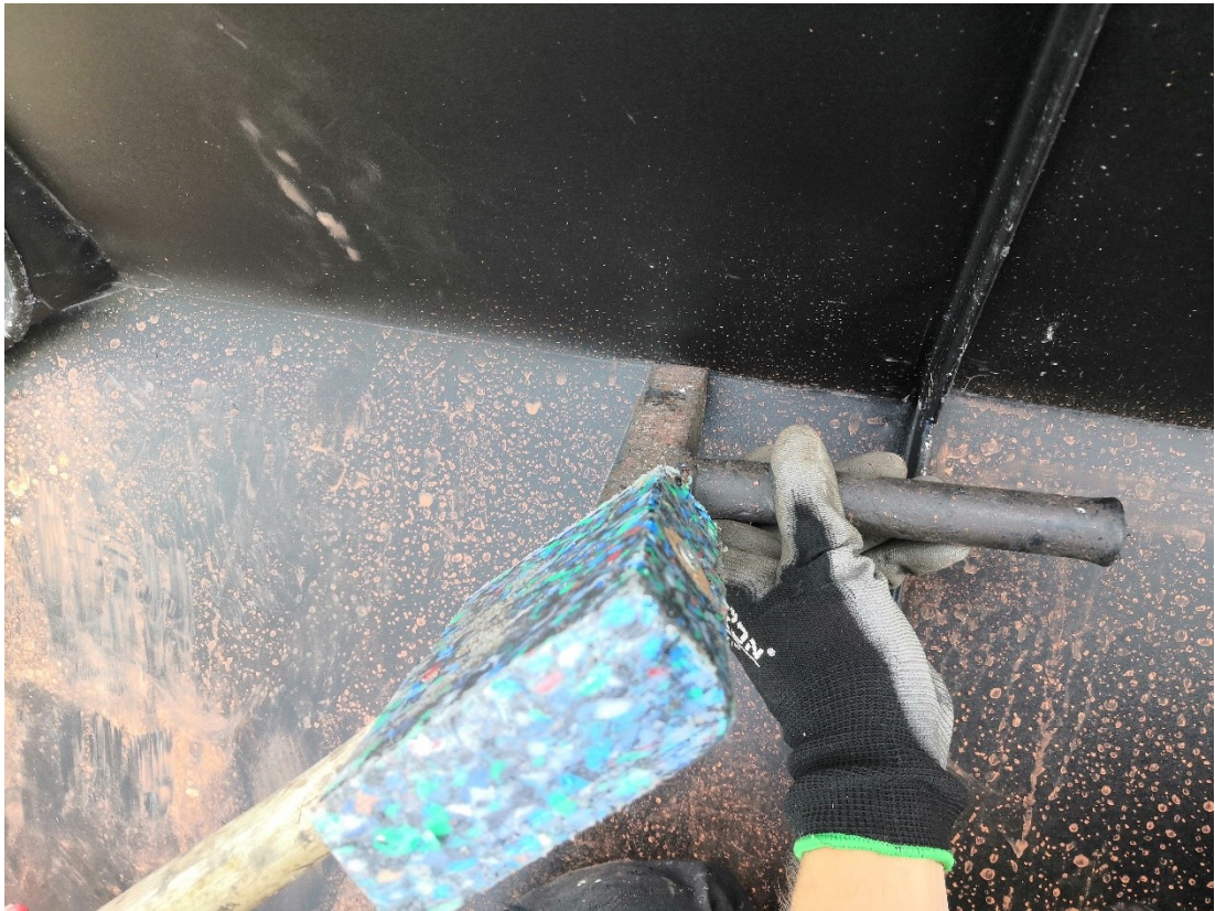
Kuva 97. Kulman kiristys poistaa jännityksiä ja niistä johtuvia lommoja. Kuvassa lyöntiniitin porareikästä tullutta punatiilen pölyä, joka kannattaa huuhtoa pois mattapinnoitetulta pelliltä työn päätteeksi.
