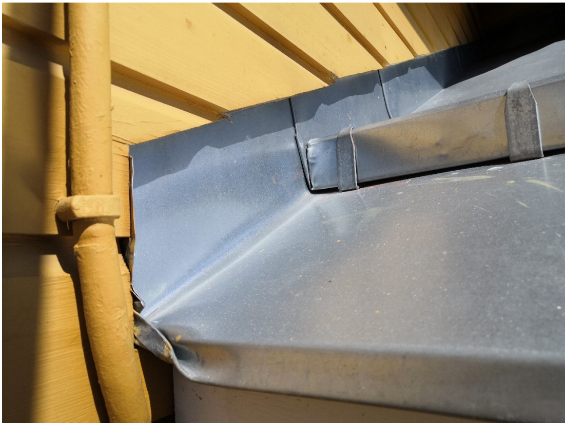
Kuva 281. Räystään tippanokka on käännetty pienen ropposen avulla taitokseksi, joka siirtää räystäspellille satavanveden pois seinän viereltä. Pääosa vedestä kulkeutuu pitkin jalkaränniä.
