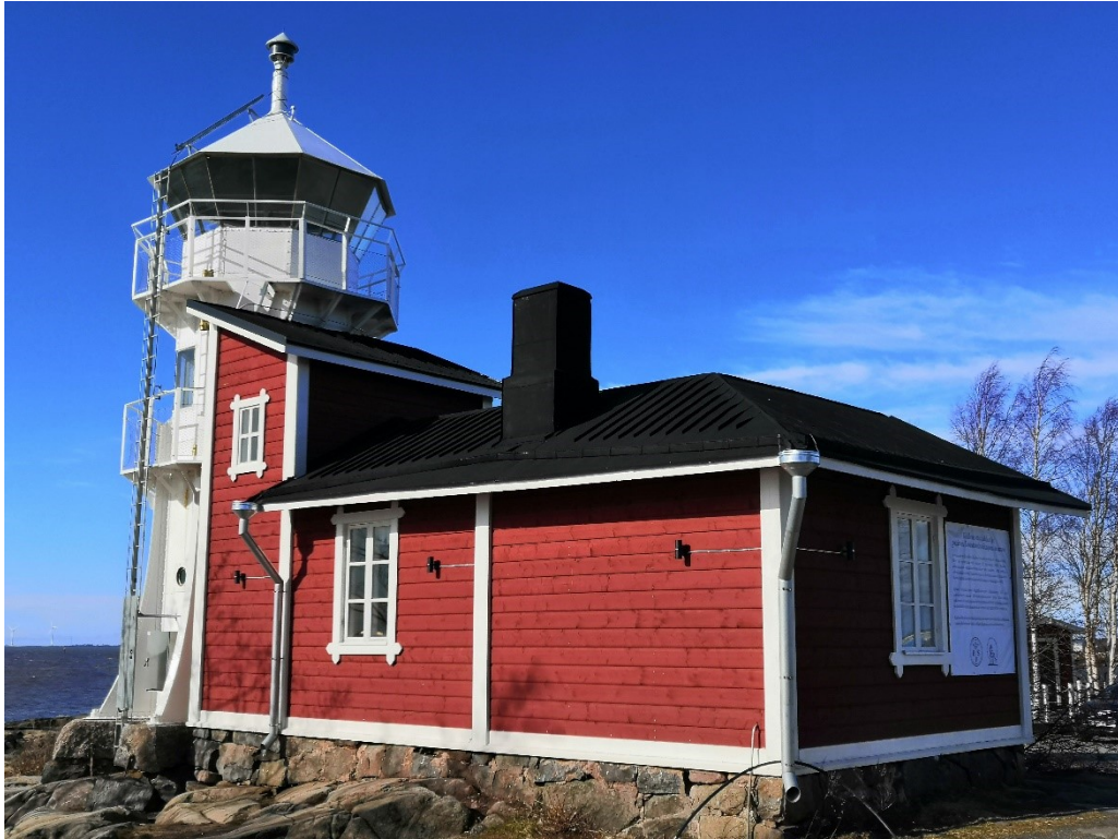
Kuva 148. Kallon majakka Porissa.
