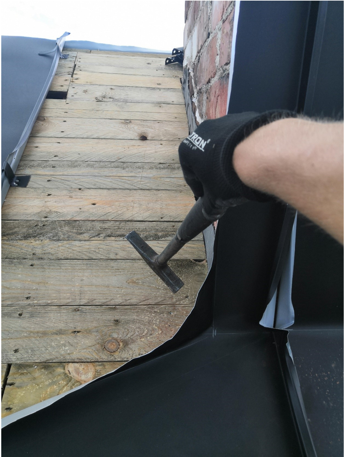
Kuva 87. Kaaren muotoilua vasaralla.
