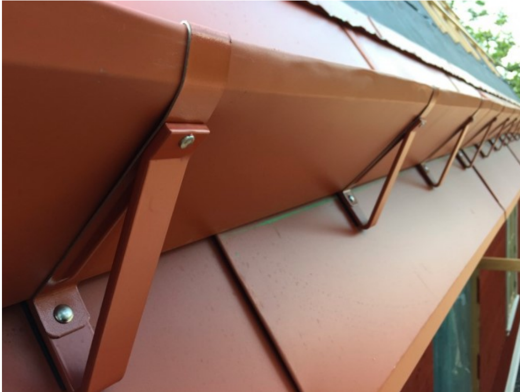
Kuva 255. Koukkujen erilainen muotoilu vaikuttaa paljon koukullisen jalkarännin yleisilmeeseen. Kuva Herregårdshusin kotisivut 2016.
