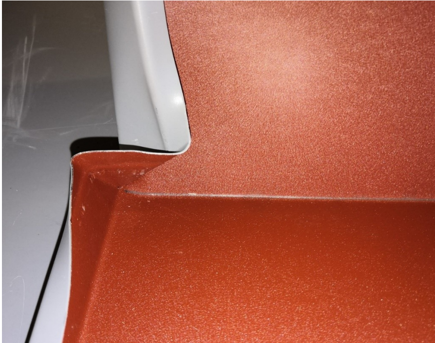
Kuva 173. Peltiä nostetaan kulmaan vaiheittain.
