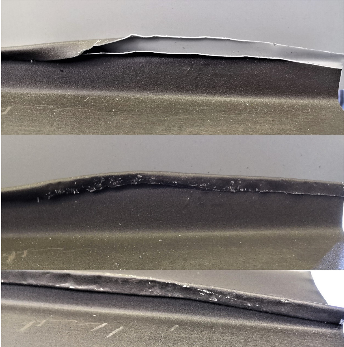
Kuva 167. Rotanhännän saumaaminen.
