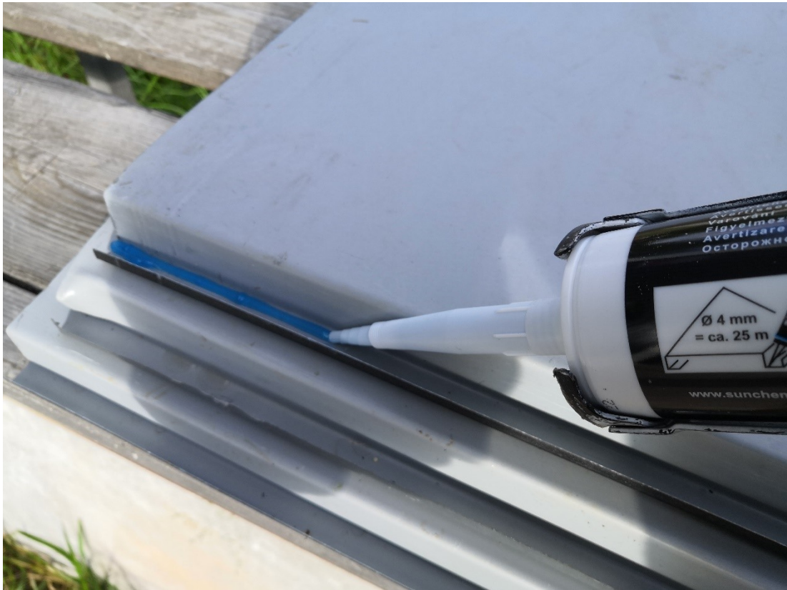
Kuva 128. Tiivistysmassan levitys isoon saumaan. Pelti käännetään taustapuoli ylöspäin ja massa levitetään saumaan. Huomaa massatuubissa näkyvä levitysohje.
