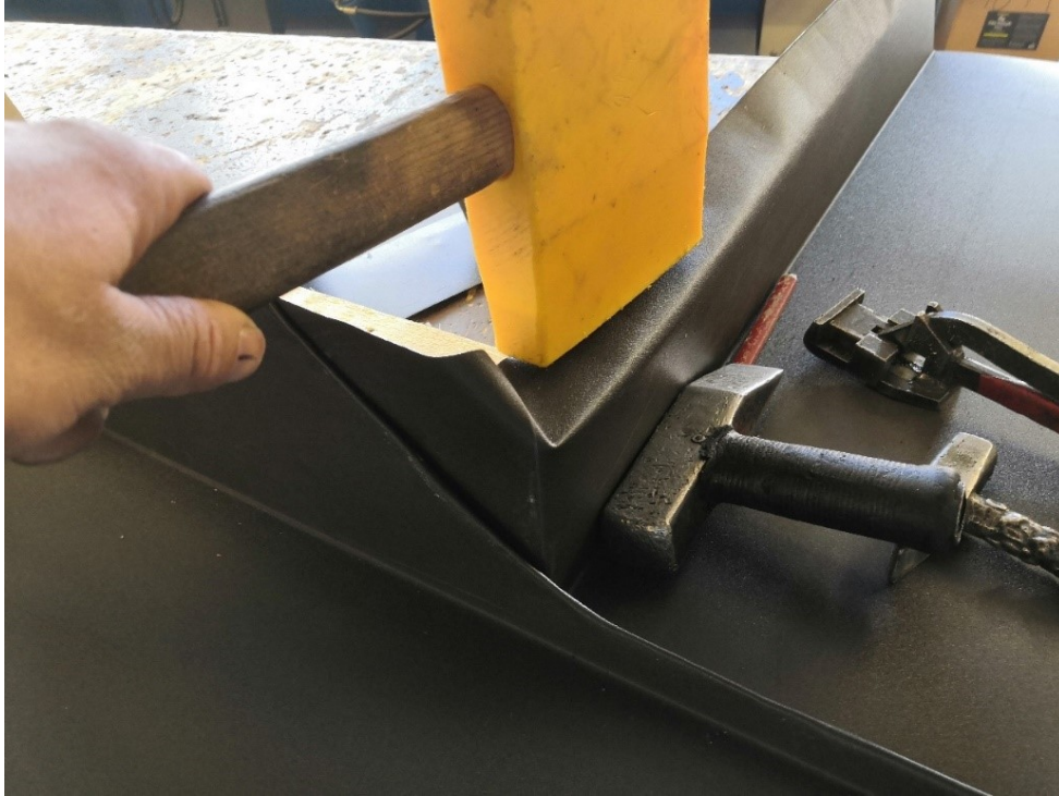
Kuva 164. Tässä tapauksessa yläreuna muotoillaan ja kiinnitetään alustaan.
