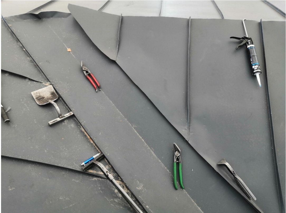
Kuva 268. Rivipeltien alaosaan tehdään ohennus eli rotanhäntä saumausta helpottamaan.
