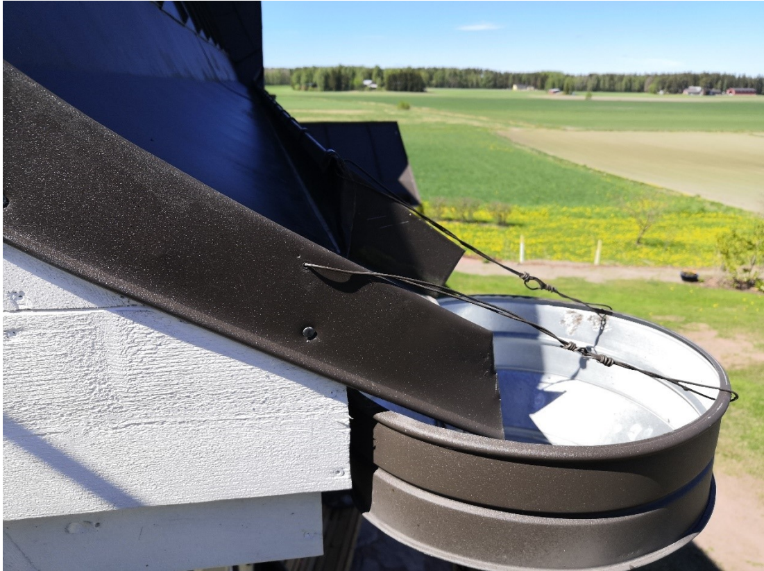
Kuva 217. Tratti ruuvataan lotokan alta otsalautaan kahdella ruuvilla, ja etureunasta viedään kaksi rautalankaa kattoon. Rautalangat ottavat vastaan lumikuormasta aiheutunutta vetoa.
