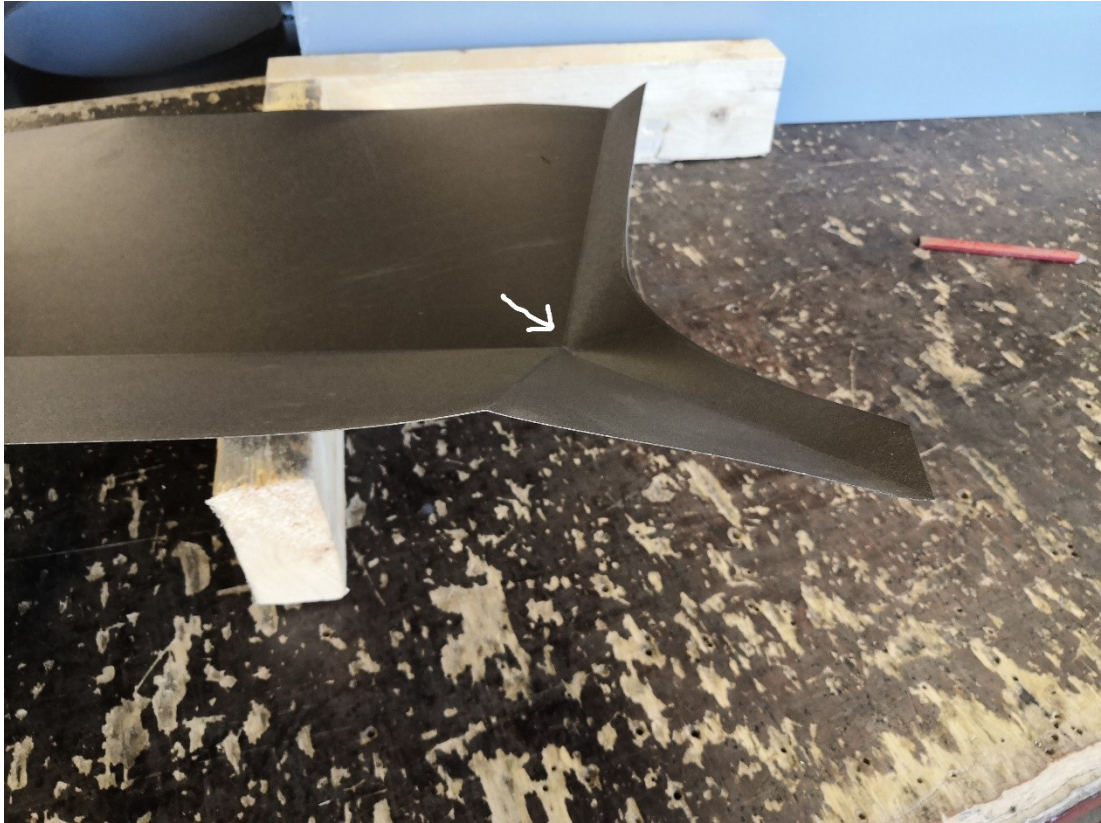
Kuva 155. Esitaivutukset kuvattuna läpiviennin puolelta. Huomaa kanttauksen suunnan vaihtuminen esitaivutusten risteyskohdassa.
