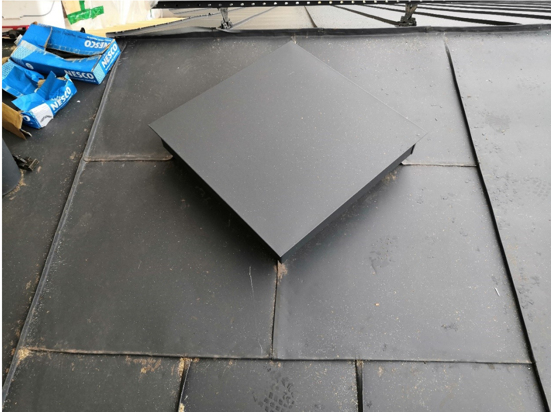
Kuva 298. Kattoluukku I asennettuna.
