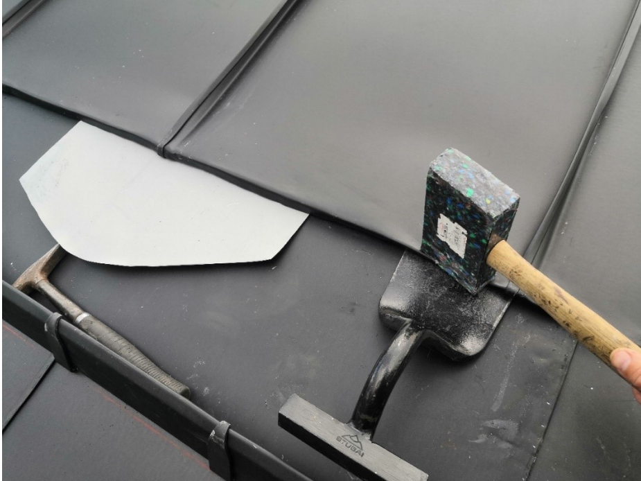
Kuva 102. Takasauman kiristäminen tuplaan on samankaltainen työvaihe kuin englataitoksen kiristäminenkin.
