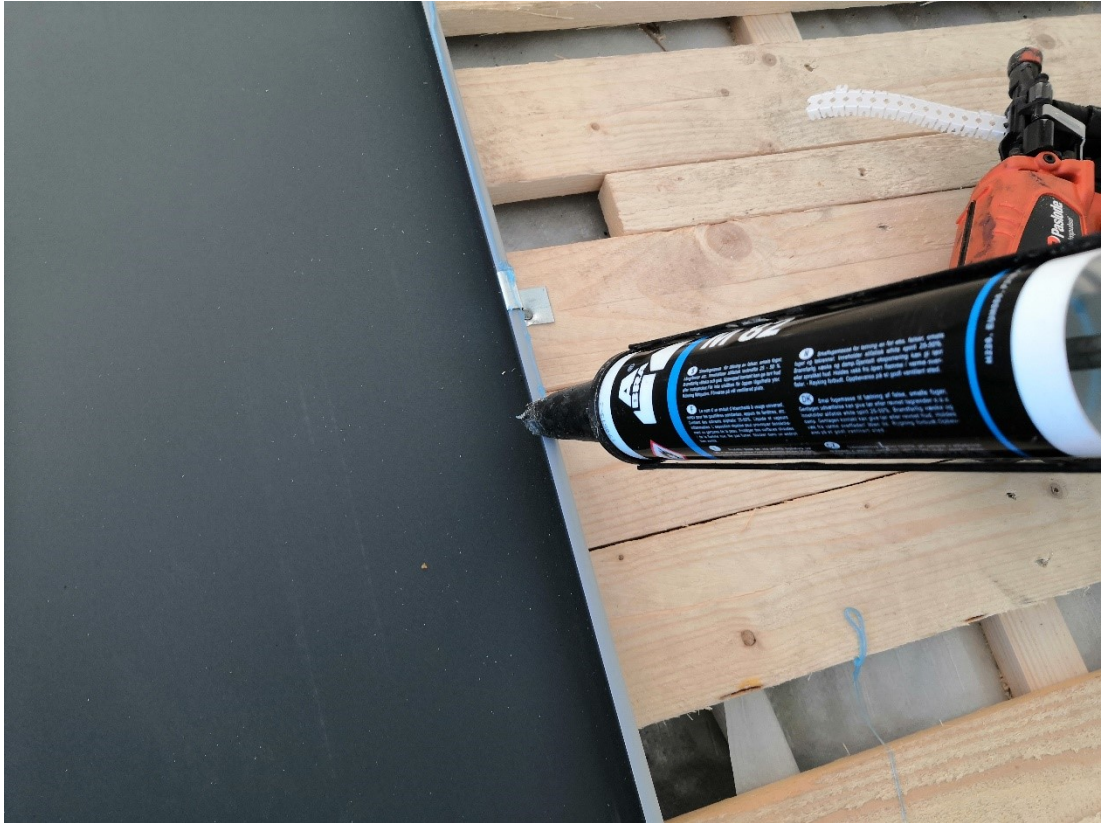
Kuva 129. Massan levitys pieneen saamaan leveämmän suukappaleen avulla.
