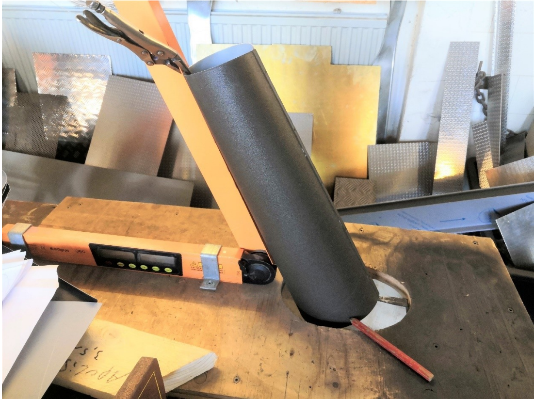
Kuva 303. Kattokulman jäljentäminen kartioputkeen. Huomaa sauman suunta, joka on alaräystästä kohden.
