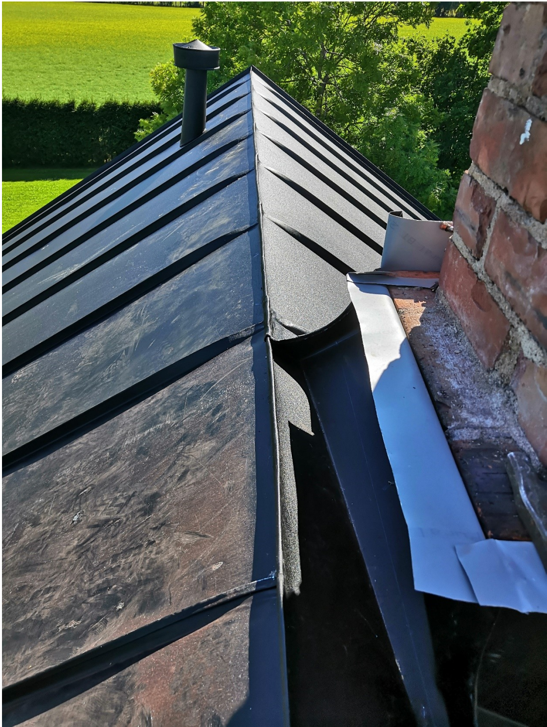
Kuva 241. Harjasauma päältäpäin kuvattuna.
