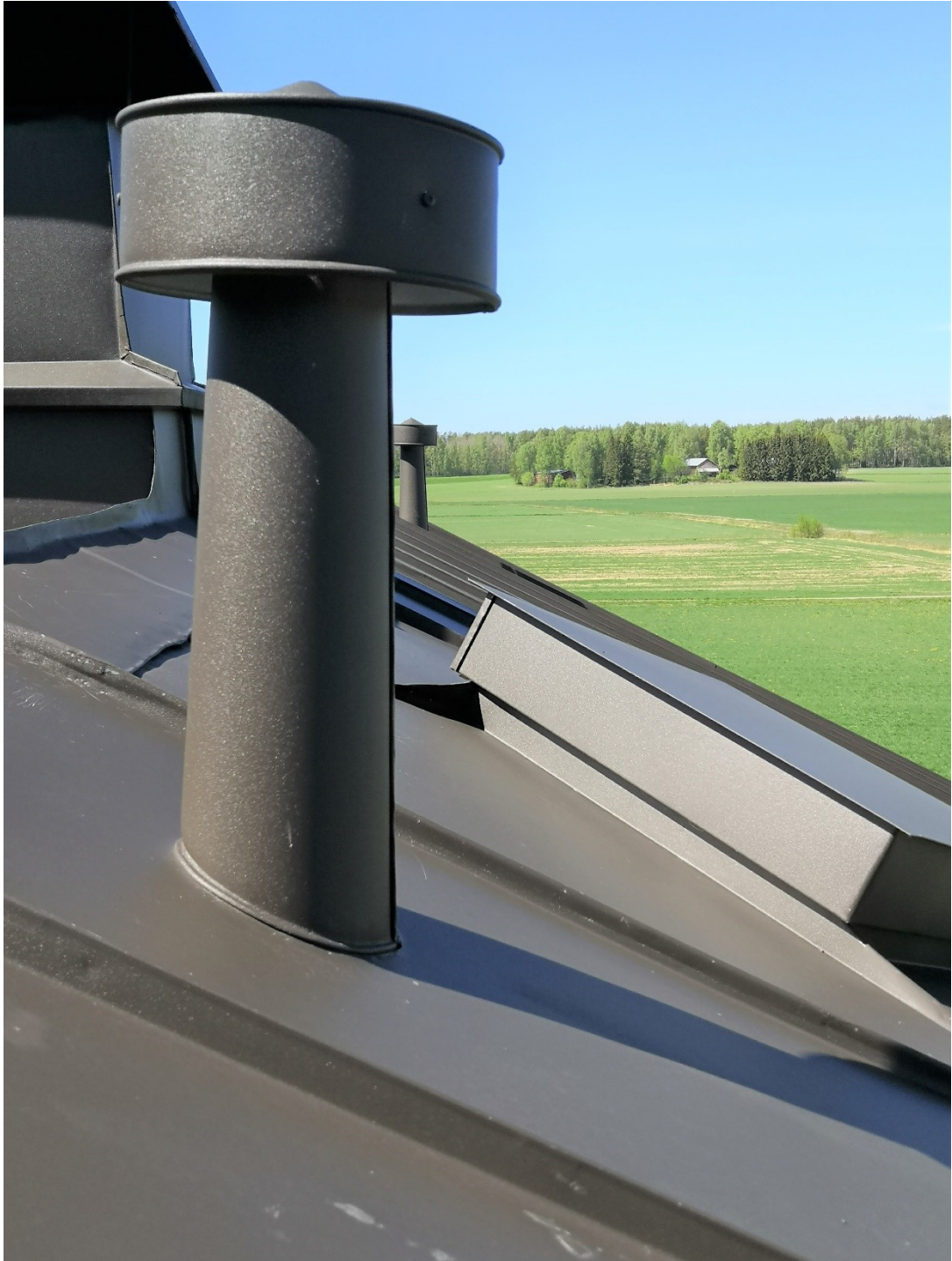
Kuva 311. Alipainetuuletin asennettuna. Taustalla näkyy kattoluukku I ja polviippi.
