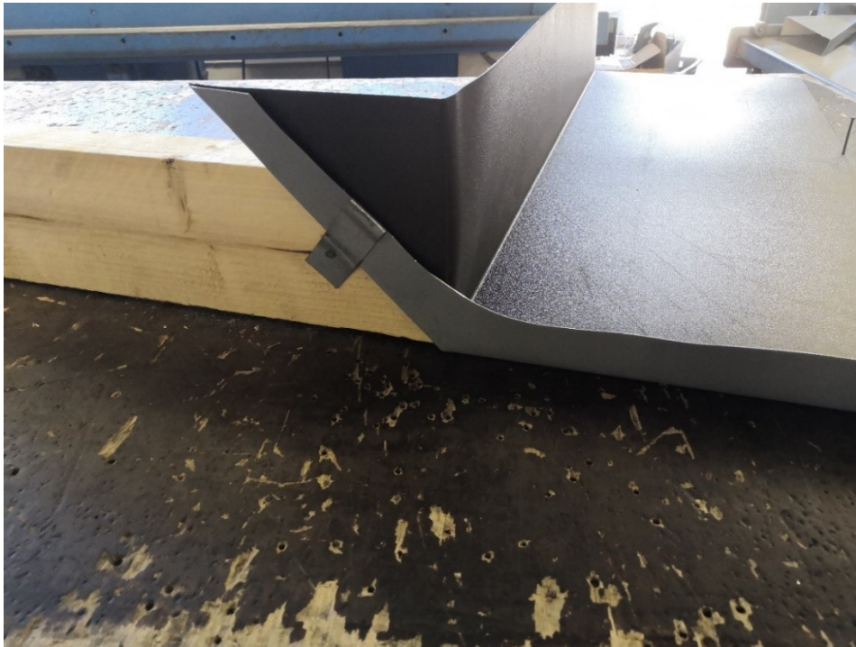
Kuva 158. Taitoksen ensimmäinen pelti siistitään ja kiinnitetään alustaan.
