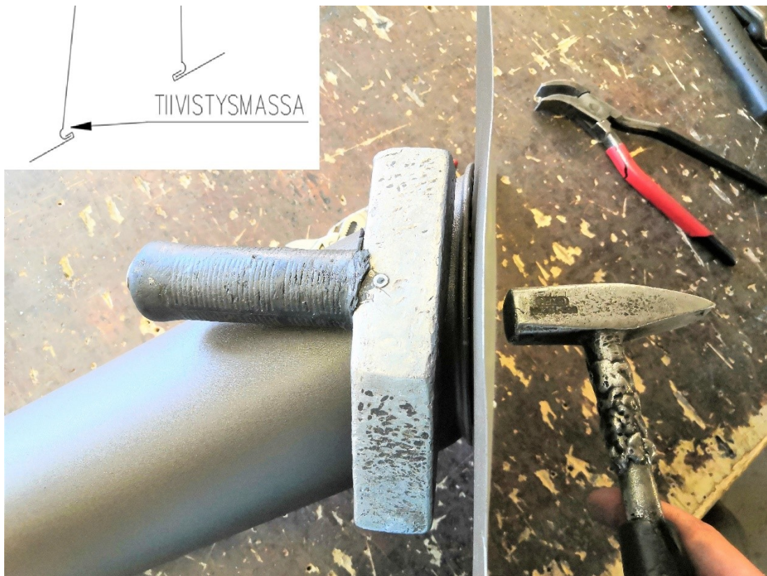
Kuva 309. Tiivistysmassan paikka sekä kartion sauman sulkeminen kosakan ja vasaran avulla.
