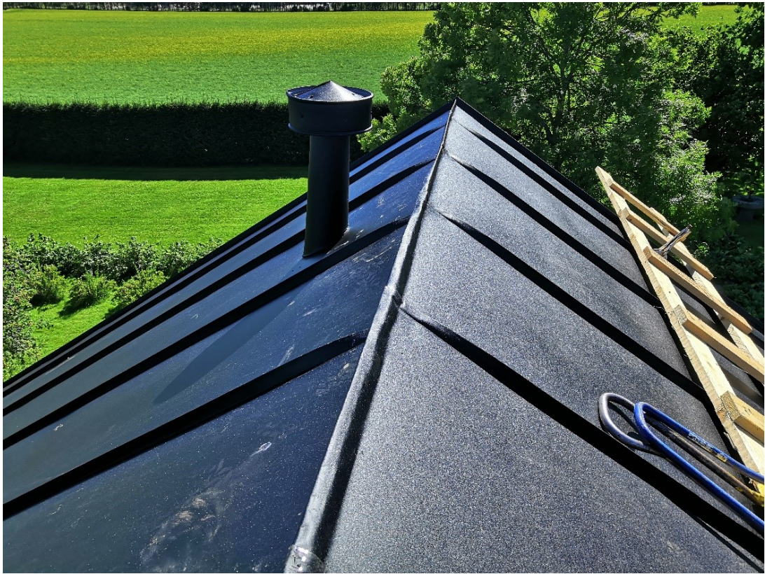
Kuva 238. Harjasauman tuplataitoksen kantti alustavasti taitettuna. Tässä vaiheessa harjan korkeuteen ja suoruuteen voidaan vaikuttaa.
