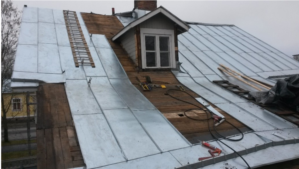
Kuva 136. Laskostamalla tehtyjä peltirivejä paikoillaan asennettuna.
