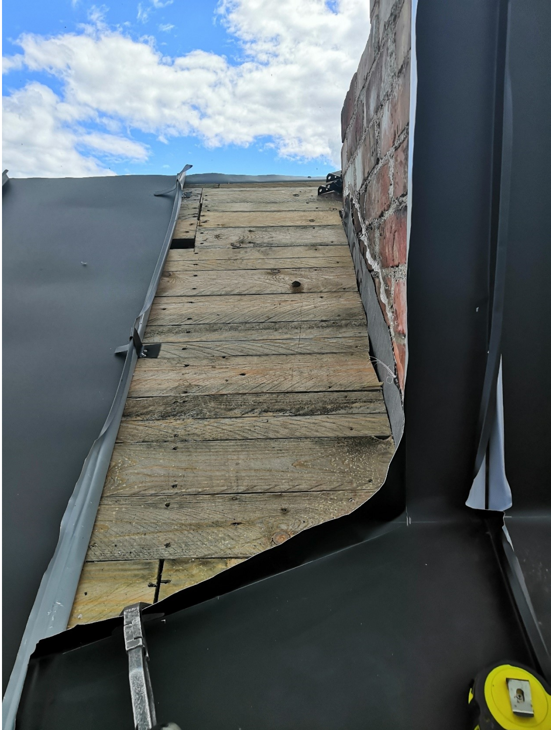
Kuva 86. Kanttaamien tehdään vaiheittain, jotta saumaan tulisi mahdollisimman vähän lommoja.
