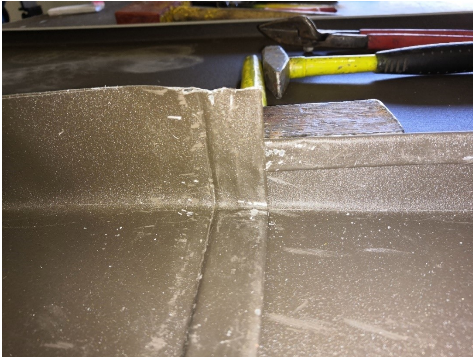
Kuva 186. Oikea puoli saumattuna. Jatkoskohta jää kaadetun osan alle piiloon.
