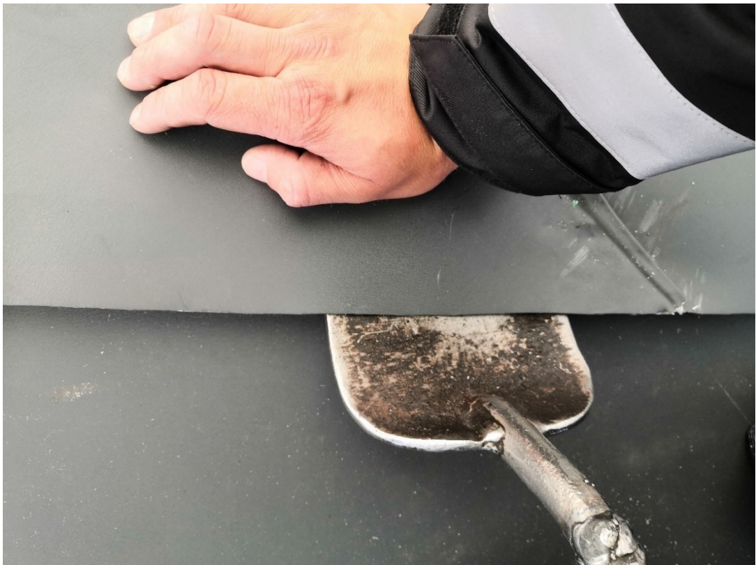
Kuva 269. Ennen sauman pystyyn nostamista, voidaan lapion avulla nostaa kaadettua osuutta ylöspäin. Tällöin kattopihdit on helpompi sovittaa paikoilleen kanttaamista varten.
