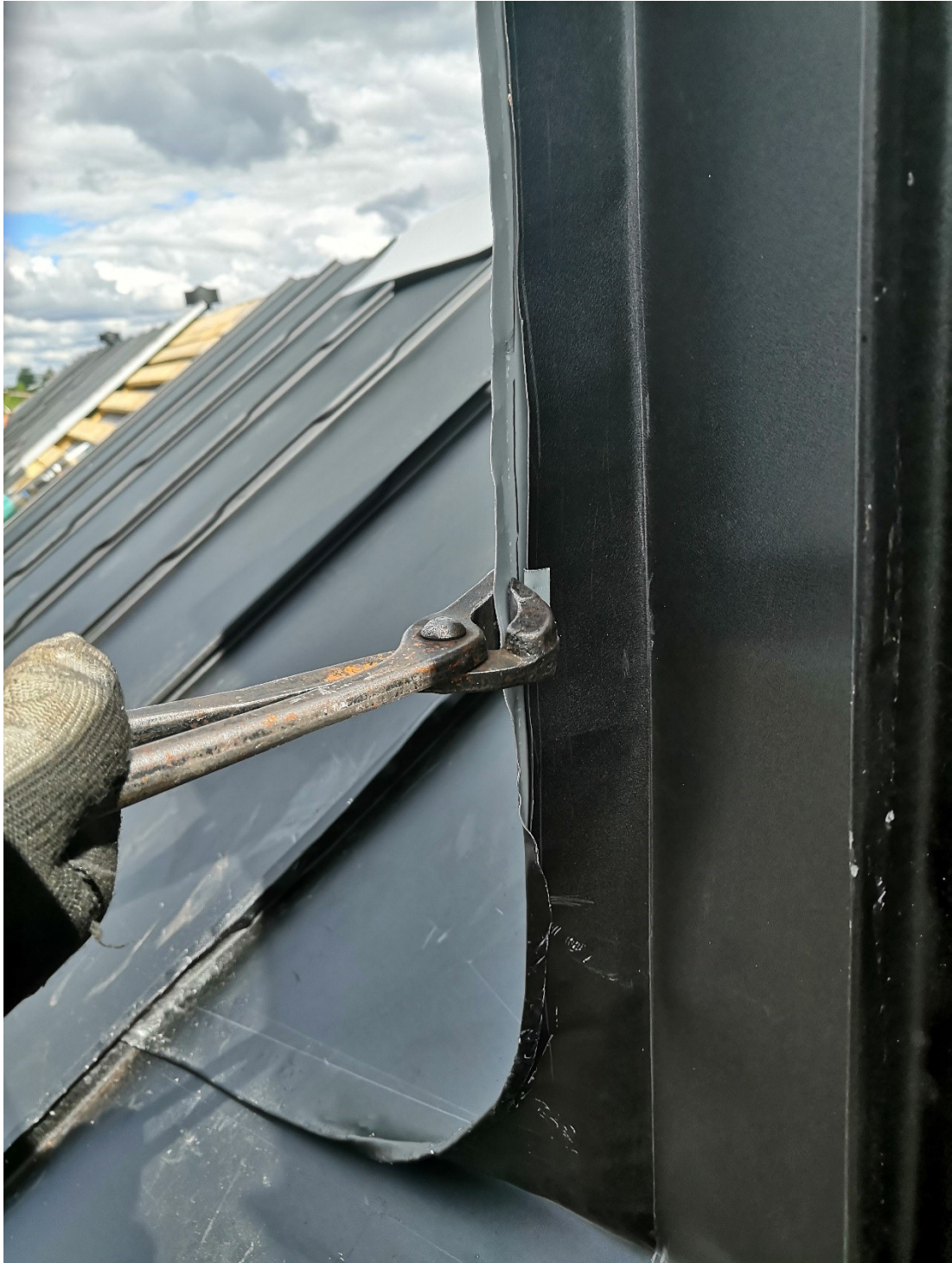
Kuva 93. Kaarisauma saumataan englaan kaaren kohdalta. Tässä työvaiheessa purkupihdit ja -tai siirtoleukapihdit ovat suureksi avuksi.
