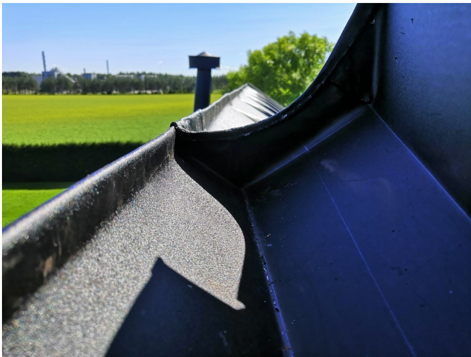
Kuva 240. Valmistaa harjasaumaa lähikuvassa. Pystysaumojen kohdalla harja on luonnostaan hieman korkeammalla.
