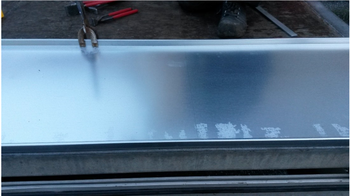
Kuva 130. Pelti kiinnitetään tukevasti paikoilleen suoralle alustalle. Tässä pelti kiinnitettiin hitsarimallin lukkopihdeillä alustaan ruuvattuun kulmarautaan, ison sauman puolelle. Pellissä näkyvä valkoinen on sinkkipinnoitteelle tavanomaista valkoruostetta ks. luku 6.10.
