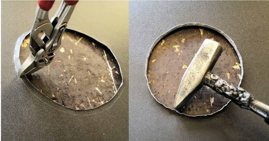
Kuva 307. Nosto tehdään viivan mukaan. Nosto ei tule kantata viivan yli, tällöin sovituksesta tulee ahdas ja saumaaminen vaikeutuu.
