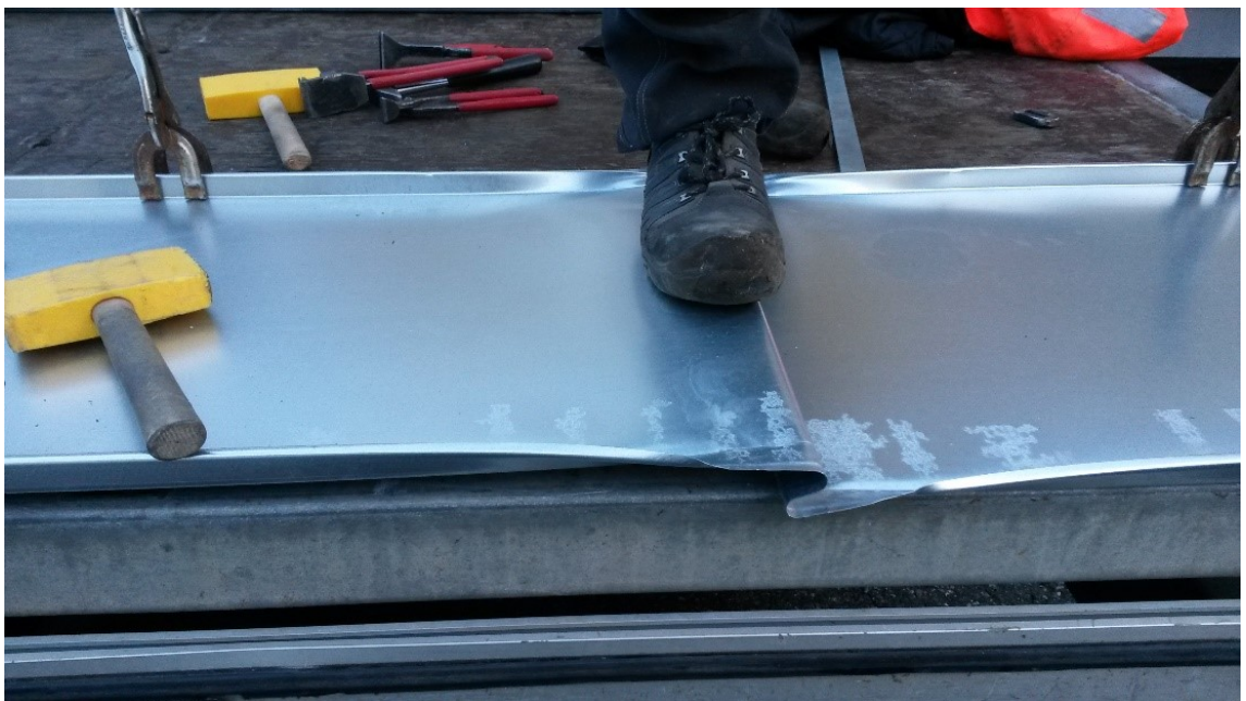
Kuva 133. Rivin kumpikin pää kiinnitetään kulmarautaan ennen laskoksen sulkemista.
