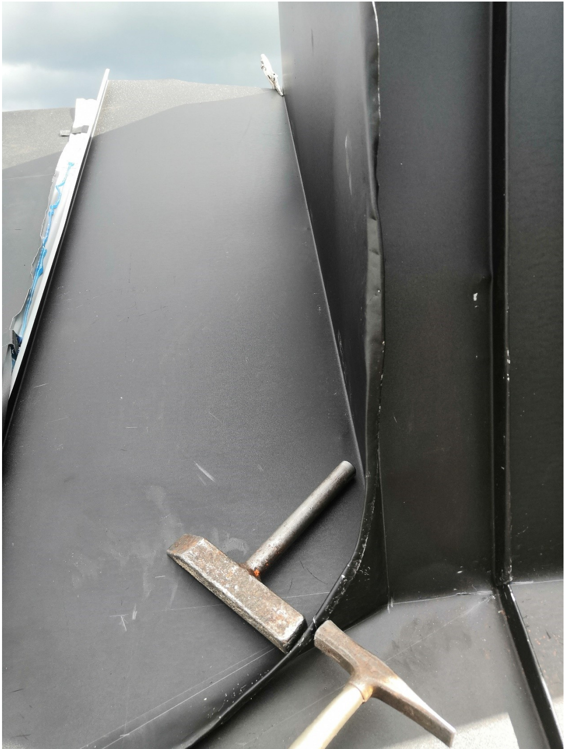
Kuva 95. Sauma vasaroidaan lopuksi kiinni kosakkaa vasten.
