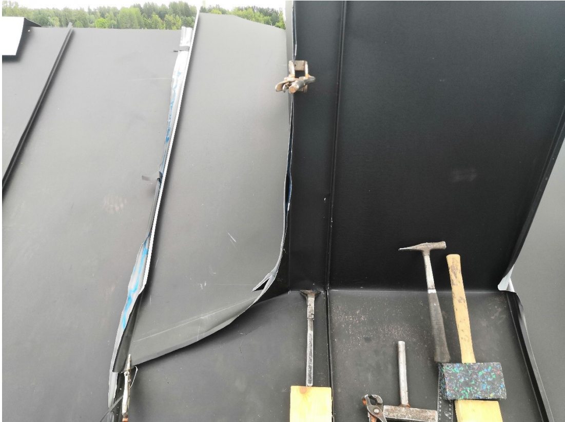
Kuva 90. Sivupalan saumaus aloitetaan kiinnittämällä se alustaa lukkopihkien avulla. Saumoihin tulee tiivistysmassa. Ropponen on vielä osittain avoinna.
