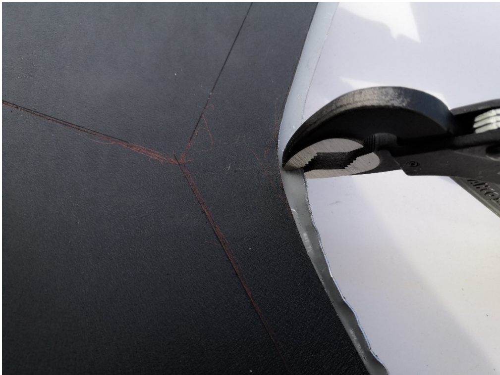
Kuva 35. Siirtoleukapihdit ovat erittäin käytännölliset kaarisaumojen saumauksissa.
