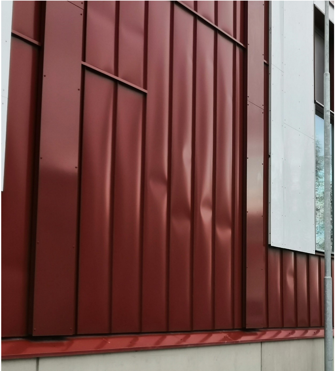
Kuva 12. Lommahdusta Porin puuvillan kauppakeskuksen seinäpellityksessä.
