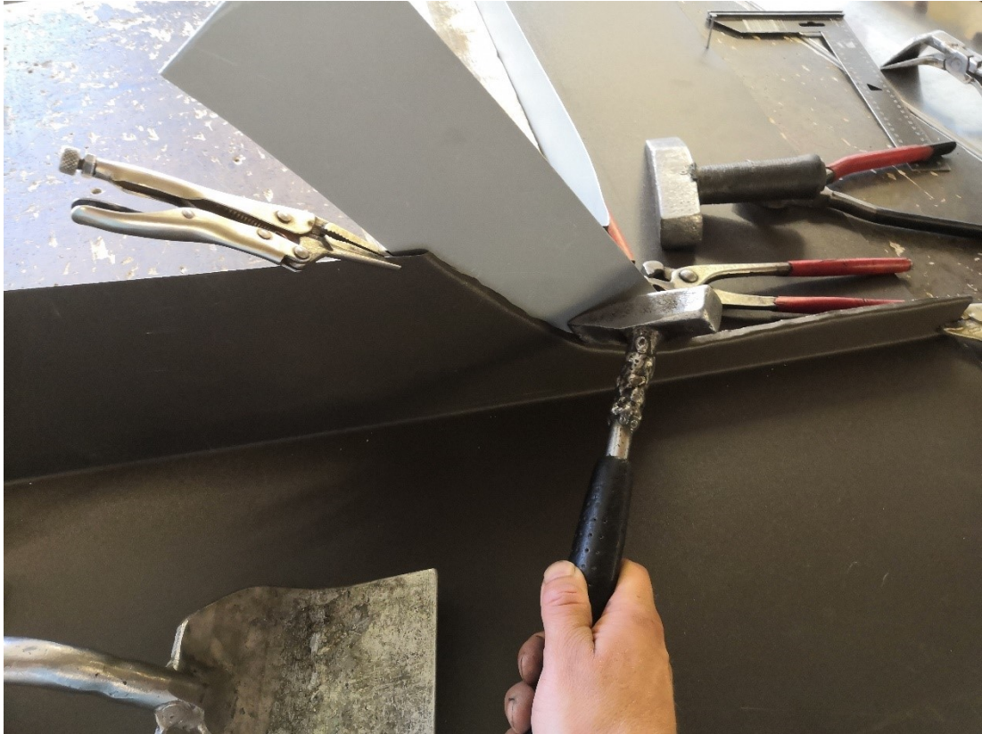
Kuva 161. Kaarisaumaa kiinni vasaroidessa tulee käyttää suojapeltiä sauman välissä. Aluksi leikattu ylimääräinen pellinkappale soveltuu tähän erinomaisesti, koska siinä on valmiiksi kaarisauman muoto. Englataitos taittuu vaivattomasti vasaralla, terävällä päällä saumaa voidaan tarvittaessa venyttää.
