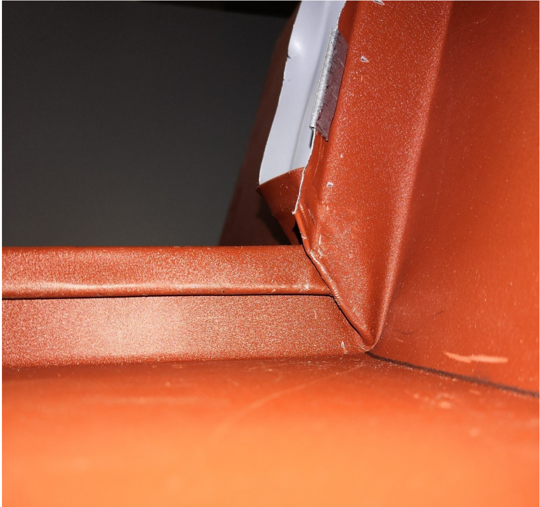
Kuva 178. Laskoksen tulee sijaita taitoksen kulman keskikohdassa, peittäen alaosan sauman.
