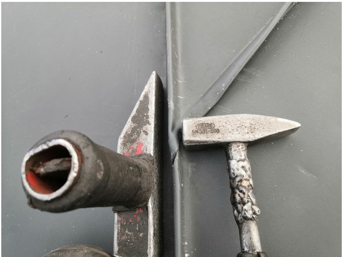
Kuva 275. Saumojen risteyskohdat viimeistellään vasaralla ja kosakalla.
