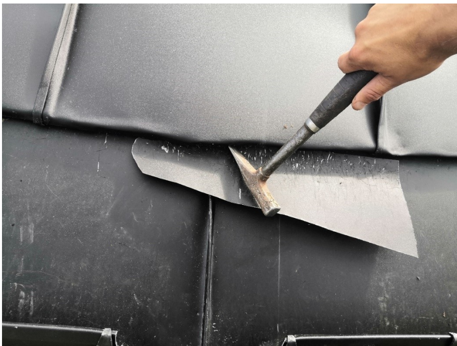
Kuva 101. Sauman vasarointi tuplaan, vaatii voimaa erityisesti pystysaumojen kohdalla. Tässä vaiheessa sauma on vielä hyvin lommoinen.
