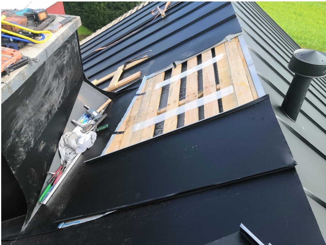
Kuva 16. Peltirivien keskelle asennettava äänieristysnauha näkyvissä laudoituksen päällä.
