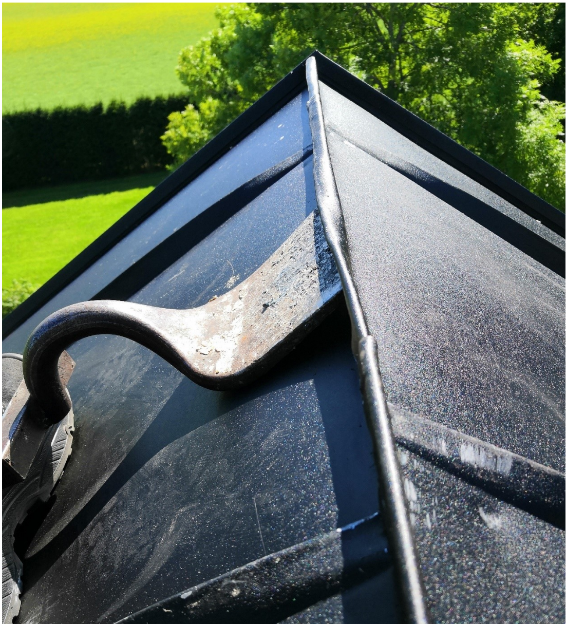
Kuva 237. Tuplataitoksen valmistusta.
