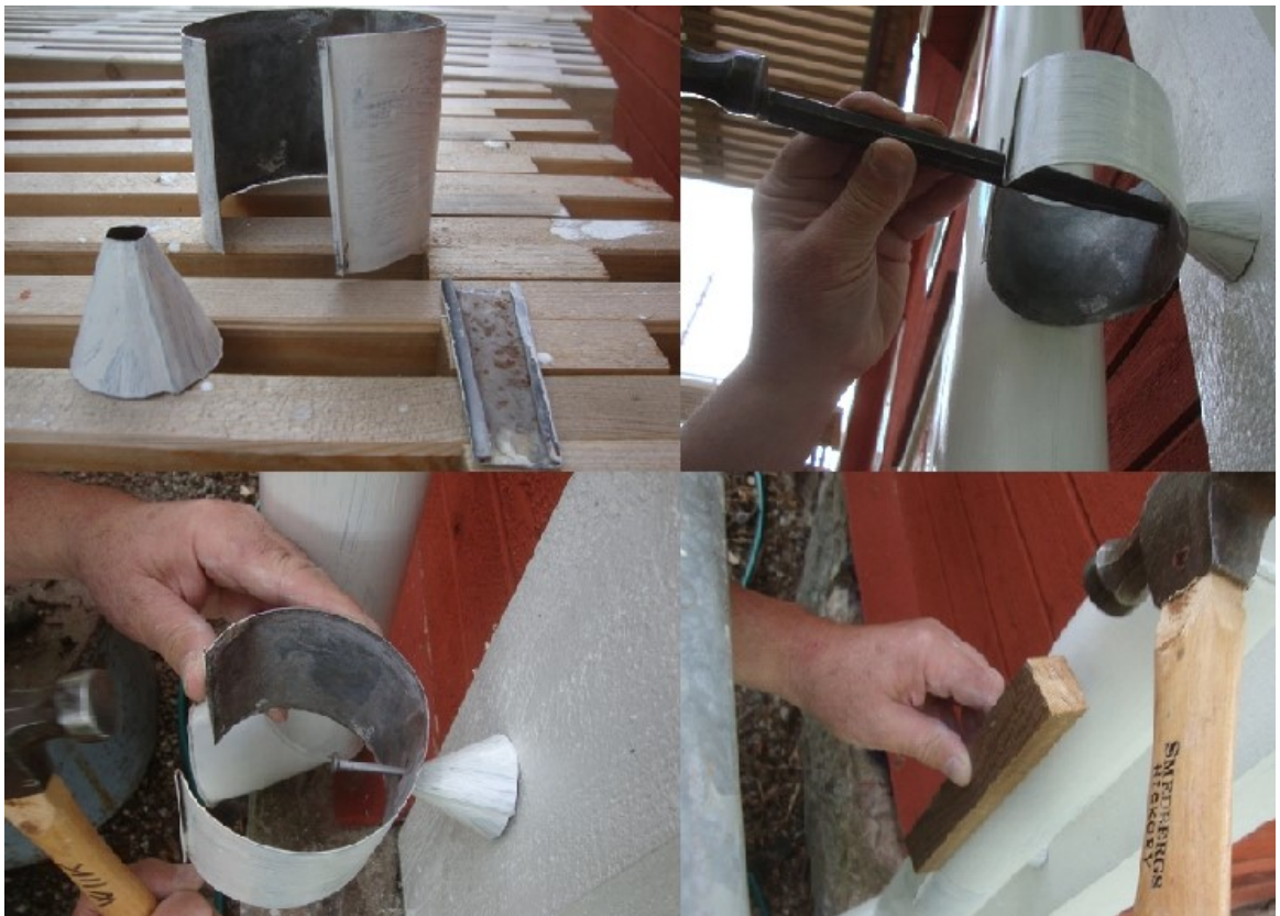
Kuva 221. Peltinen käsin valmistettu syöksytorven kannake.
