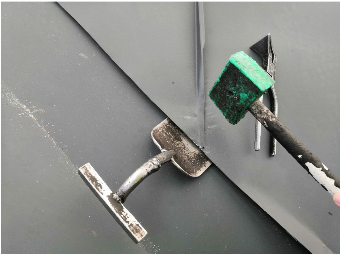
Kuva 22. Pystysauman kaataminen jiirissä. Lapion ohut kärki työnnetään pystysauman kohdalla peltikerrosten alle ja pystysauma kaadetaan nuijalla lapiota vasten.
