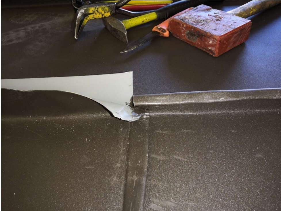
Kuva 184. Saumaus ulotetaan kaadetun osan sisään ja saumataan tuplaan. Kuvan vasemman puolen pellit on käännetty pois edestä saumauksen ajaksi.
