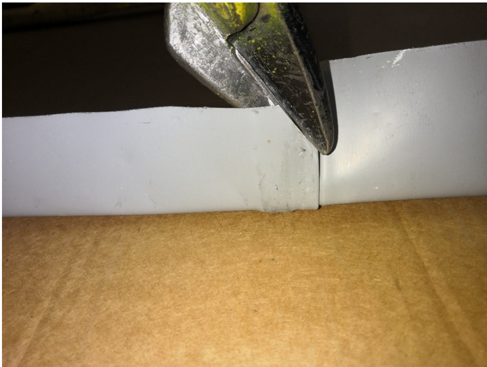
Kuva 183. Edellisen kuvan näkymä taustapuolelta. Lyhyempi pelti leikataan sauman sisällä auki noin 10 mm kuvan osoittamalla tavalla. Sauma taittuu tästä kohden valmiiksi pystysaumaksi, joten valmiin sauman korkeus on yhtä kuin leikkauksen korkeus pystysauman alareunasta.
