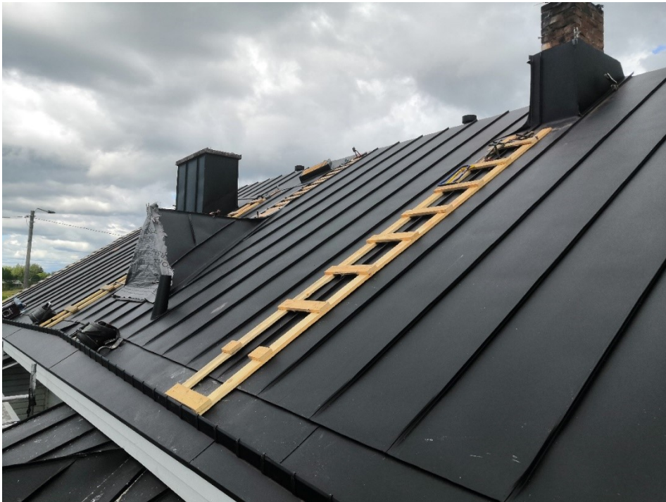
Kuva 103. Valmista jalkarännin takasaumaa. Huomaa kuvassa näkyvät työnaikaiset puiset lapetikkaat, jotka helpottavat katolla kiipeilemistä.
