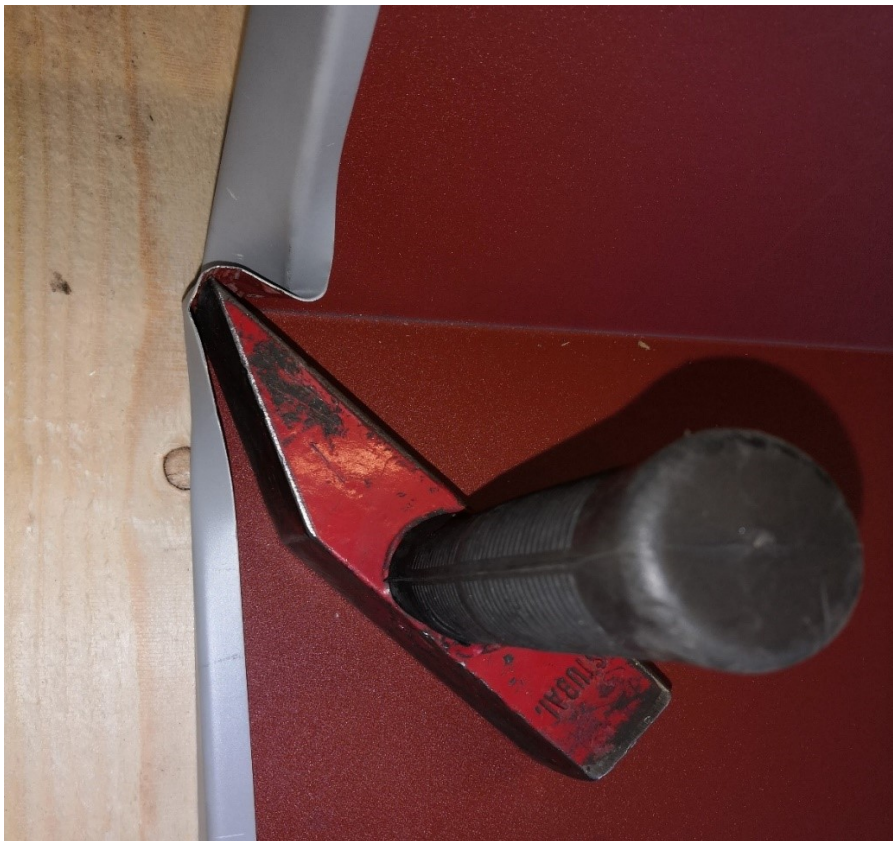
Kuva 174. Laskoksen pohjaa siirretään syvemmälle kosakan avulla.
