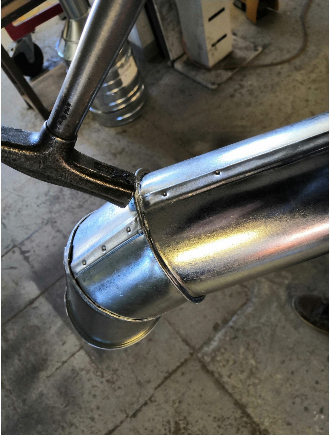
Kuva 210. Mutkasarjojen sauman kiinni lyöminen. Huomaa kuvassa putkien takana olevan sauman paikka. Päällekkäin olevia putken saumoja tulee välttää.
