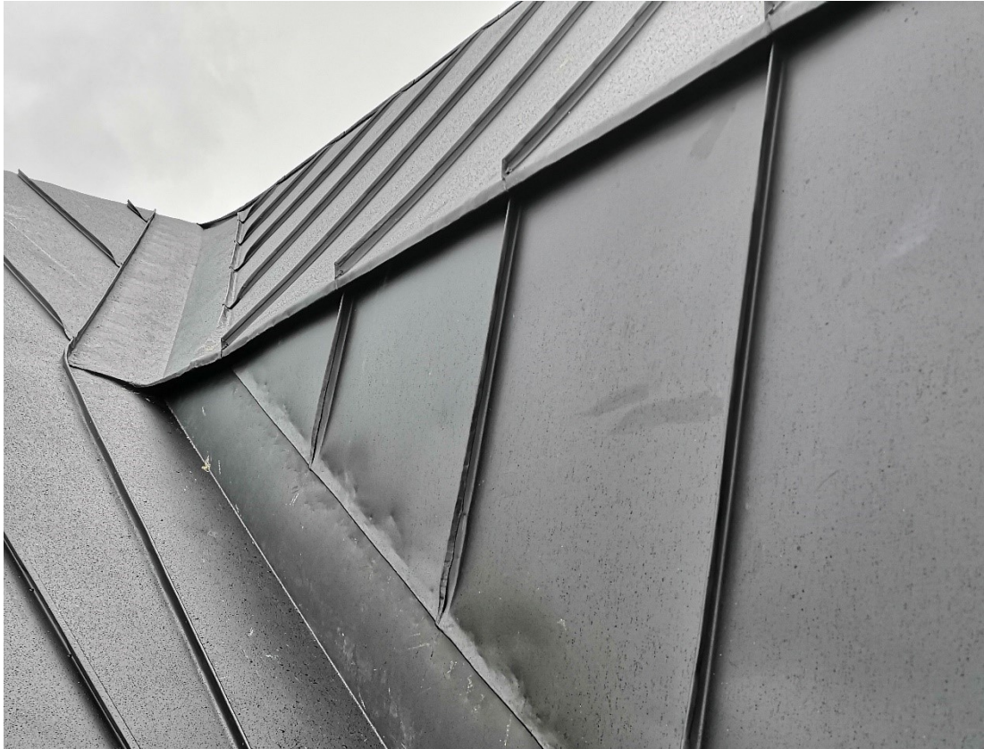
Kuva 321. Mansardipoikkiharjan jiiripellitys.
