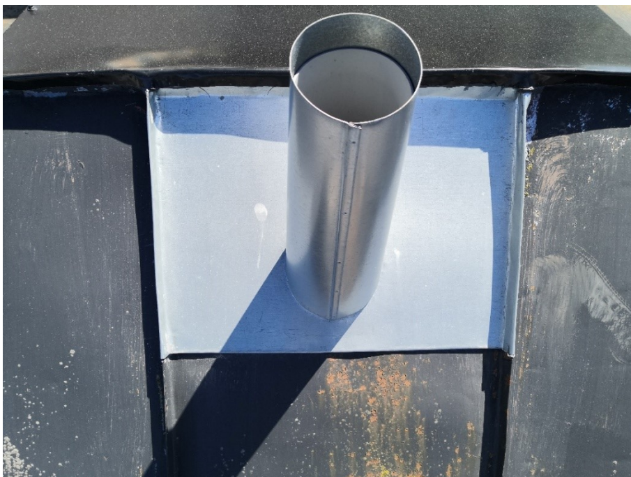
Kuva 70. Palanvaihtona tehty läpiviennin uusiminen.
