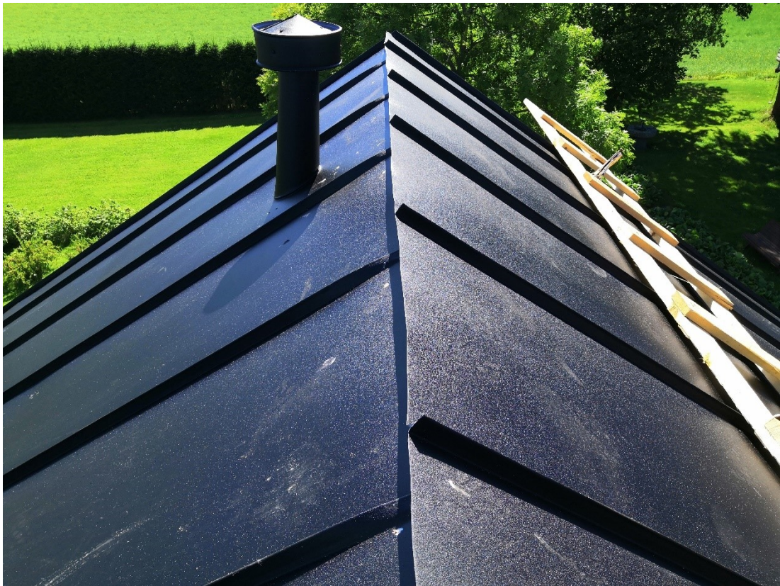
Kuva 234. Kattorivit asennettuna.
