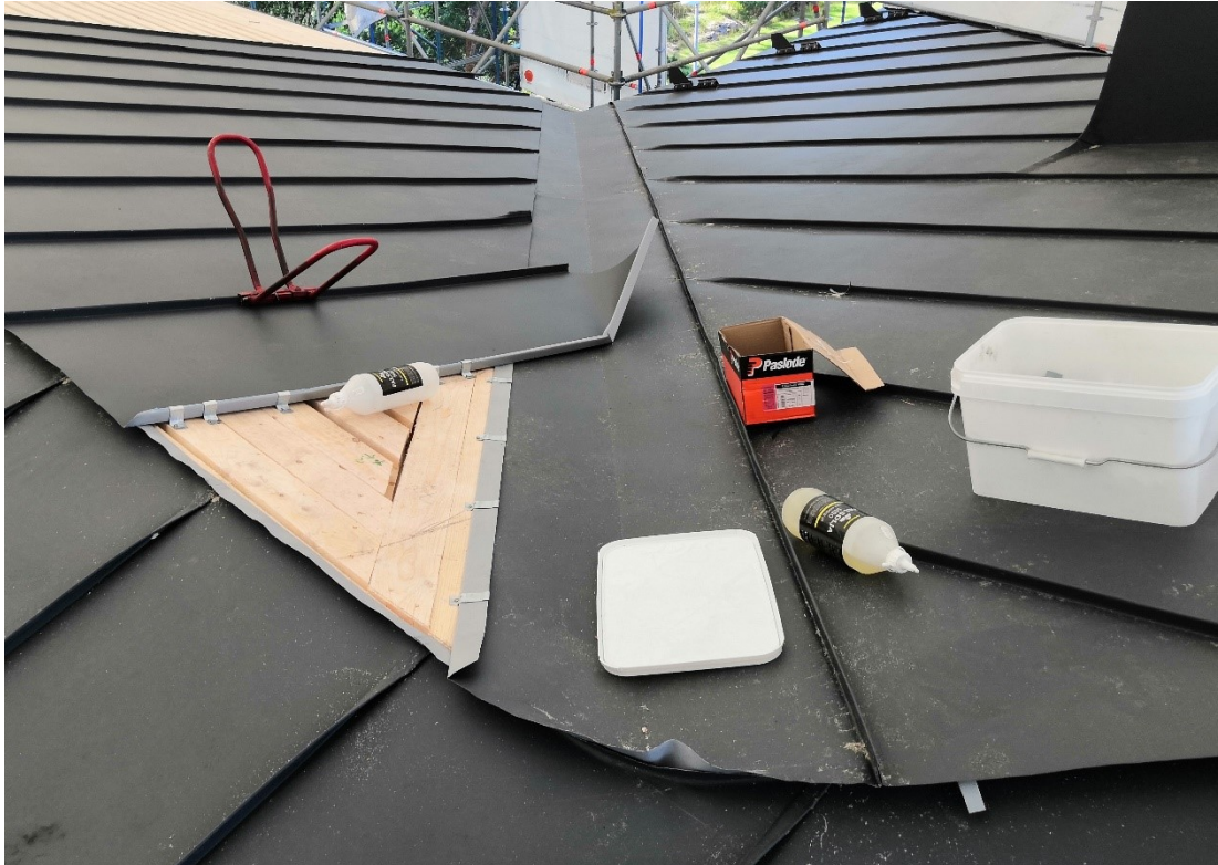
Kuva 266. Jiiripelti paikoillaan ja rivit asennetaan jiiripellin päälle.
