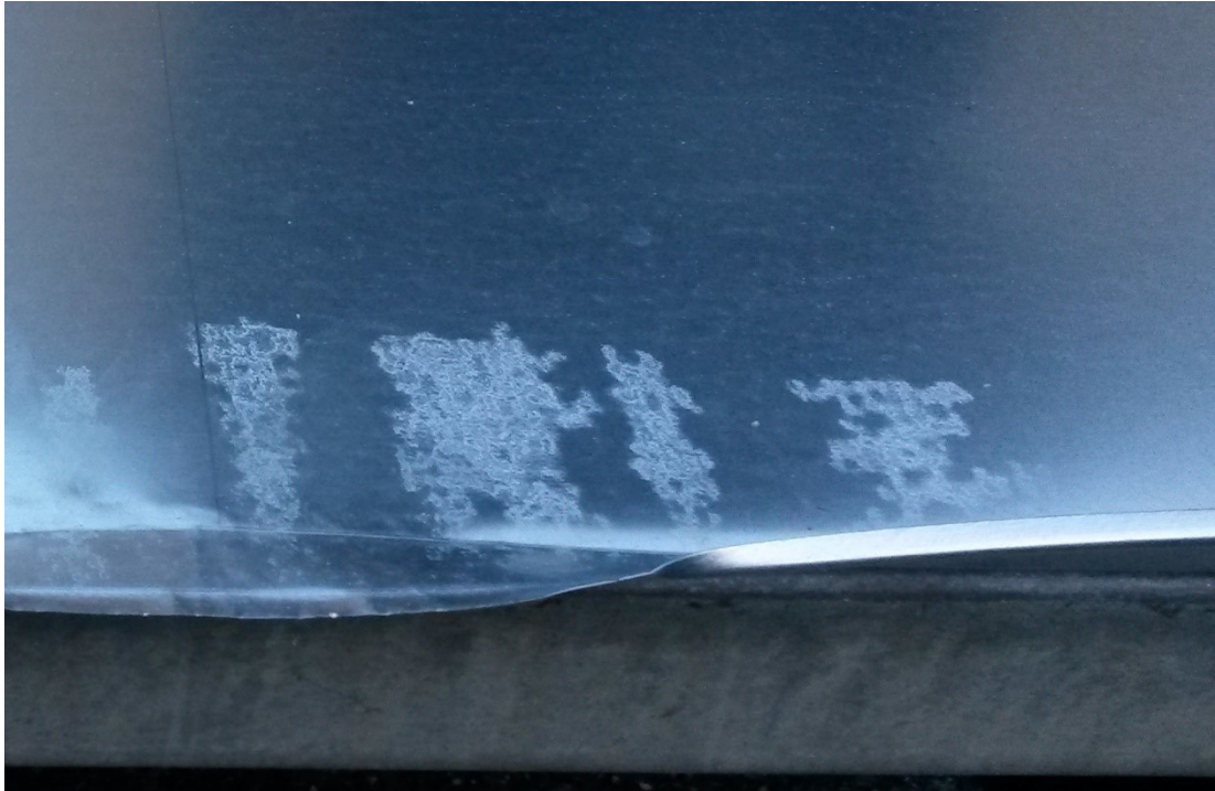
Kuva 114. Valkoruostetta peltirivin pinnalla.
