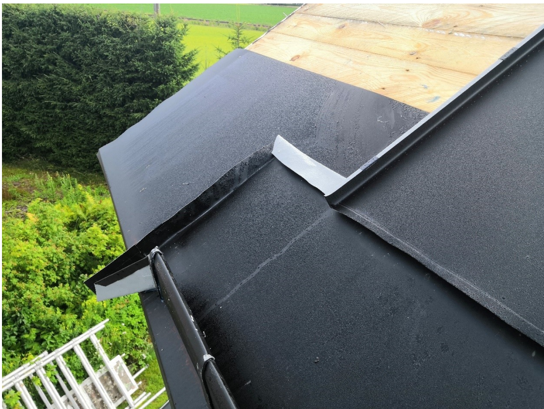
Kuva 245. Räystäspelti ulotetaan jalkarännin takasauman yläpuolelle.
