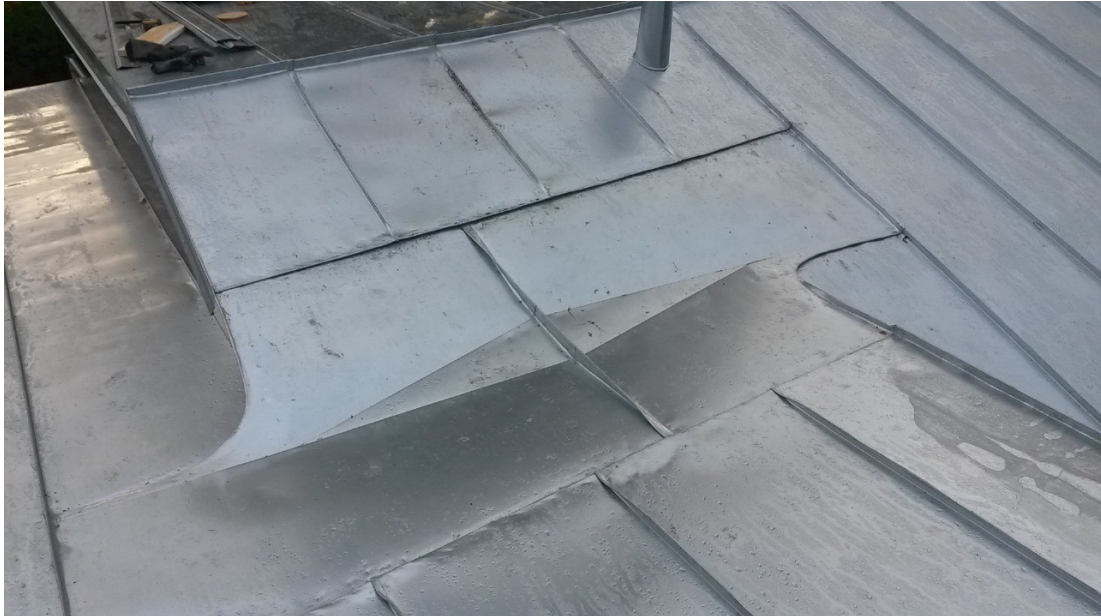
Kuva 316. Vastakkain toistensa lomassa olevat päätyräystäät.
