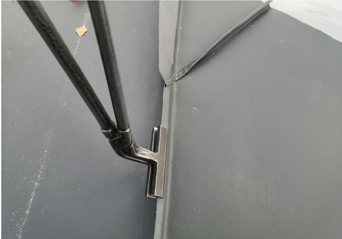
Kuva 271. Ensimmäinen taitos käännetään ja leikataan.
