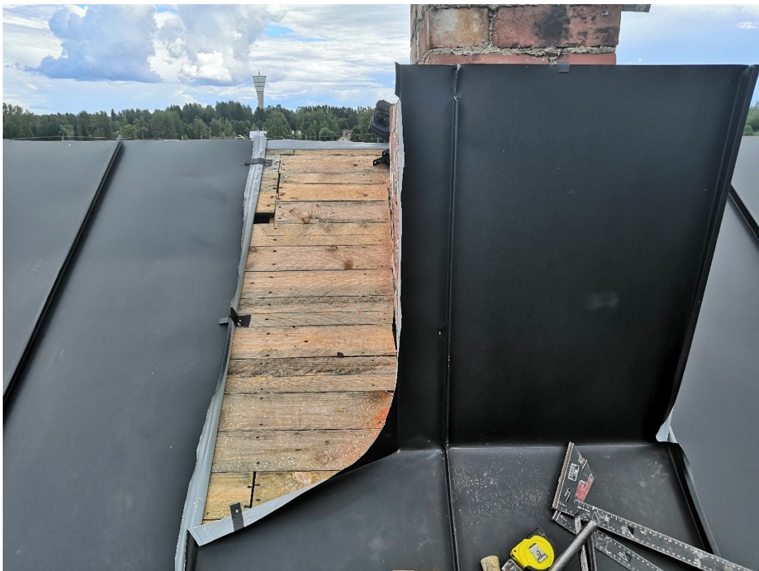
Kuva 89. Klemmarit asennettuna. Piipun viereisen peltirivin pystysauma kaadetaan sivupalan saumamista varten.
