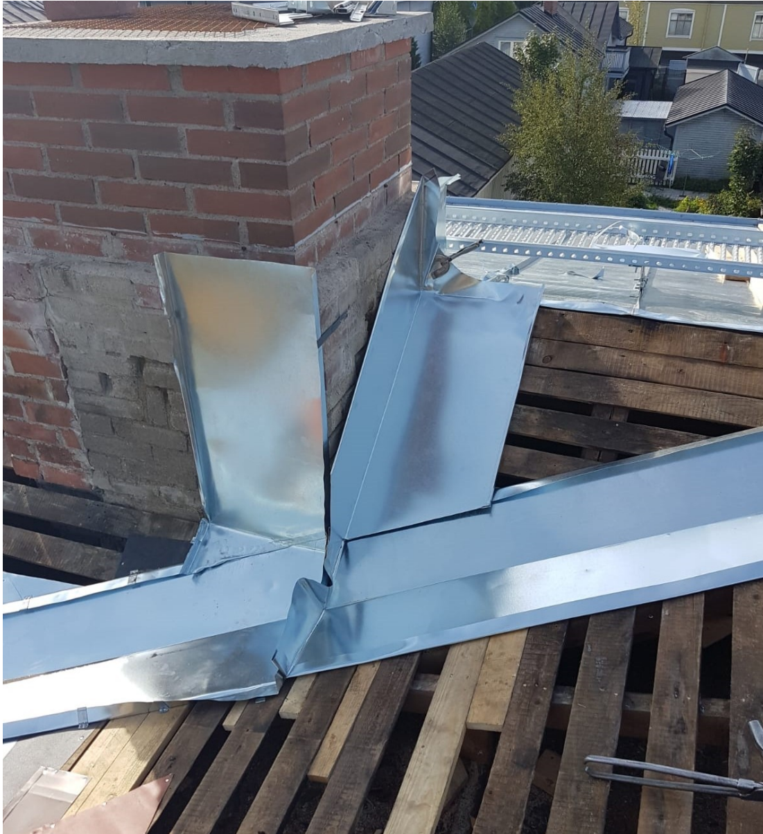
Kuva 318. Piipun kulma ulottuu jiiripellin alueelle. Piipun ensimmäinen pala on saumattu jiiripeltiin ennen jiiripellin asennusta. Kuva Jerry Nordman 2018.
