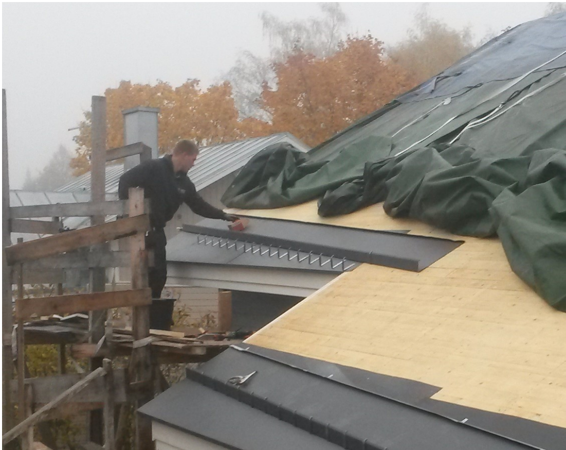
Kuva 246. Jalkarännin koukut asennettuna.
