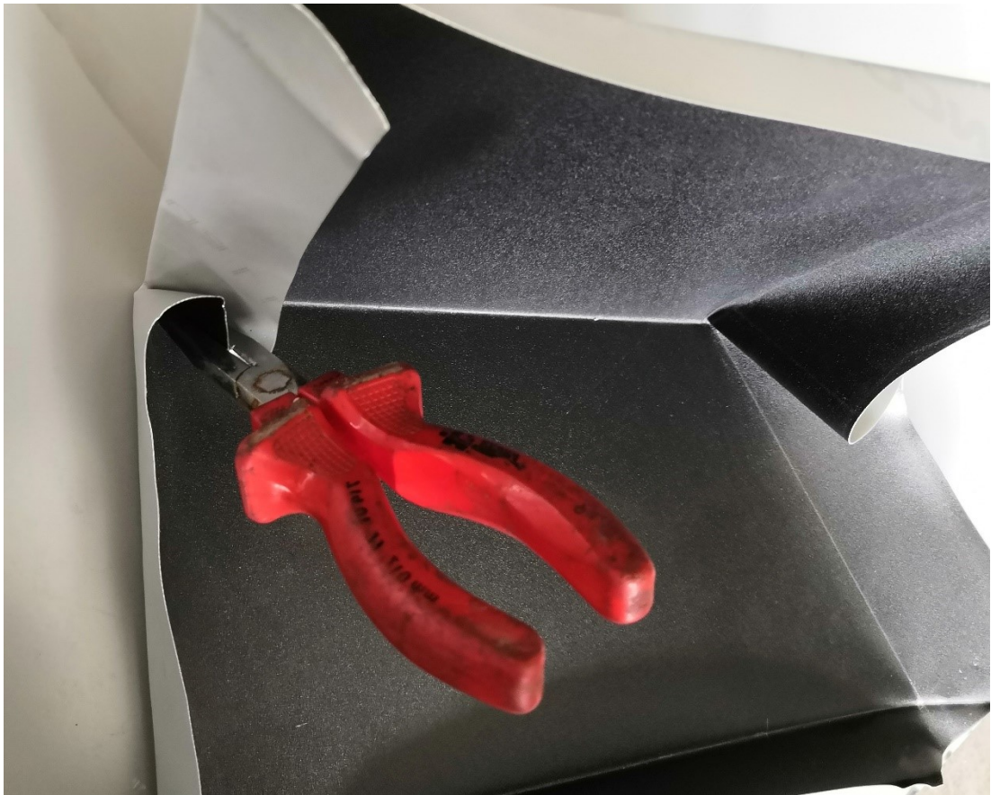
Kuva 32. Kärkipihdit käytössä kaarisauaman laskoksen eli ropposen valmistamisen yhteydessä.
