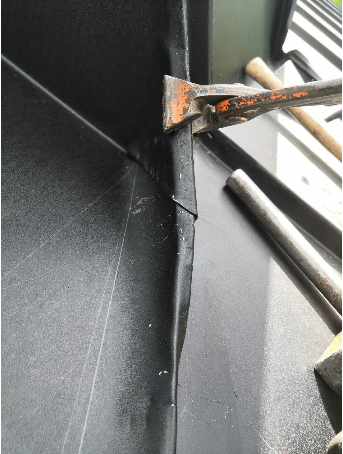
Kuva 94. Tuplaan saamaaminen. Pelti taittuu parhaiten siihen tehtävän jäljen kohdalta.
