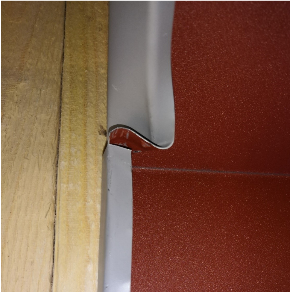
Kuva 175. Pieni sauma leikataan mahdollisimman syvältä ensimmäiseen kanttiin saakka.
