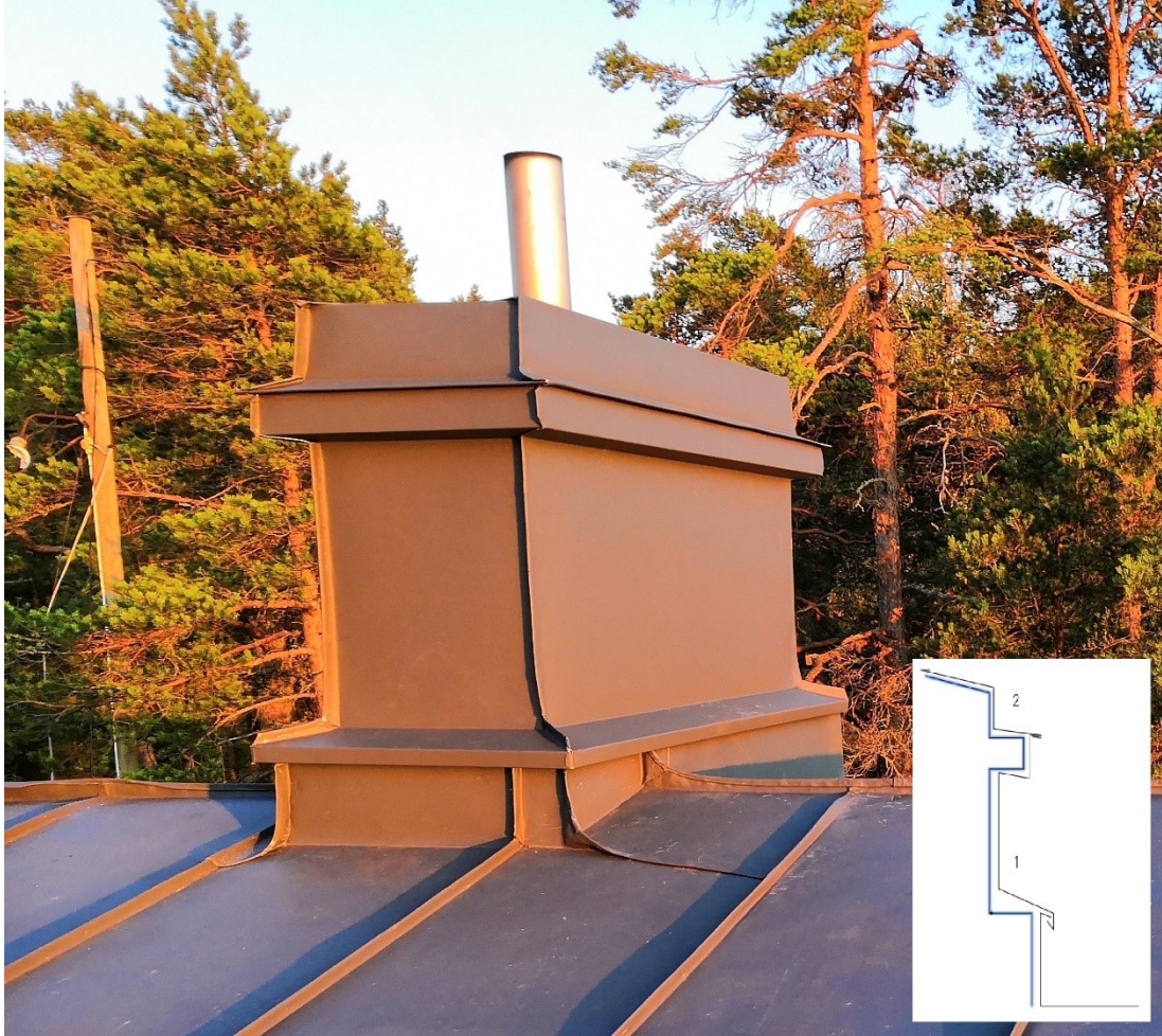
Kuva 293. Tässä piipussa sivujen pellitys on toteutettu pykälästä ylöspäin kahdella palalla. Pikkukuvassa pellityksen muoto, hormi merkittynä sinisellä värillä.
