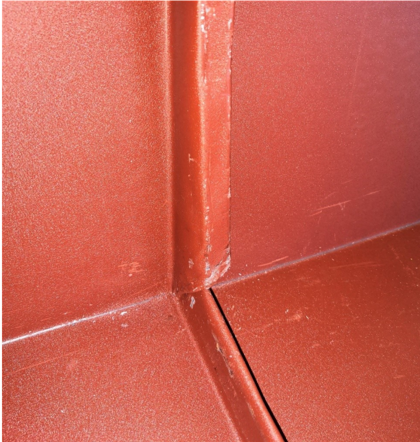
Kuva 179. Työn aikana pinnoitettujen peltien pinnoitteeseen tulee naarmuja, jotka tulee paikkamaalata.
