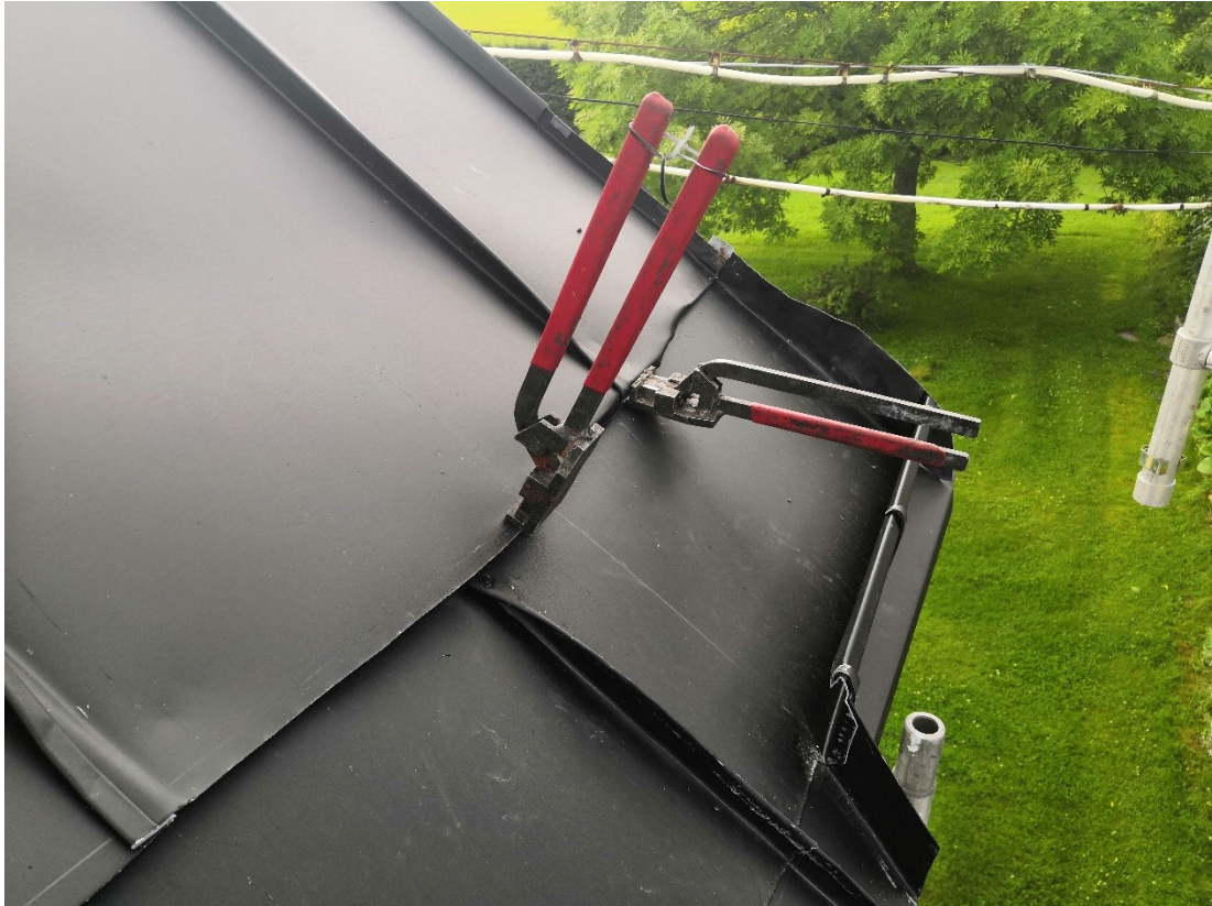
Kuva 98. Vaakasauman teossa tarvitsee erityisesti tuplasaumapihtejä.
