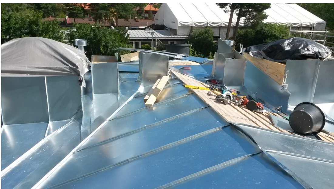
Kuva 317. Jiirissä olevien läpivientien pellitys.
