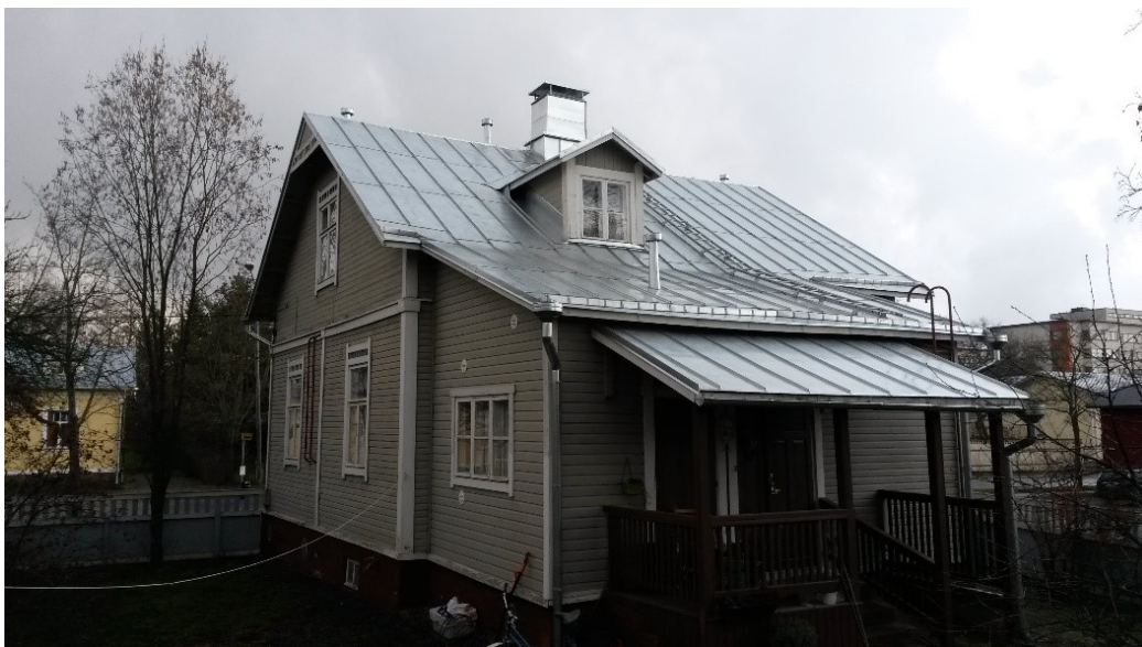
Kuva 137. Valmis katto muistuttaa ulkonäöltään vanhaa englasaumakattoa, jonka rivit on tehty palasista.
