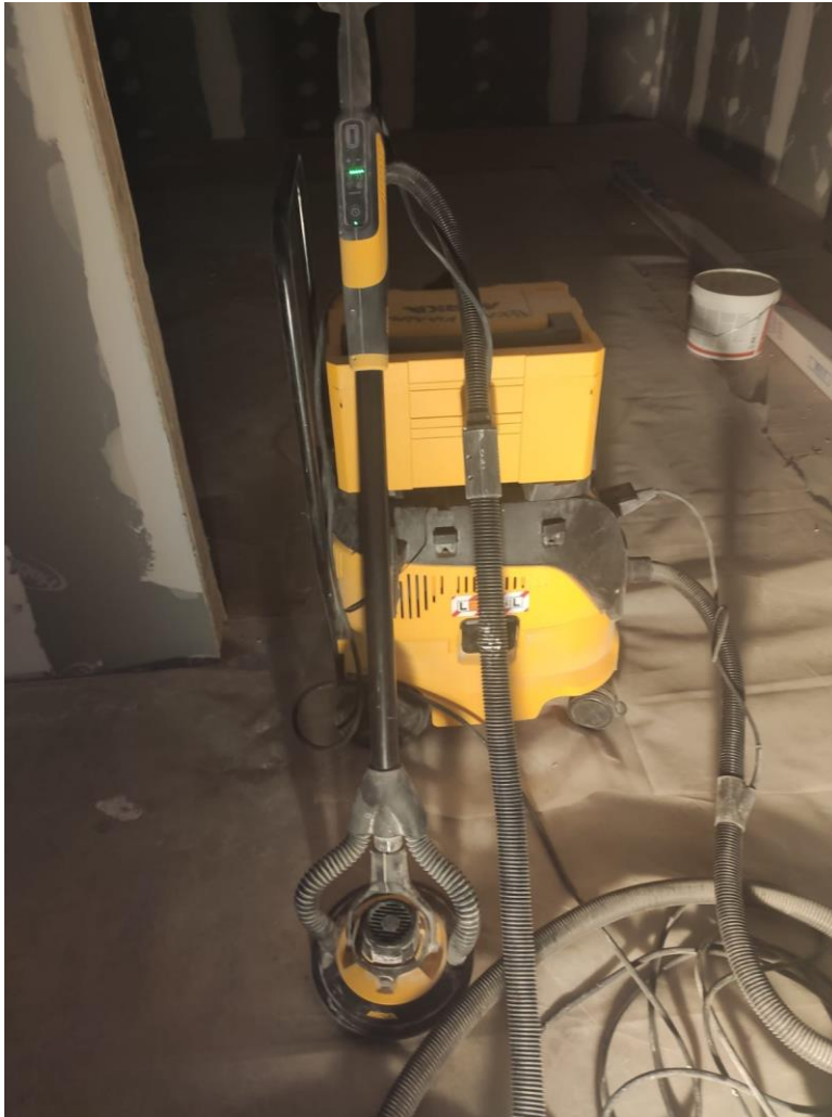
Kuva 12. Työmaalla tarvittava kokonaisuus.
