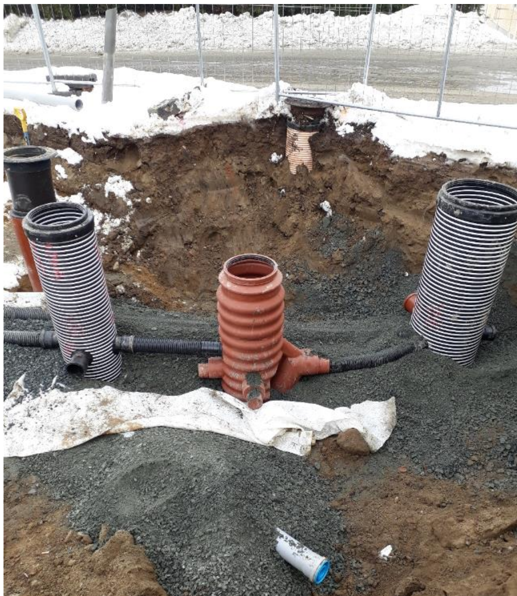
KUVA 6. Esimerkki liitetiedoston kuvasta, (Jv-, salaoja-, pvk-kaivot, svtk14 vesijuoksu 115,30. Etualalla työmaakopin viemäri) (Koneurakointi Laitinen & Väänänen Oy, Kiho 2019)
