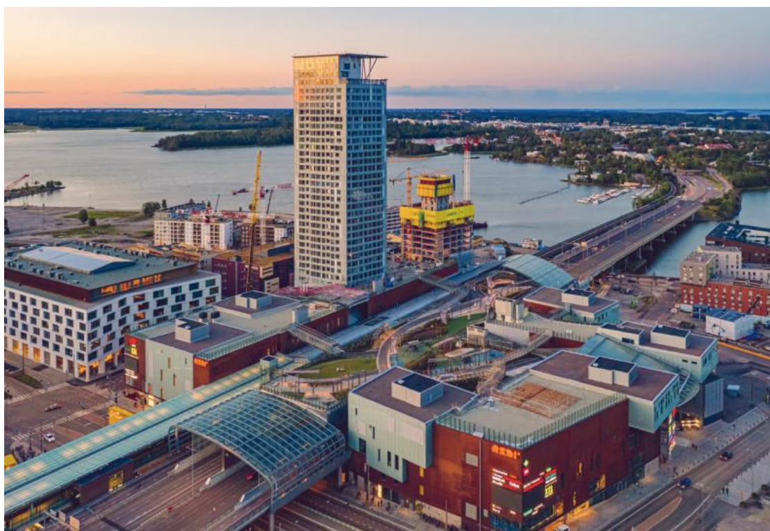
KUVA 1. Tornitalot rakenteilla Helsingin Kalasatamassa (Valjus, 2019, 71)
