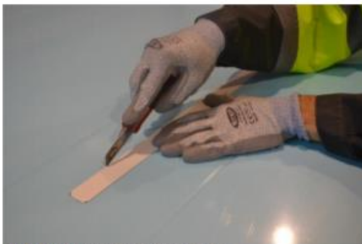
Kuva 1. Viillojen tekeminen suojakalvoon.
