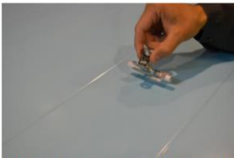
Kuva 2. Suojakalvon kiinnittäminen putken ympärille ja klipsi putkeen.
