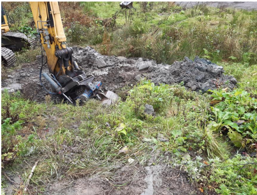
Kuva 8. Koekuopan kaivaminen kaivinkoneella [12.]
