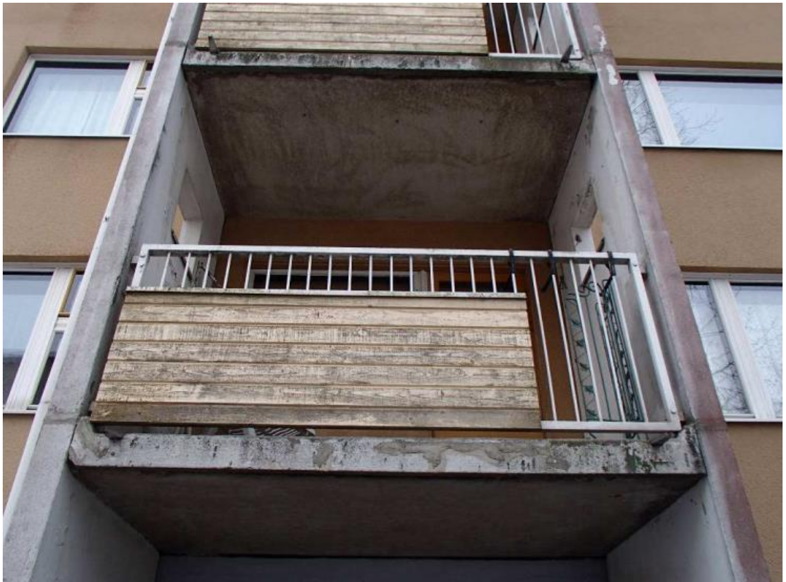
KUVA 7. Yleiskuva parvekerakenteen nykyisestä kunnosta. (Raksystems, Kuntotutkimusraportti Koivikkotie 5).
