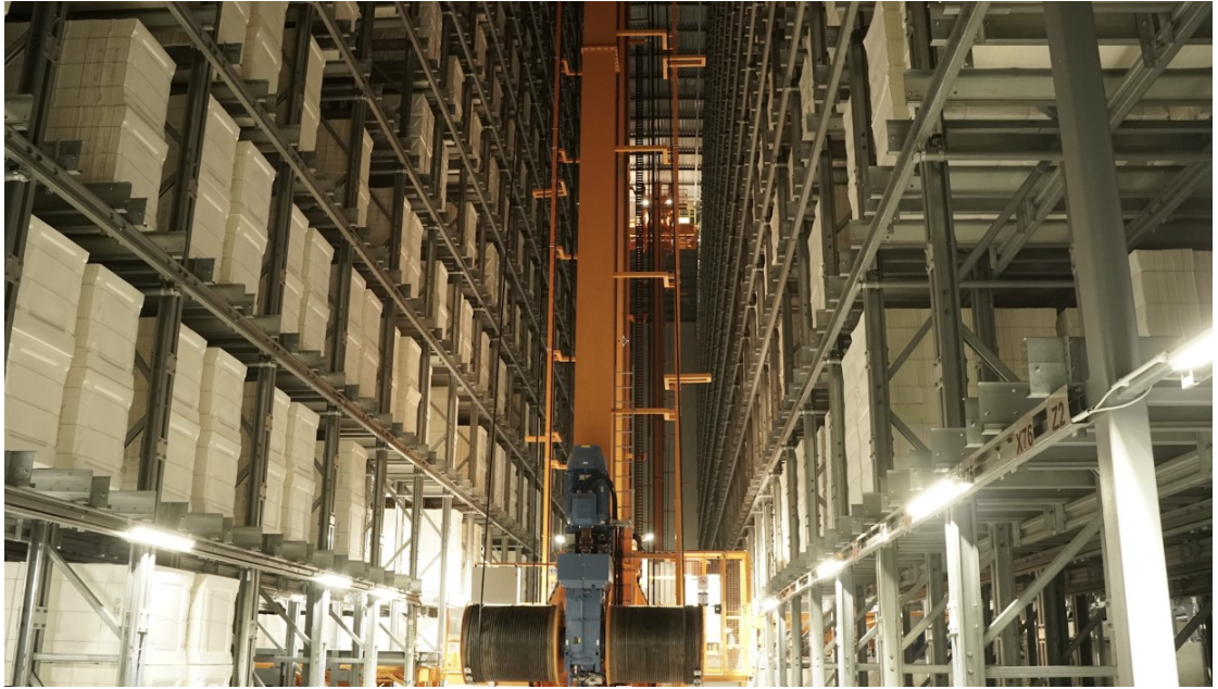
Kuvio 12. Autoimatisoidun sellunjakelukeskuksen hyllyköitä ja hyllystöhissi. (Biotuotehtaan yleisesitys 2020)
