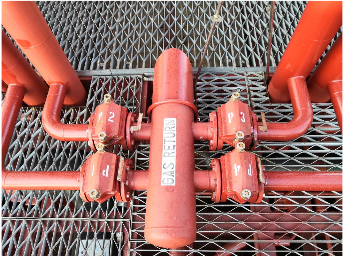
Kuva 5. Lastitankkien kaasunpaluulinjat yhdistyvät niskalle vievään kaasunpaluulinjaan.
