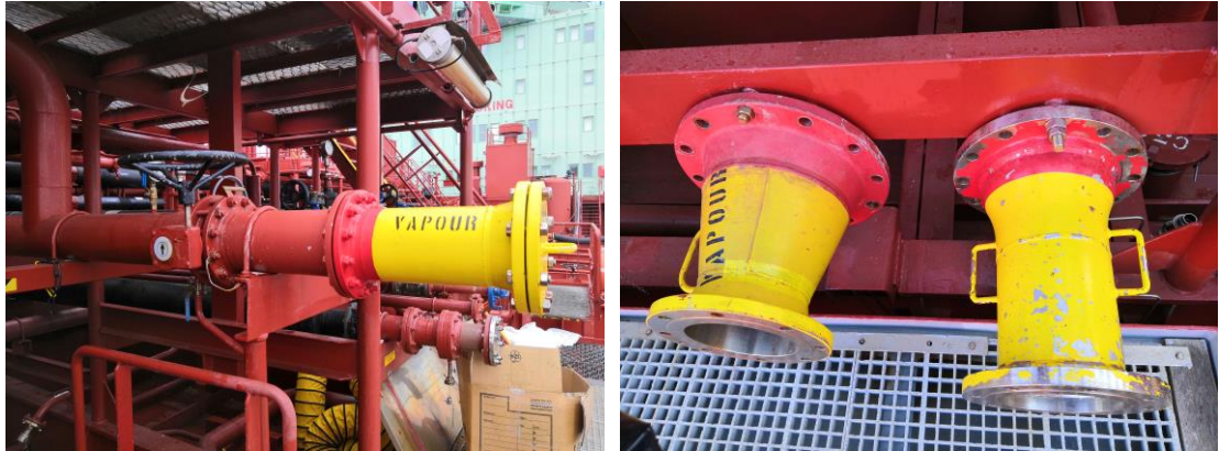
Kuvat 3 ja 4. Kaasunpaluuniska ja siihen sopivat supistajat.
