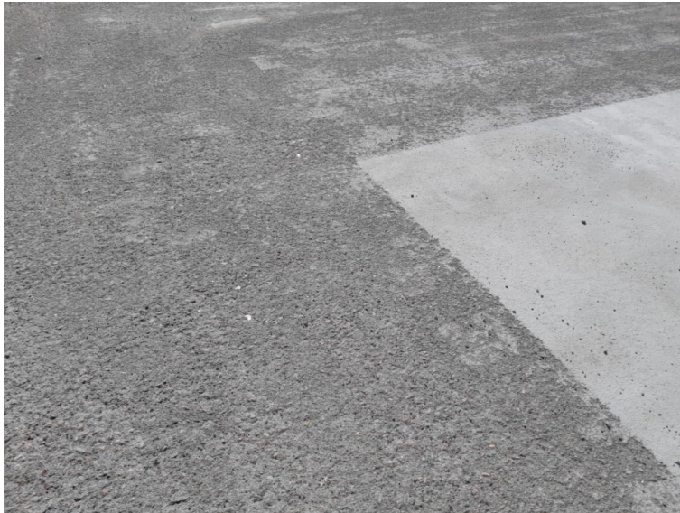
Kuva 1. Sinkopuhallettu betonipinta & käsittelemätön pinta
