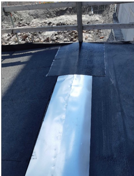
Kuva 7. Peltinen irrotuskaista.
