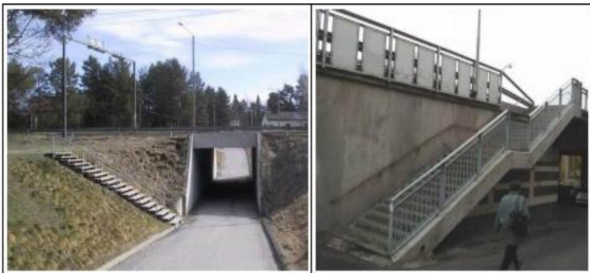
Kuva 21. Portaat hyvässä kunnossa, joten molemmat kuvat ovat merkintä A (Maantiesiltojen vuositarkastusohje 2019).
