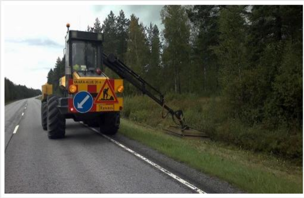
Kuva 14. Raivauksessa käytetään pyöräkuormaaja (Etelä-Pohjanmaan ELY 2018).
