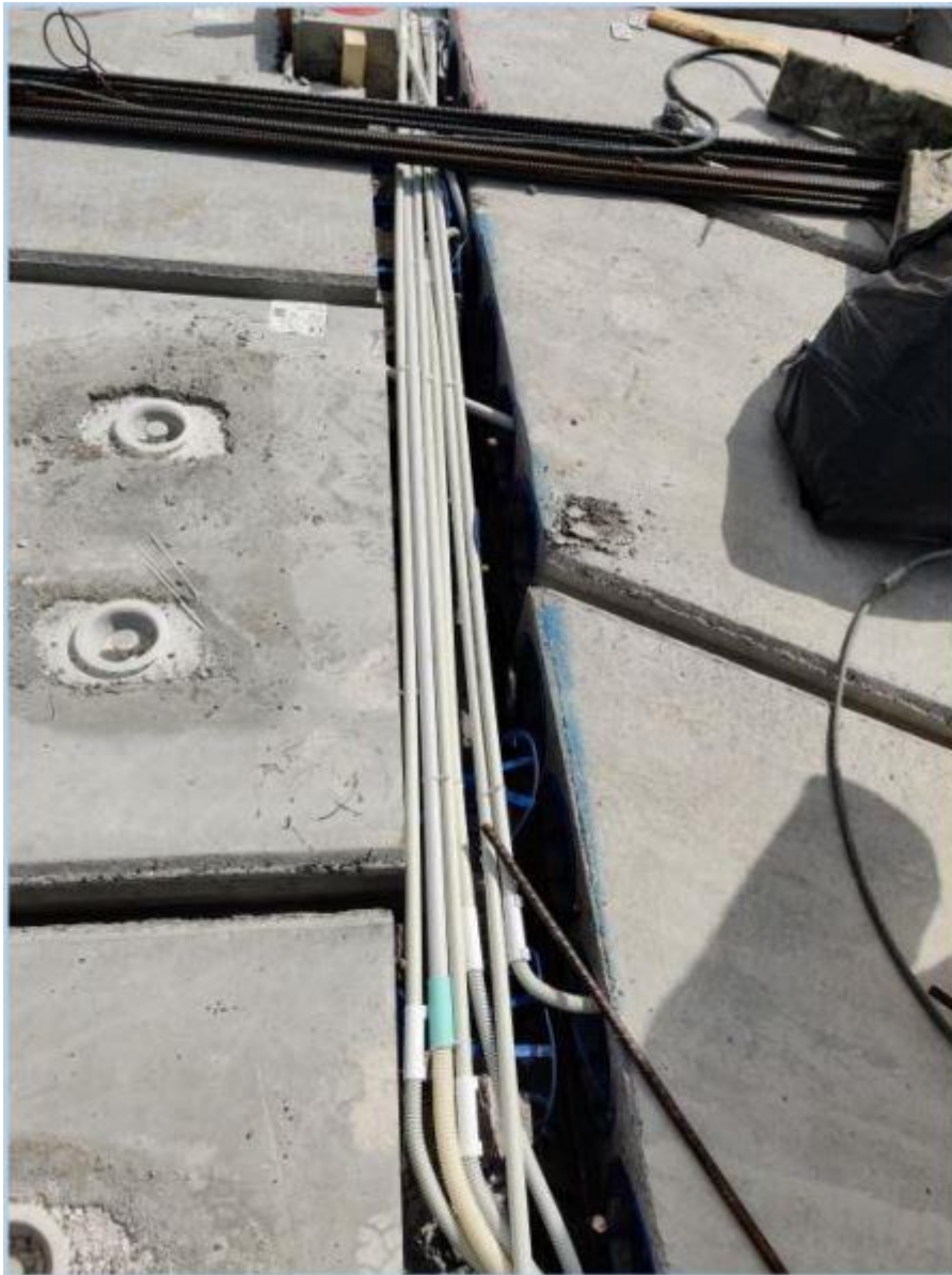
Kuva 5. Sähköputkia SUR-urassa
