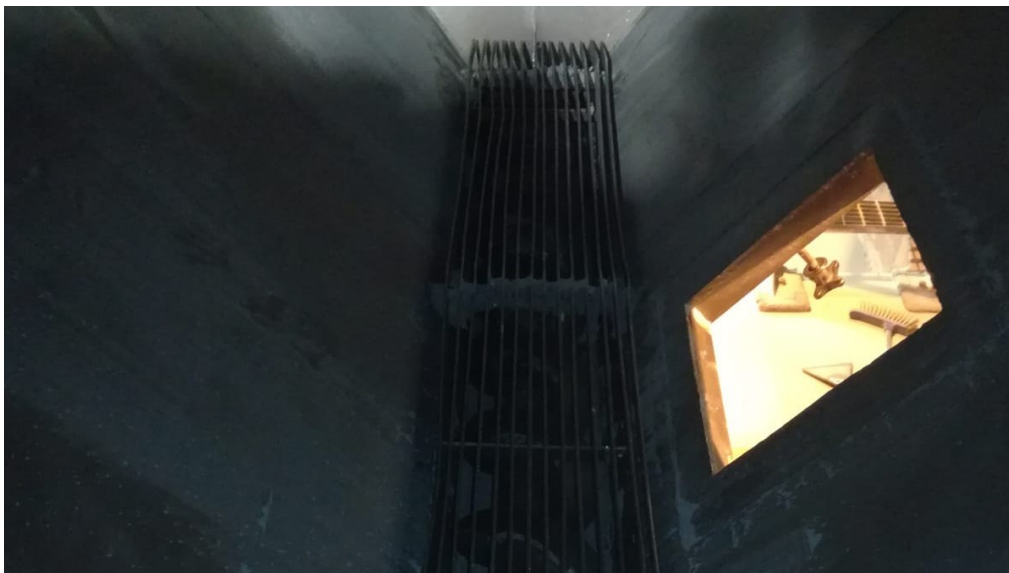
KUVA 10. Rakeistuskammion alaruuvi (Kangas 2020)
