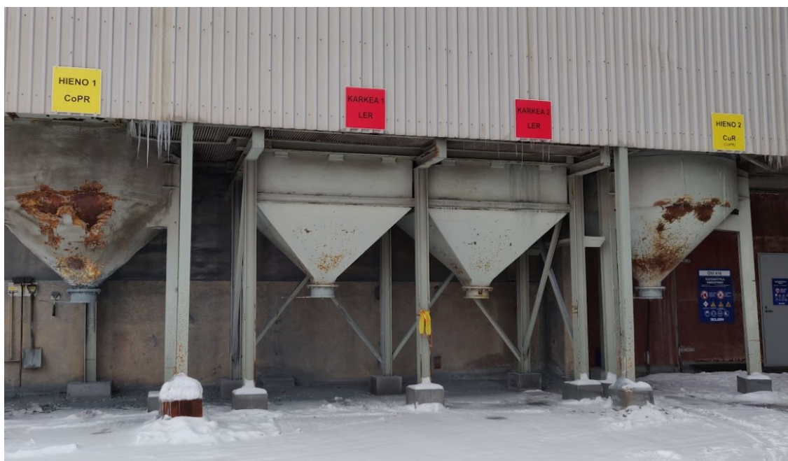
KUVA 8. Sinkkipulverin varastosiilot
