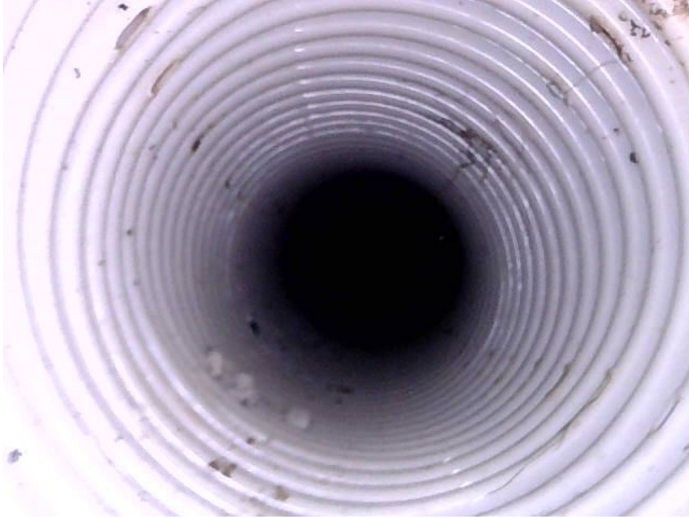
Kuva 10. Endoskoopilla otettu kuva rakennuksen salaojituksesta
