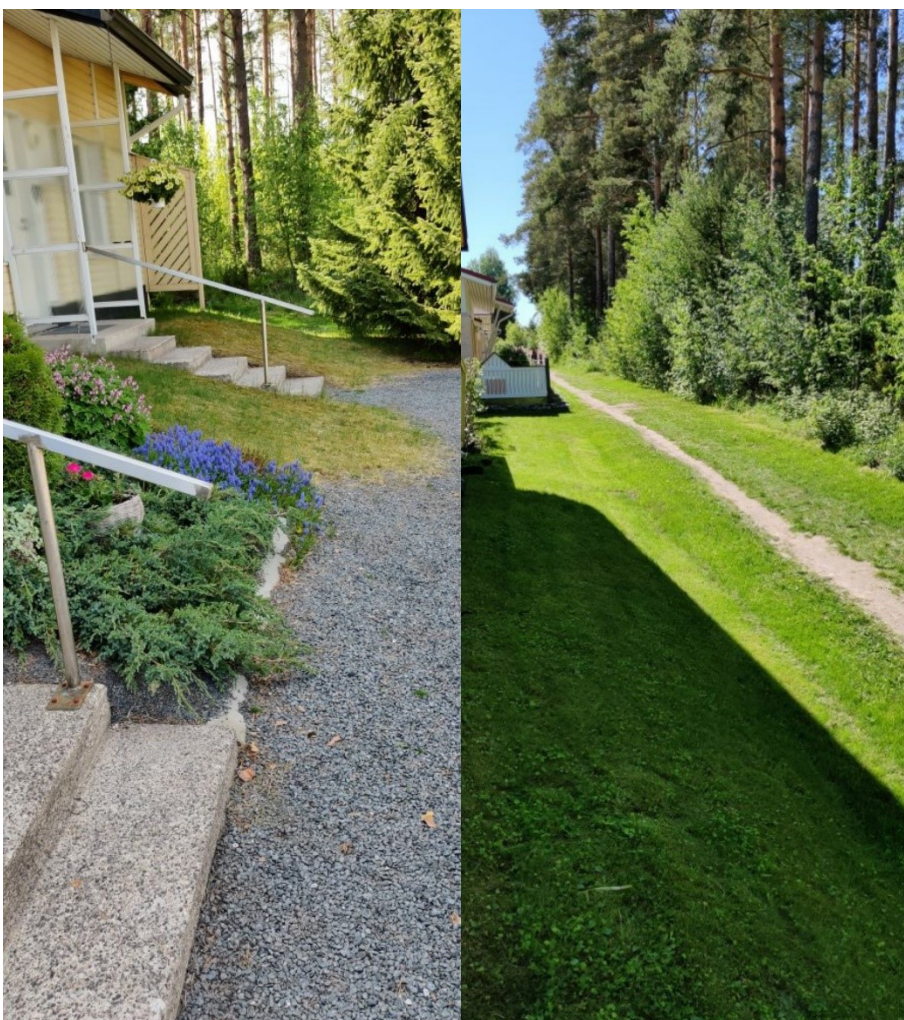
Kuva 5. Etupiha asuinrakennuksen pohjoispuolella, jossa kaadot ovat kunnossa 3 m:n etäisyydeltä talosta.
