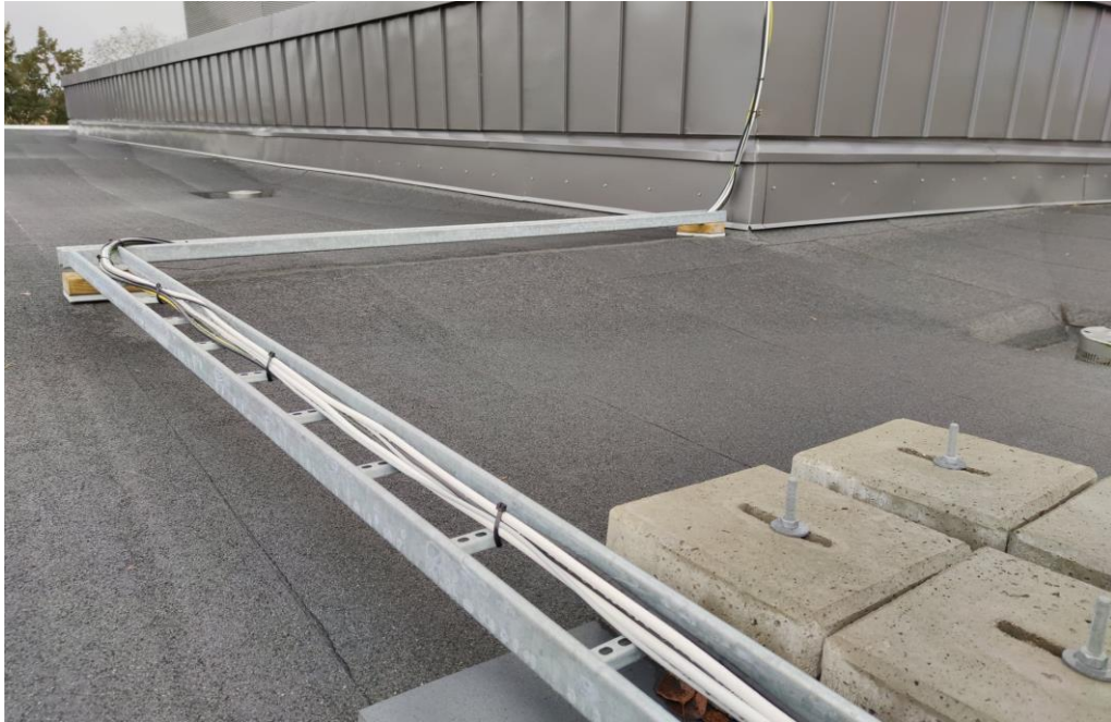
Kuva 26. Kaapeleiden kuljetus IV-konehuoneeseen kaapelikouruja pitkin.
