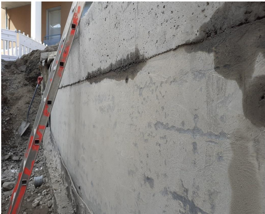
KUVA 26. Autohallin maanpaineseinä ja holvin reuna hiottuna (Pulkinen 2020, CC BY-ND)
