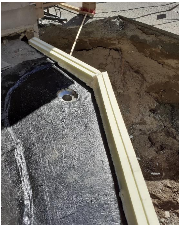
Kuva 20. Ruiskukumi HB S-200 vedeneriste valmiina ja lämmöneristeet asennettuina (Pulkkinen 2020, CC BY-ND)
