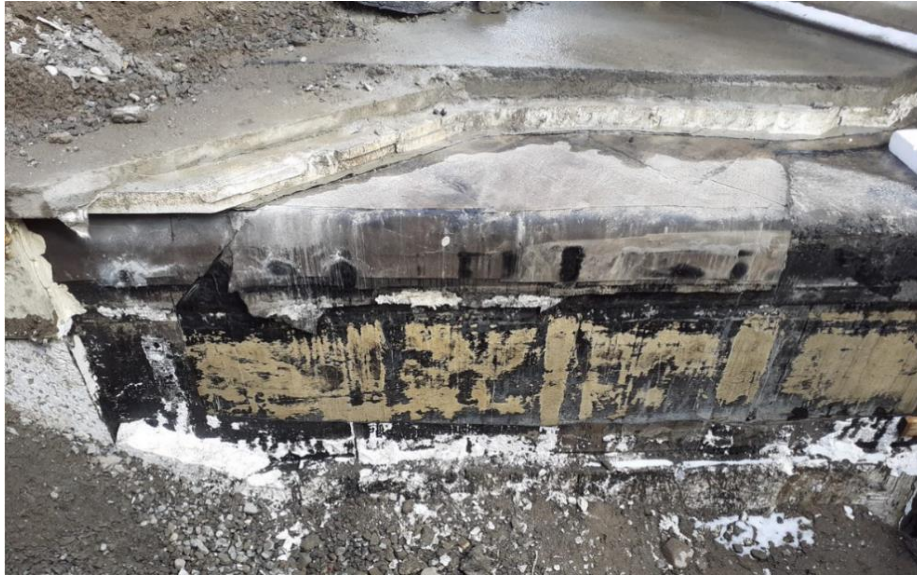
KUVA 25. Puhdistamaton maanpaineseinä ja holvinreuna (Pulkinen 2020, CC BY-ND)
