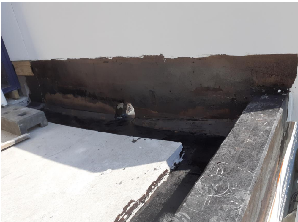
KUVA 10. Bitumikermin vedeneristyksen pohjatöitä (Pulkkinen 2020, CC BY-ND)
