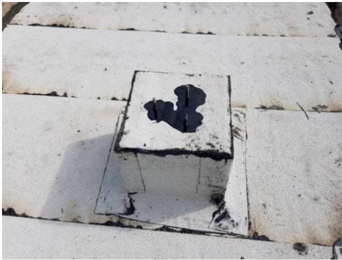
KUVA 22. Korjattu vedeneriste asennettuna lipputangon anturalle, pihakannen kantavassa rakenteessa. Pulttien kannat on tiivistetty sulalla kumibitumilla ja hitsattu kauttaaltaan lipputangon anturan profiilin mukaisesti. (Pulkinen 2020, CC BY-ND.)
