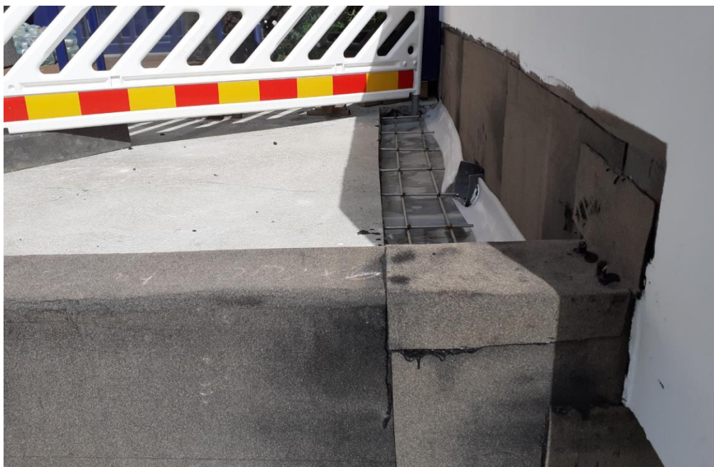
KUVA 12. Pihakannen reunan uudelleen vedeneristys bitumikermiä käyttäen (Pulkinen 2020, CC BY-ND)
