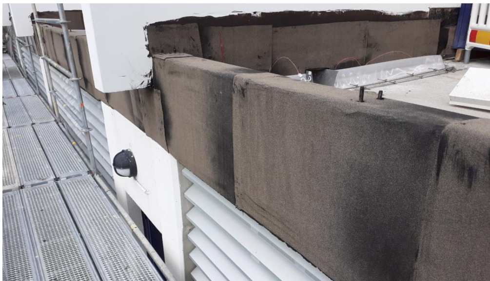
KUVA 13. Pihakannen reunan uudelleen vedeneristys bitumikermiä käyttäen (Pulkinen 2020, CC BY-ND)
