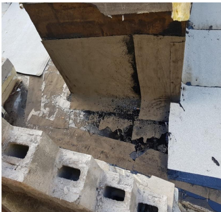
KUVA 5. Aluskermi liimattuna ja pintakermi hitsattuna (Pulkkinen 2020, CC BY-ND)
