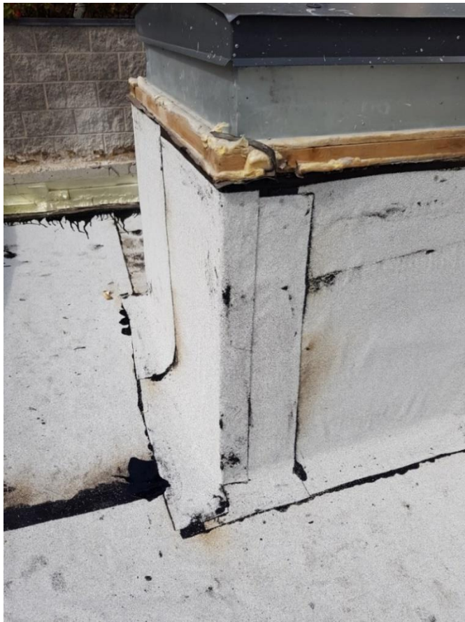
KUVA 23. Korjattu ylösnosto savunpoistoluukussa (Pulkinen 2020, CC BY-ND)
