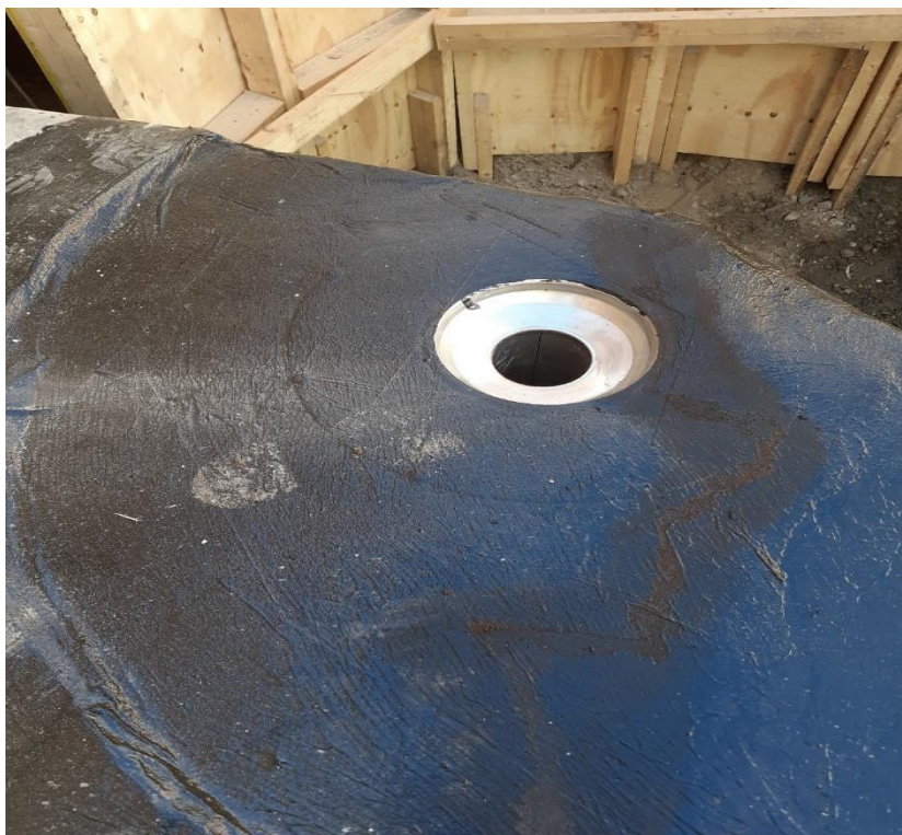
KUVA 17. Veden vaurioittama kuivumaton Ruiskukumi HB S-200 eriste. Ensimmäinen vedeneristyskerros. (Pulkkinen 2020, CC BY-ND)
