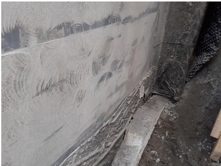
KUVA 27. Autohallin maanpaineseinä hiottuna (Pulkkinen 2020, CC BY-ND)
