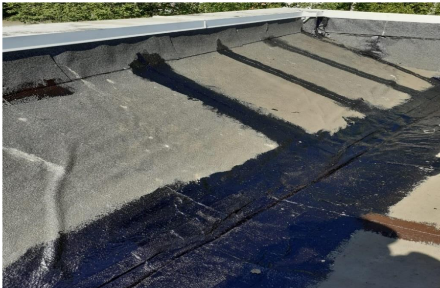
KUVA 2. Bitumikermin vuotavat saumat korjattuina ruiskukumilla, geotekstiiliä käyttäen (Pulkinen 2020, CC BY-ND)
