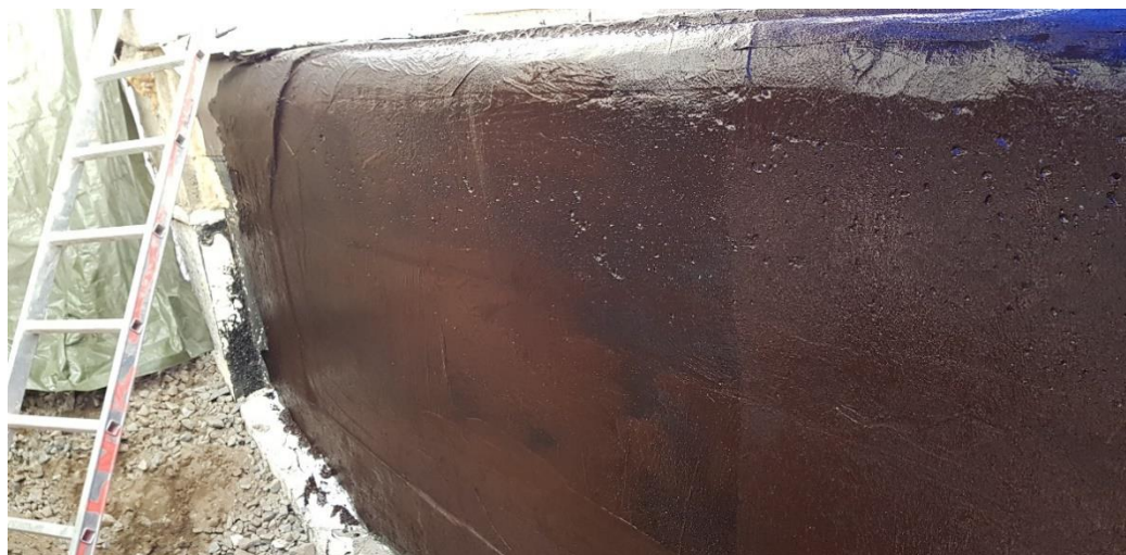
KUVA 18. Ensimmäinen Ruiskukumi HB S-200 pinta valmiina (Pulkkinen 2020, CC BY-ND)
