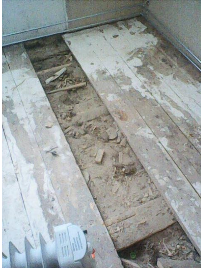
Kuva 13. Vanha lattiarakenne, muovimatto poistettuna.
