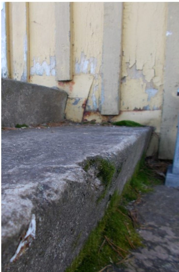
Kuva 4. Seinään kiinni valetut betoniportaat
