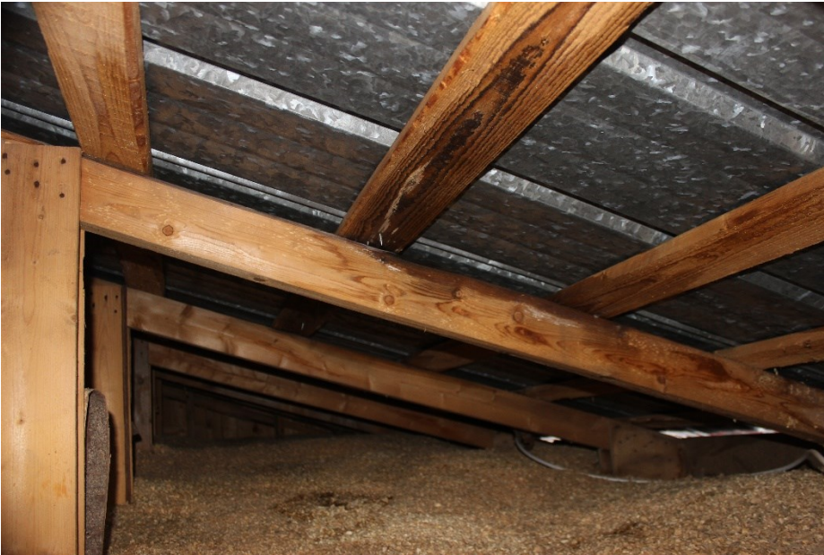
Kuva 7. Kosteusvahinko ruoteessa.
