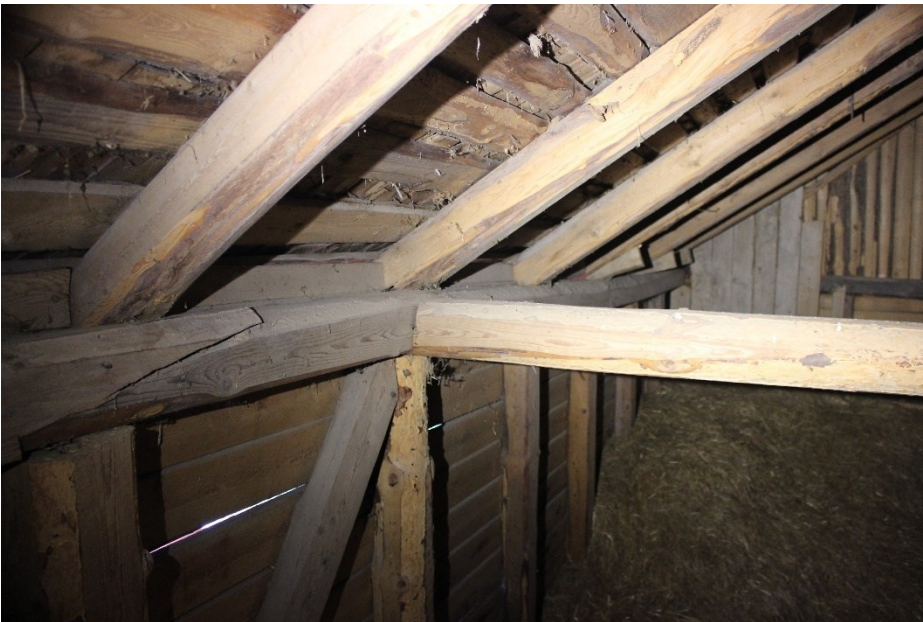
Kuva 31. Kohta, jossa rakennuksen tiilirunko vaihtuu puurungoksi.
