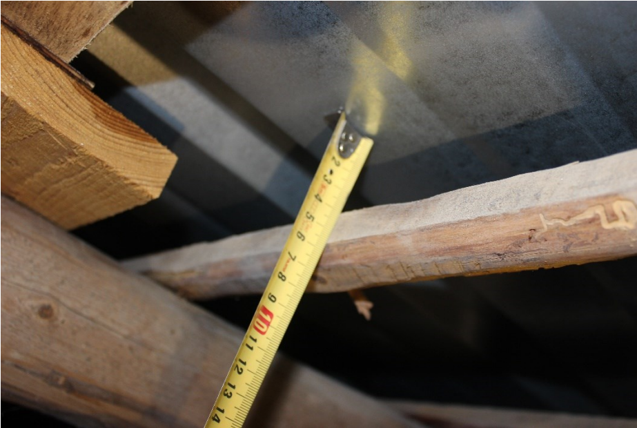
Kuva 37. Osa ruoteista on jopa 40 mm irrallaan kattuista.
