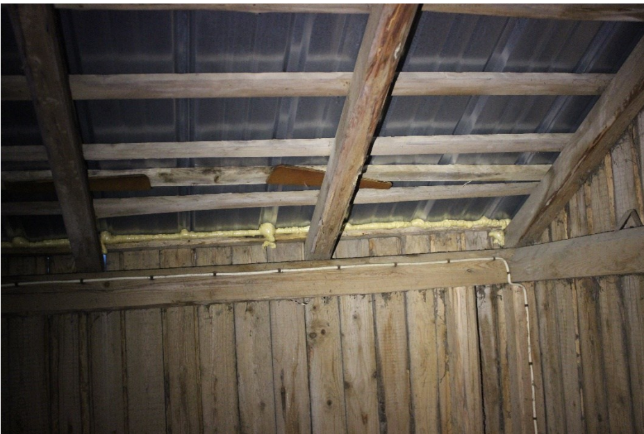
Kuva 39. Katteen ja ulkoverhouksen välinen rako on uretaanivaahdolla tiivistetty.
