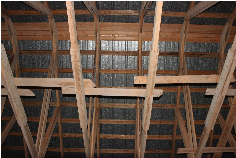
Kuva 14. Alapaarteen sivuttaistuenta.
