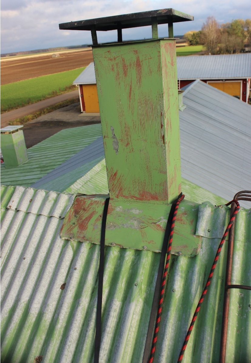
Kuva 21. Eteläpään ilmanvaihtohormi.
