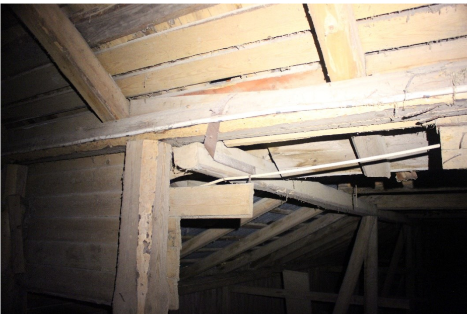
Kuva 44. Kattokannattajien tukipalkki länsipääty, pohjoispuoli.
