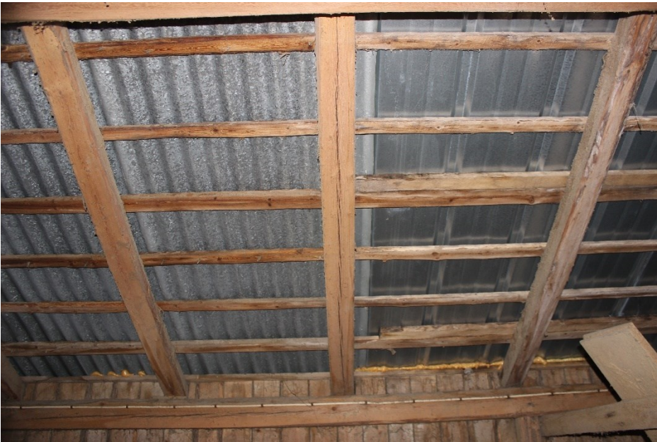
Kuva 33. Peltiprofiilin vaihdos alapuolelta.
