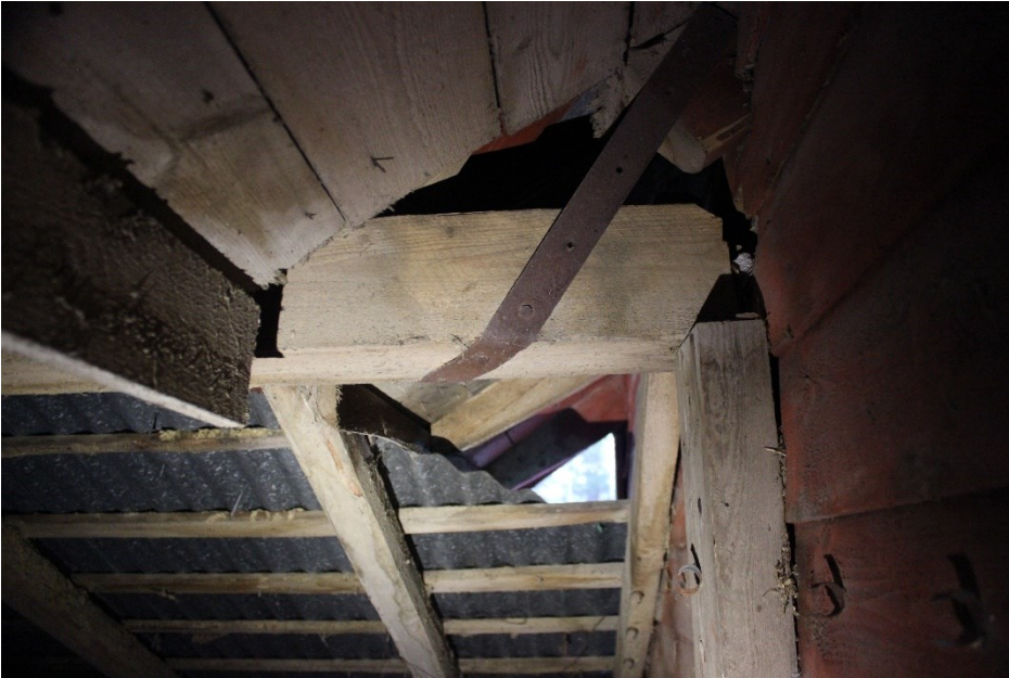
Kuva 43. Kattokannattajien tukipalkki länsipääty, eteläpuoli.
