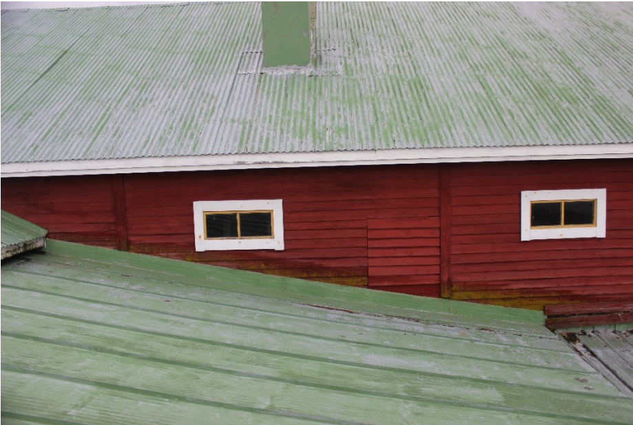
Kuva 26. Puutteelliset räystäskourut.
