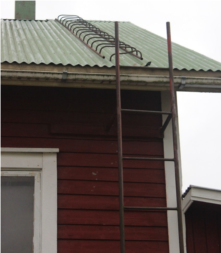
Kuva 28. Talotikas ja lapetikas.
