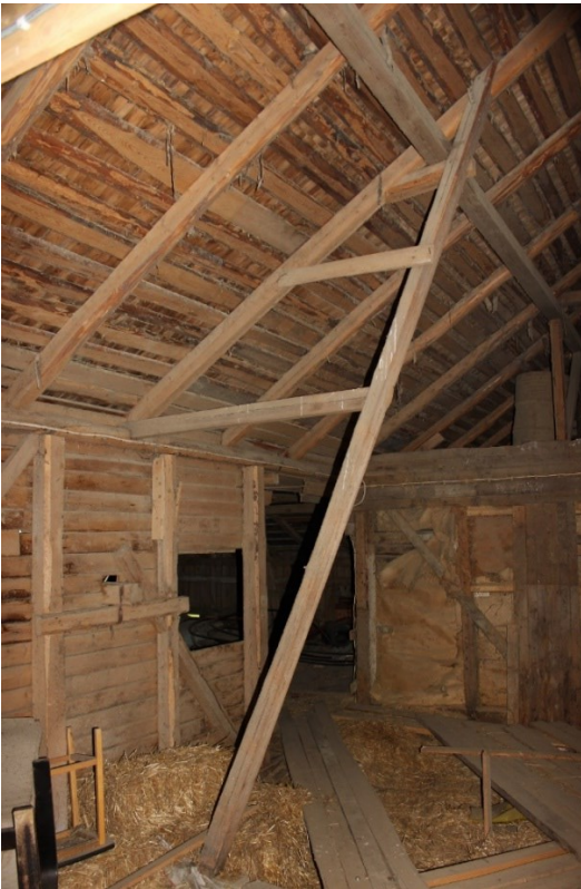
Kuva 29. Vesikattoa kantava rakenne.
