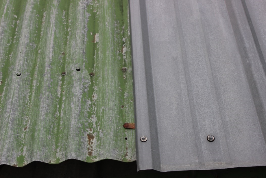
Kuva 34. Peltiprofiilin vaihdos yläpuolelta.
