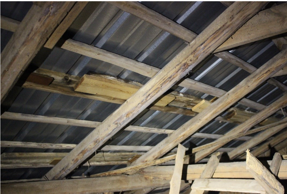
Kuva 36. Ruoteiden oikaisun vääränlainen toteutus.
