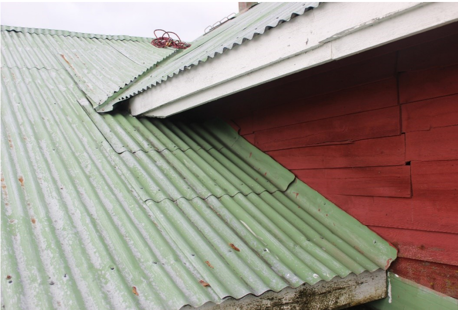
Kuva 42. Pitkittäinen rintataite.
