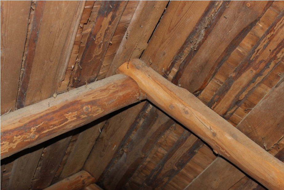
Kuva 30. Kattokannattajien harjaliitos.
