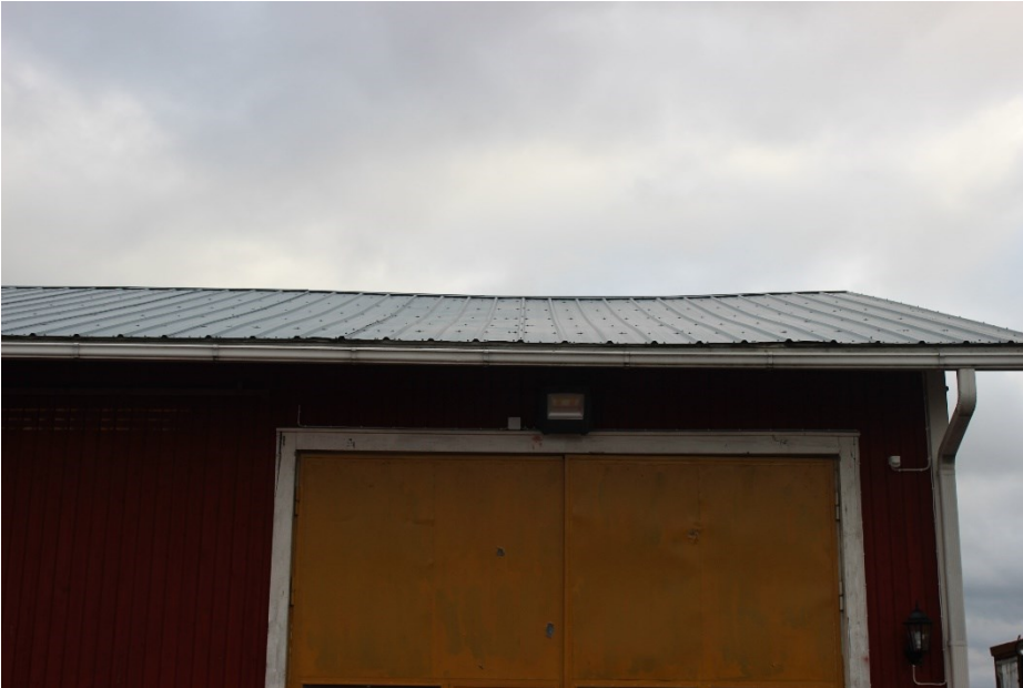
Kuva 16. Notko katossa pajaosan yläpuolella.
