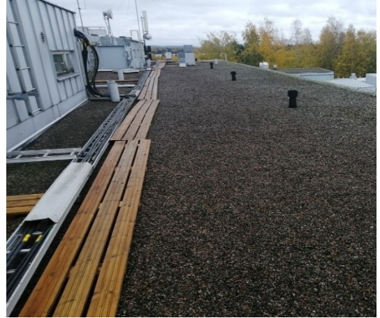
Kuva 59. Puset kulkusillat vesikatolla.
