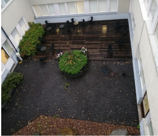
Kuva 11. Kunnostettu sisäpiha B1.
