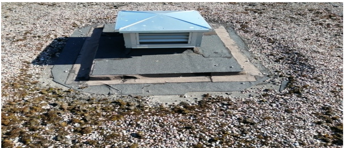
Kuva 70. Huippuimurin juuressa uusittu vesikate.
