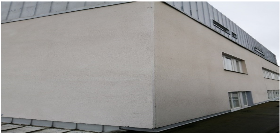
Kuva 47. Rappauspinta hyvässä kunnossa.
