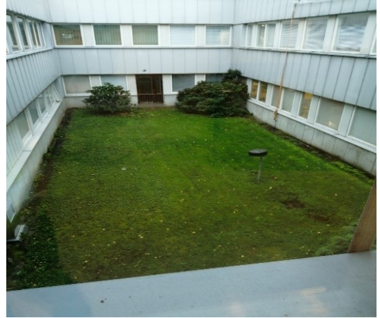
Kuva 12. Kunnostamaton sisäpiha B2.
