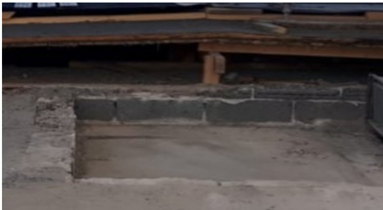
Kuva 46. Yläpohjan kantavat lekaharkot.
