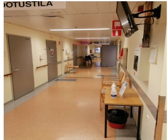
Kuva 88. B1, 2. kerroksen käytävä.
