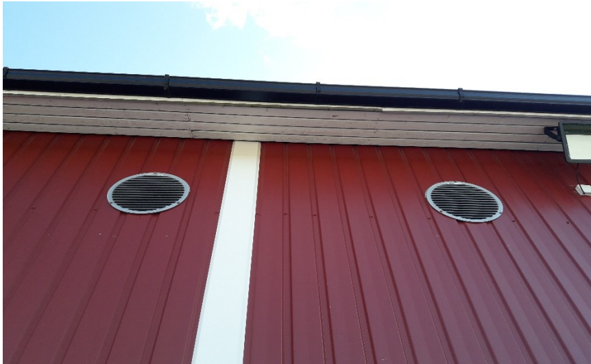
Kuva 6. Ulkoilmasäleiköt sijoitettuna suojaiseen paikkaan.
