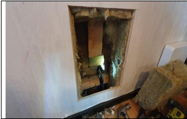
Kuva 7. Ulkoseinän rakenneavaus
