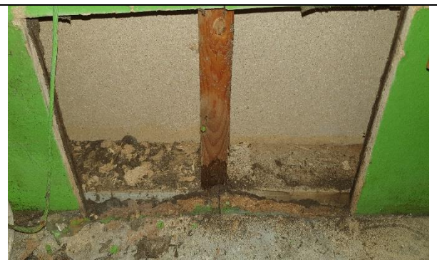
Kuva 28. Pesuhuoneen ja varaston välisen seinän avaus.
