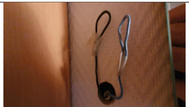
Kuva 35. Valaisimen johtimet ovat suojaamatta
