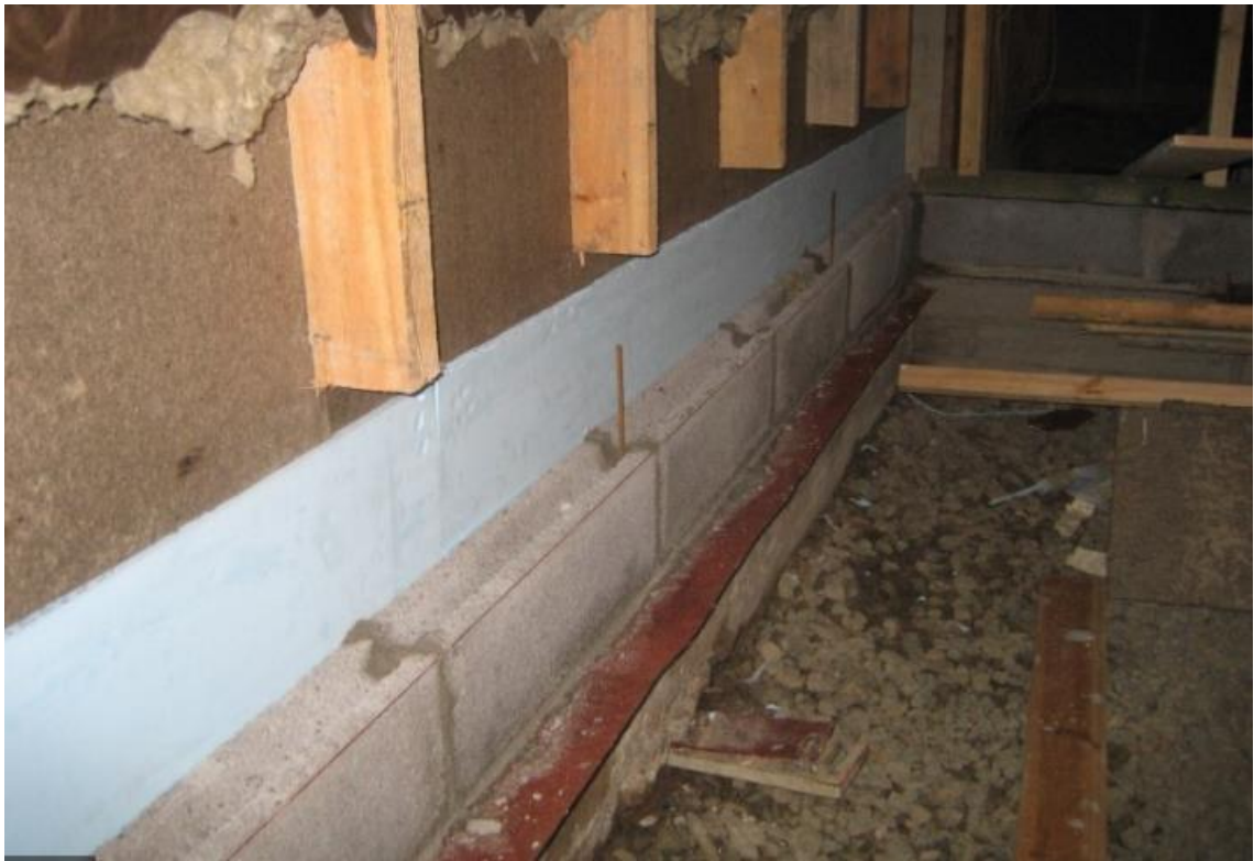
Kuva 7. Valesokkelin korjaus perinteisellä harkkomuurauksella. Kuvan kohteessa myös lattia on poistettu. (Hometalkoot 2016)
