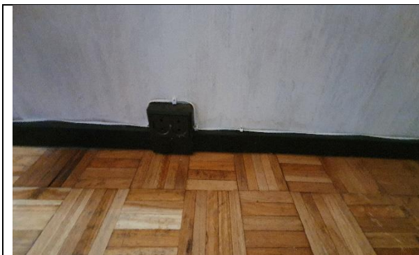
Kuva 34. Pinta-asenteiset sähkölinjat ulkoseinillä
