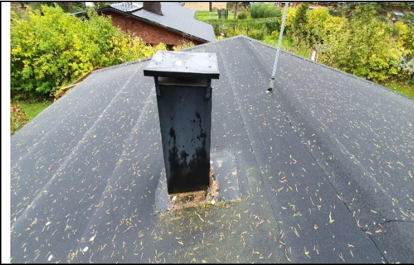
Kuva 15. Liesituulettimen poistoilmahormi
