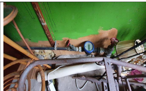
Kuva 27. Vesimittari
