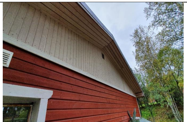
Kuva 10. Päätykolmioiden osalla puupaneelit on asennettu pystysuuntaisesti
