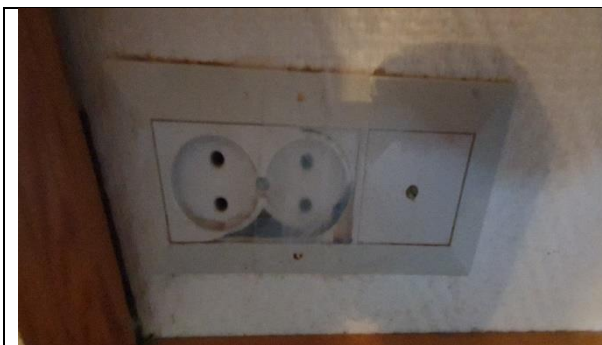
Kuva 32. Hajonnut pistorasia
