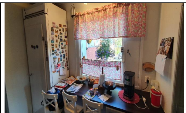
Kuva 22. Rakennusaikainen kylmiö tilan nurkassa
