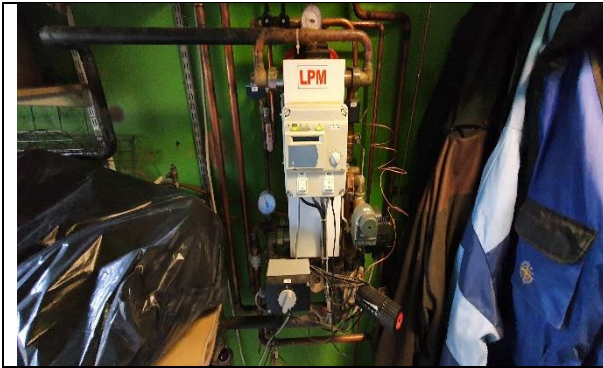
Kuva 25. Kaukolämmön lämmönsiirrin
