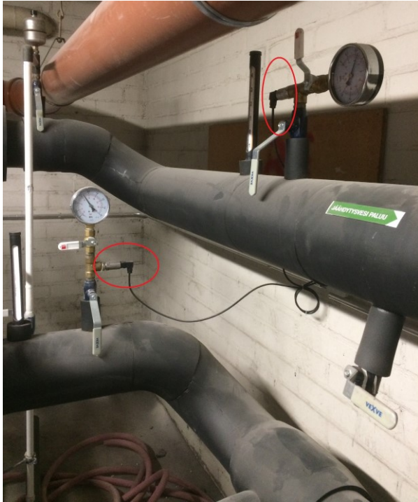
Kuva 27. Paineanturit mittaavat meno- ja paluuputkessa vallitsevaa painetta. Paineiden erotus on käytössä oleva paine-ero. Paineanturit ovat asennettu asiakkaan toimitusrajan puolelle.
