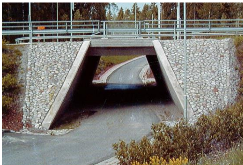
KUVA 10. Laattakehäsilta (Teräsbetoninen laattakehäsilta, 2017)
