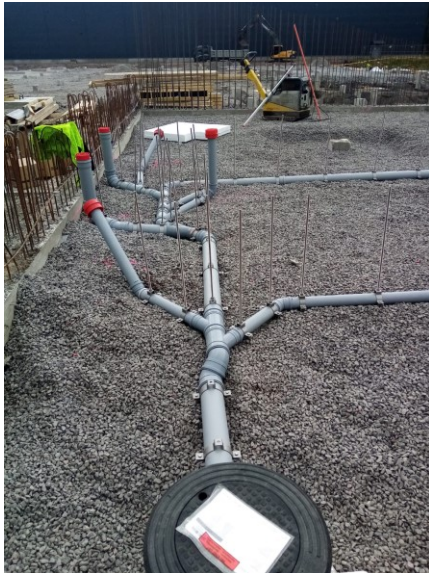
Kuva 6. Väestönsuojan pohjaviemärit toteutusvaiheessa.
