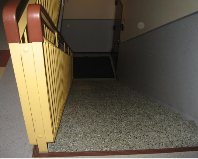
KUVA 14. Porraskäytävä (Valokuva Minna Jaakkola 2010)
