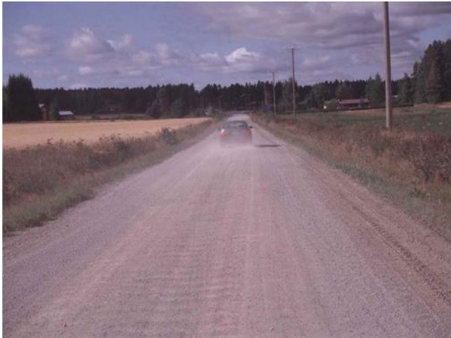
KUVA 7. Kuntoluokka 3: tie pölyää vähäisesti (7, s. 19)
