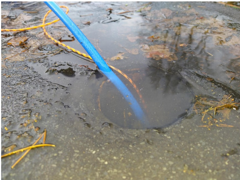
Kuva 19. Vettä lisätään kuvan tasoon saakka, hieman katon puolelle.
