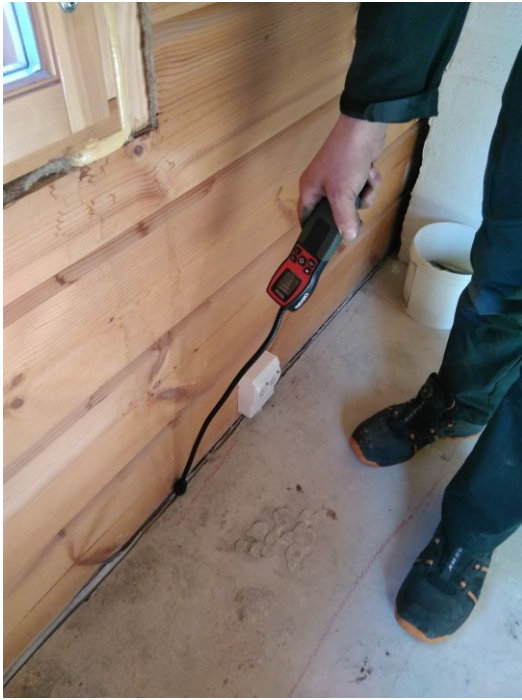
Kuva 23. Rakoa betonissa tutkitaan kaasuanturilla.
