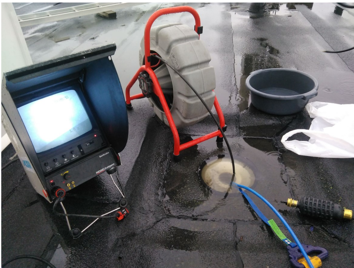
Kuva 17. Padotetun kattokaivon kuvaus.
