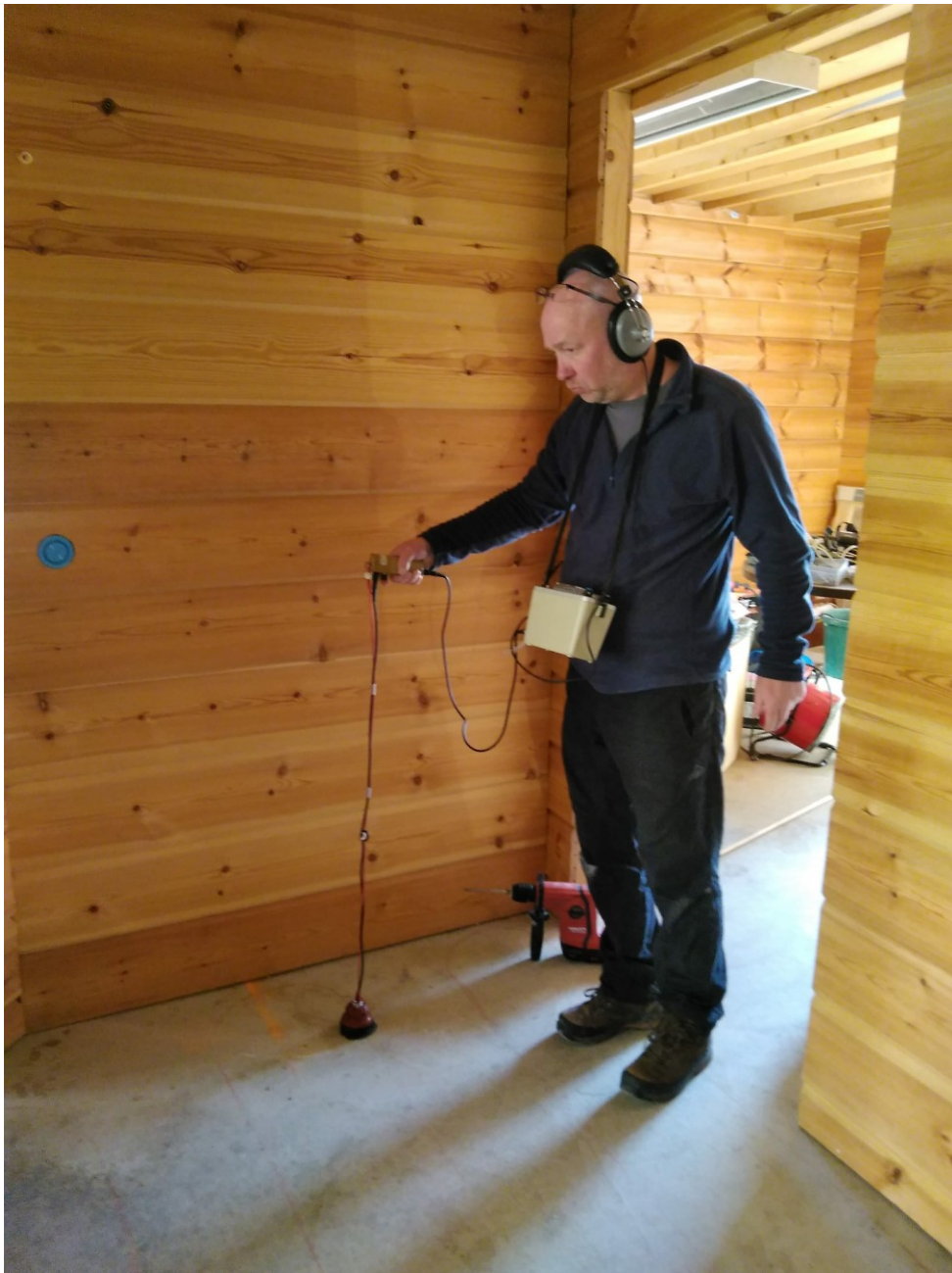
Kuva 9. Lattialämmityksen vuodon kuuntelua lattia-anturilla.
