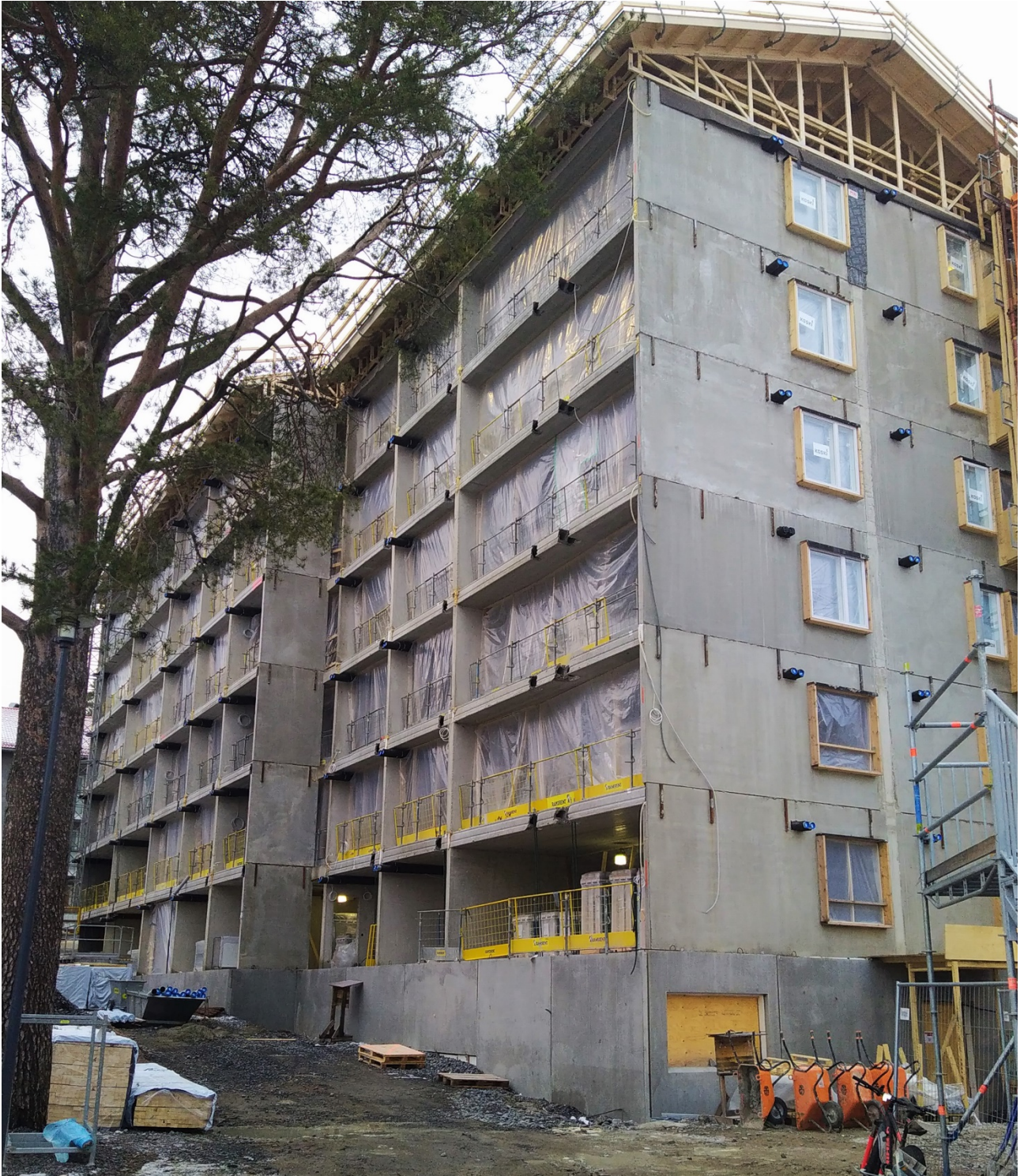
KUVA 1. Rakennustyömaa (kuva: Lauri Keränen)
