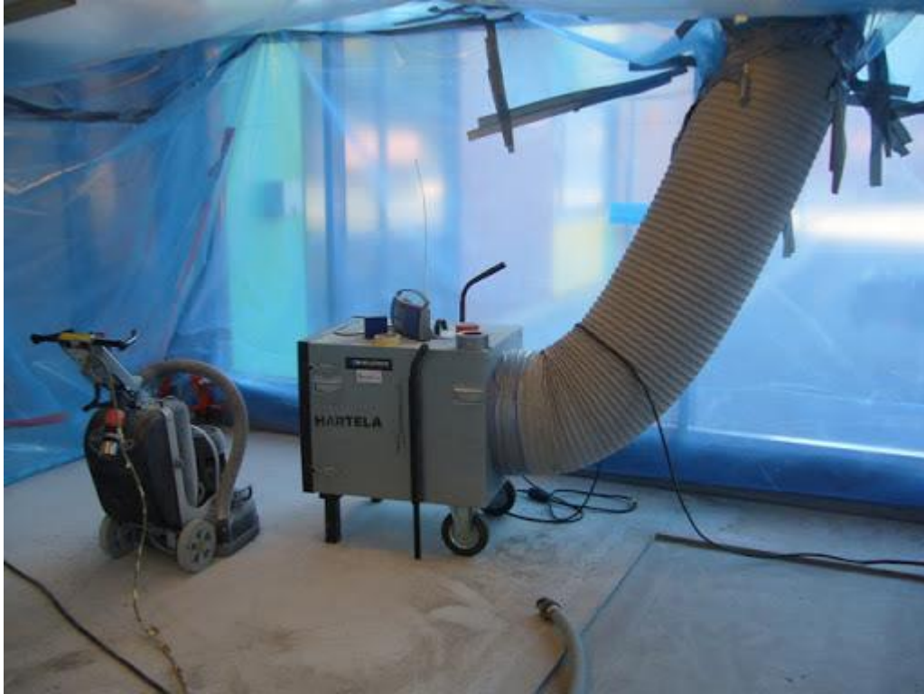
Kuva 5. Alipaineistus asennettu osastoituun tilaan (Lindrak Oy.)
