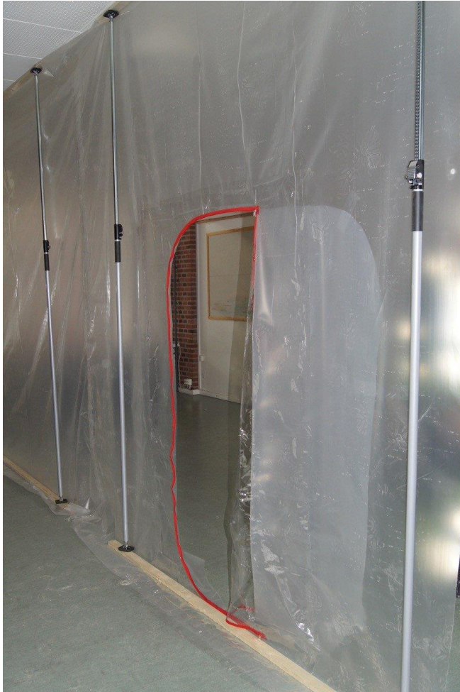
Kuva 4. Osastoitu tila (Rakennuskone Oy.)
