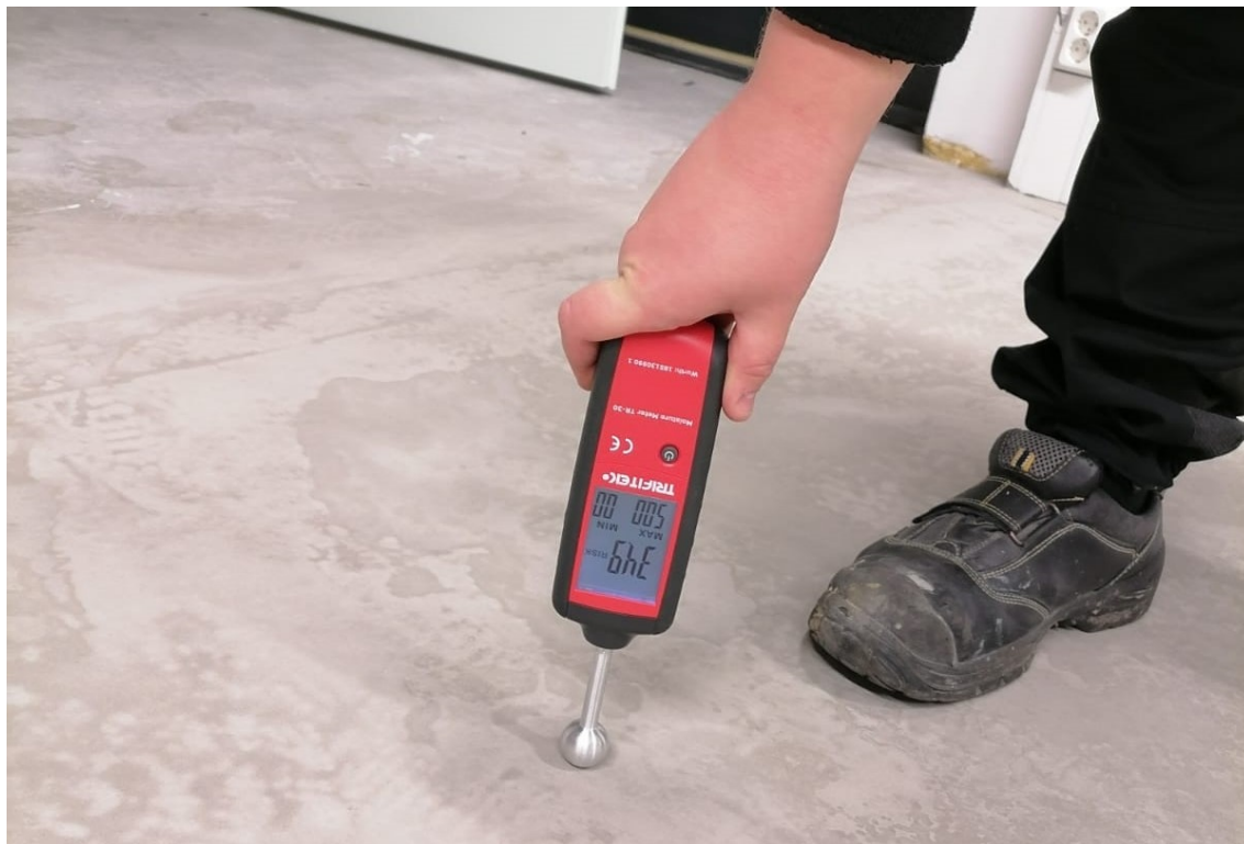
Kuva 4. Lattian kosteuden mittaaminen
