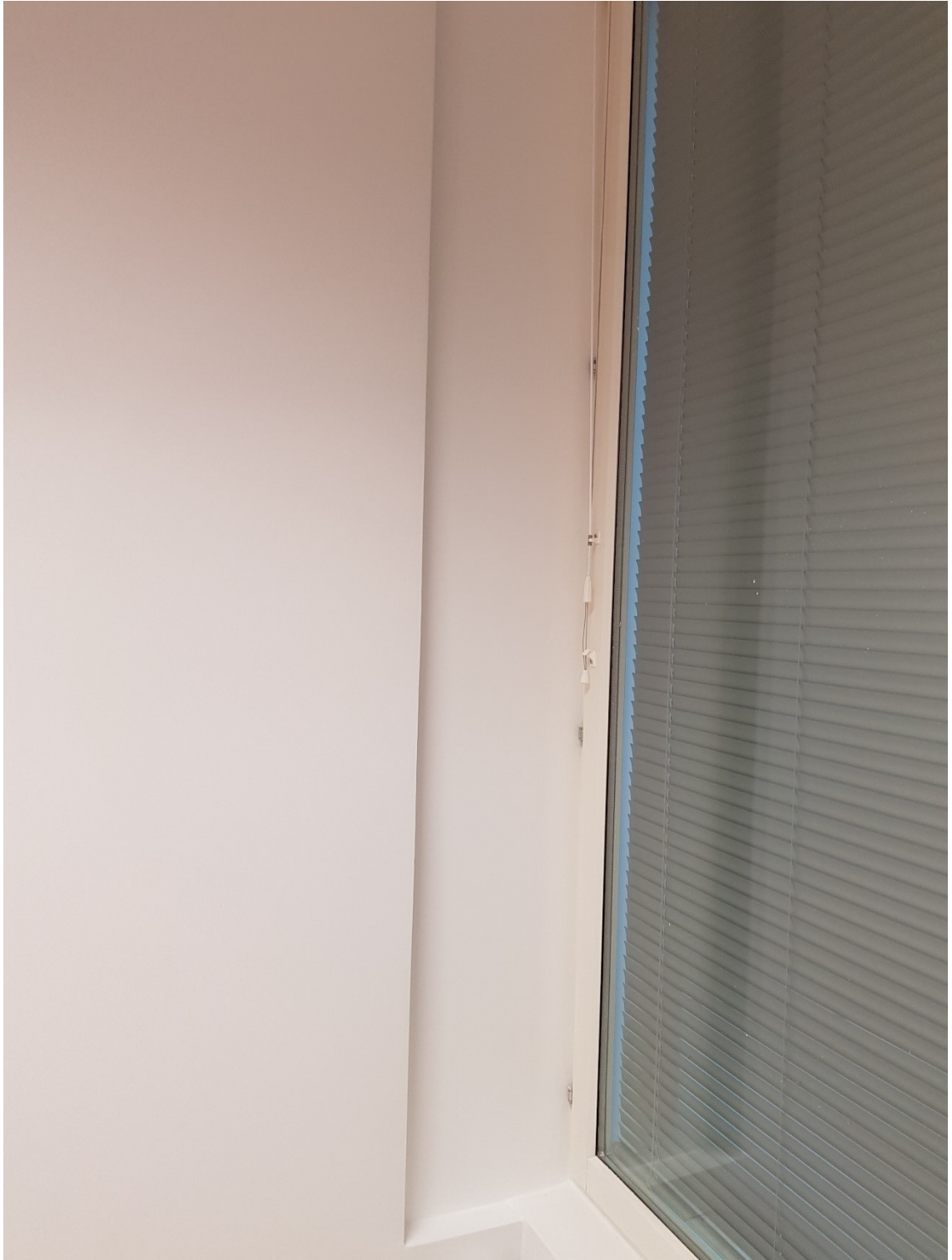
Kuva 5. 10mm:n teräslevy asennettuna ikkunoiden ja väliseinän väliin.
