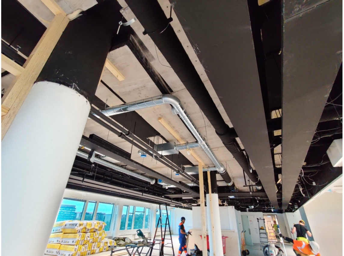
Kuva 6. Katosta poistettujen ääneneristysvillojen paikat ennen pölynsidontamaalausta
