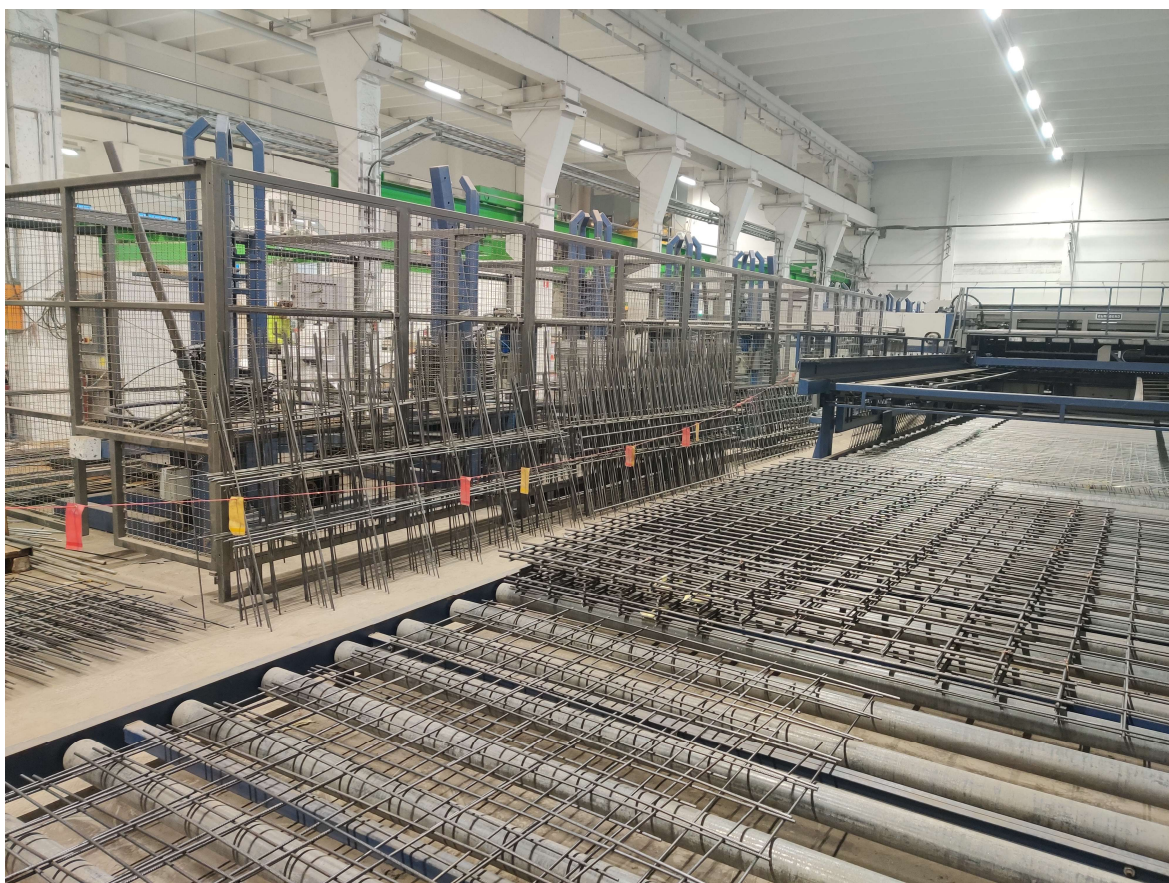
Figur 6. Bilden visar framställningen av armeringsnät med hjälp av en maskin som svetsar ihop armeringsstänger. Armeringsstängerna är ihoprullade och sedan matas de in i maskinen. Maskinen klipper och svetsar ihop armeringsstängerna enligt modellen. Modellen ritas upp så att alla armeringar placeras ut enligt längder och dimensioner (Jansson, 2020).
