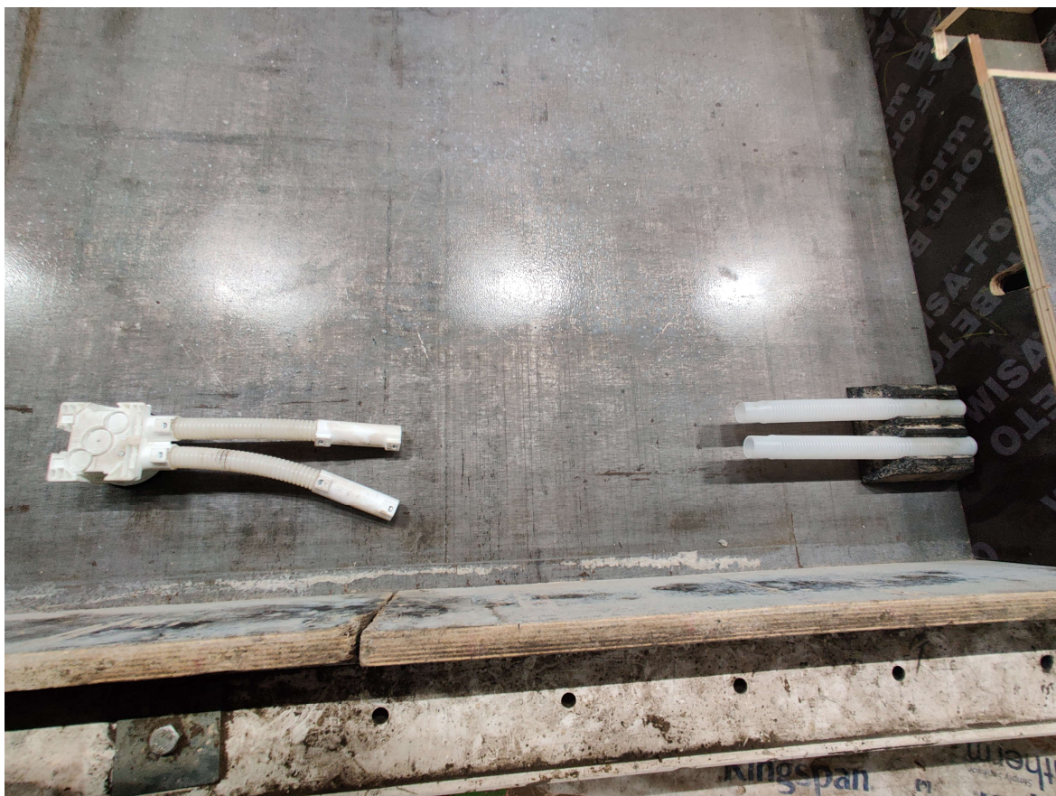
Figur 3. Förberedelseskedet där eldosor har placerats i botten med hjälp av magneter (Jansson, 2020).
