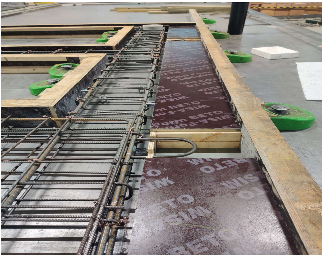
Figur 4. Armeringsprocessen av ett element. För att få rätta armeringsavstånd används distansklossar (Jansson, 2020).
