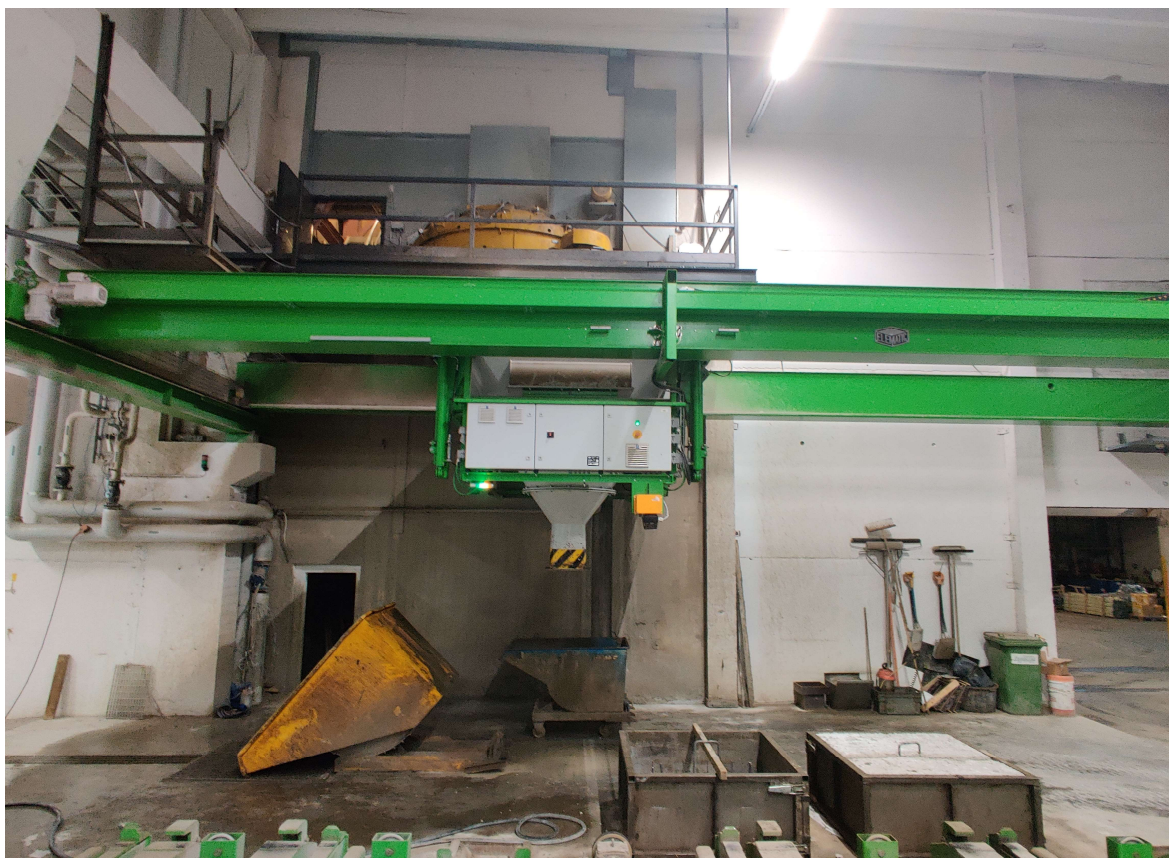
Figur 8. När betongen är blandad förs den ut i den y-formade behållaren. Behållaren manövreras trådlöst och har en lucka nertill som går att öppna och stänga (Jansson, 2020).
