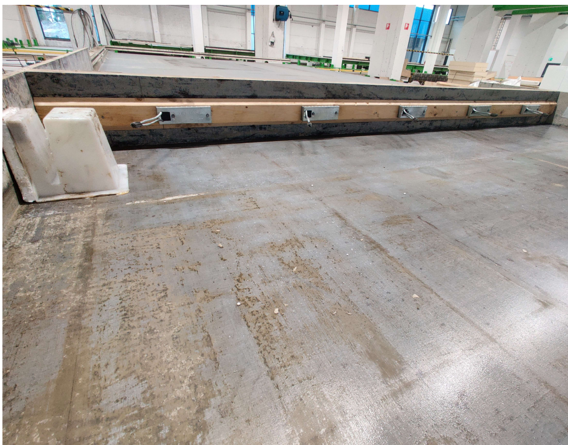
Figur 2. Förberedelseskedet där klossar gjorda av plast samt vajerlänkar har placerats. Före oljningen av formen limmar man plastklossarna i botten. Orsaken är att limmet fungerar dåligt när den blandas med formoljan. Brädan i vilken vajerlänkarna är fastspikade på läggs efter oljan för att oljan inte skall komma på vajrarna (Jansson, 2020).
